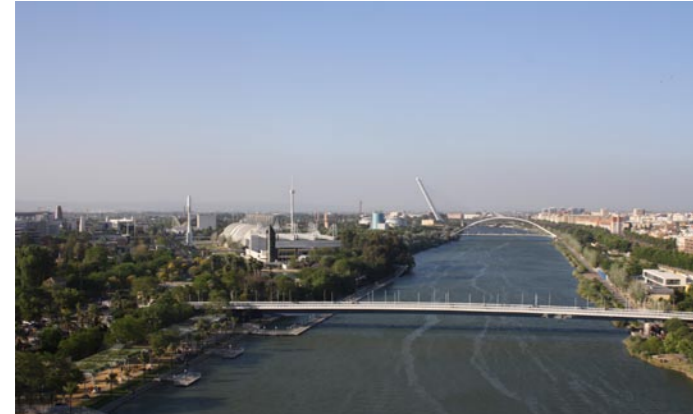
Puente de la Barqueta 66
