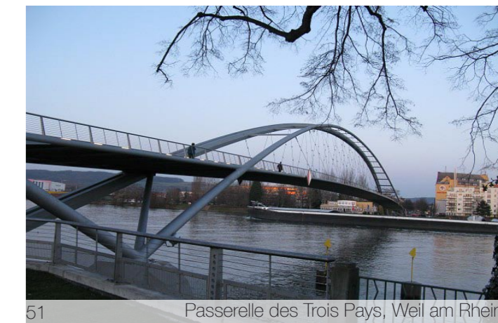
51 Passerelle des Trois Pays, Weil am Rhein
