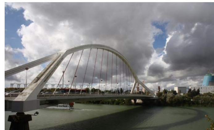
Puente de la Barqueta 68
