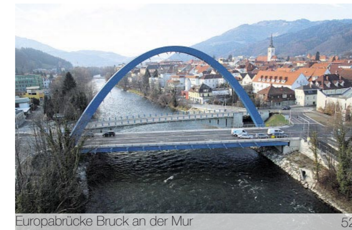
Europabrücke Bruck an der Mur 52
