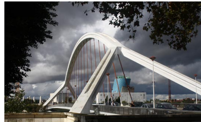
Puente de la Barqueta 67
