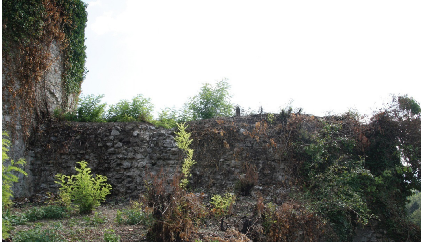
Abb.33 Die Ringmauer ,Nord-West Seite, Außenwand
