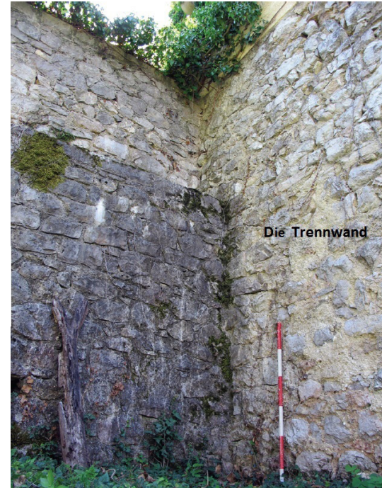
Abb.91 Trennwand zwischen Innenhof (R) und Innenhof (Q)
