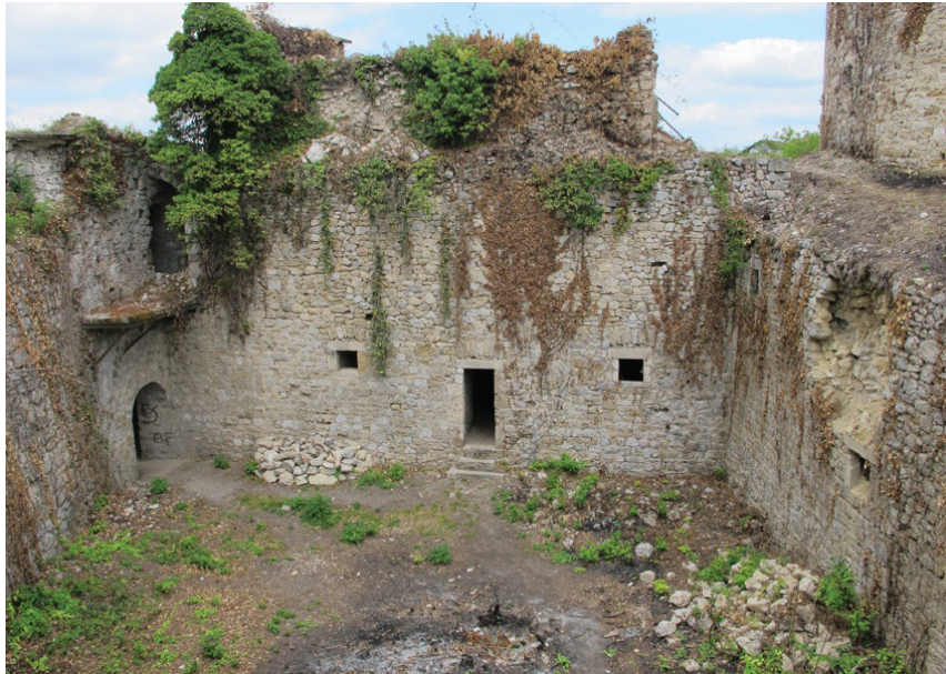
Abb.60 Objekt (C) Süd-Ost Seite, Objekt (B) Süd- West Seite
