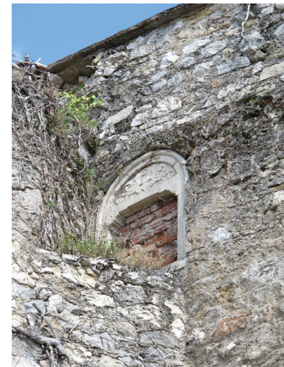
Abb.48 Bastion (E), Nord-West Seite , Fenster in der zweiten Etage- Ansicht von Außen
