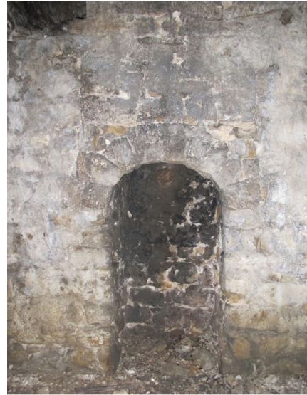
Abb.67 Objekt (C), Nord-Ost Seite, Kamin
