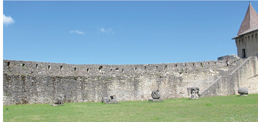
Abb.99 Ringmauer im Richtung Norden zum Bastion (L)
