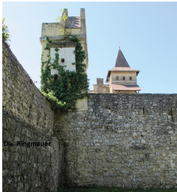
Abb.90 Ringmauer, Ost-Süd Seite , Trennwand der Innenhöfe (Q) und (R)
