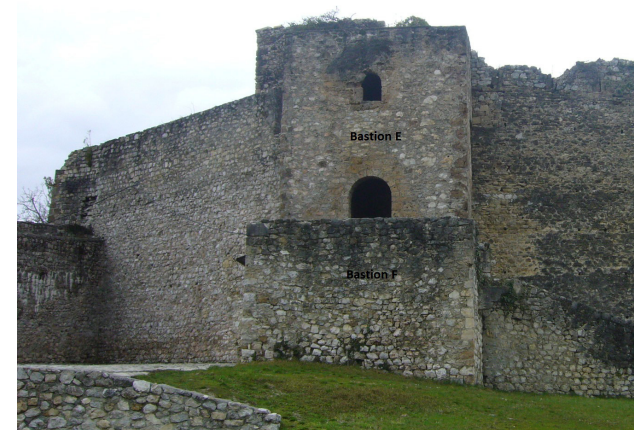
Abb.35 Bastion (F und E) , Süd Seite, Ansicht von Außen
