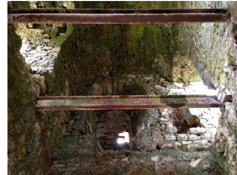
Abb.53 Bastion (E) , Rundbogendecke
