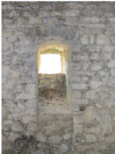
Abb.65 Objekt (C), Süd-Ost Seite, Fenster- Ansicht von Innen
