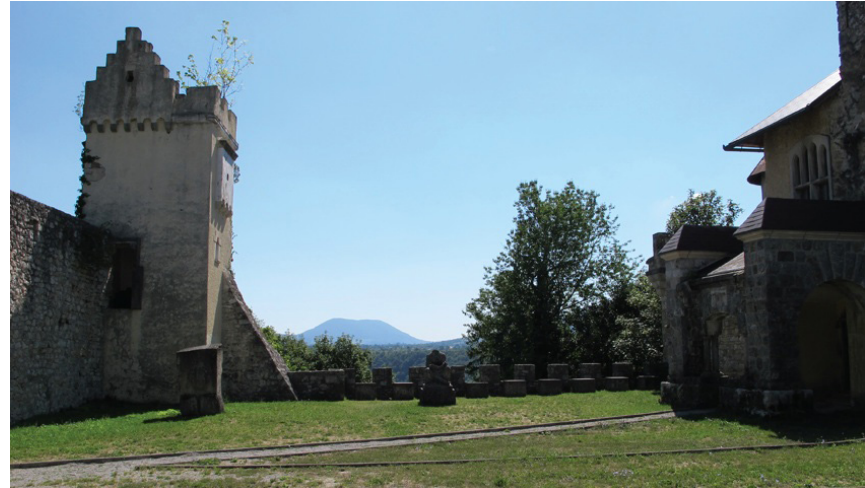
Abb.95 Innenhof (R), Ost Seite, Außenwand, Ansicht von Innen
