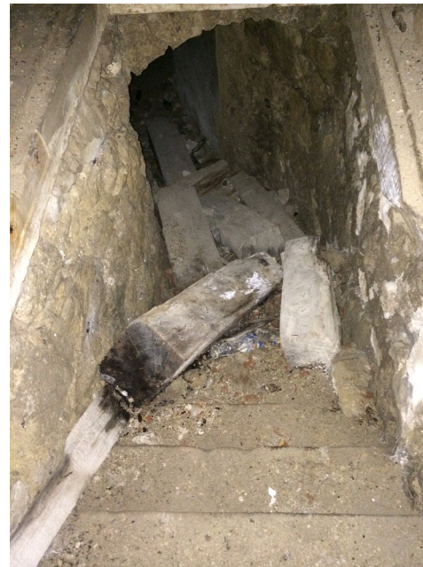
Abb.121 Eingang zur Keller Süd
