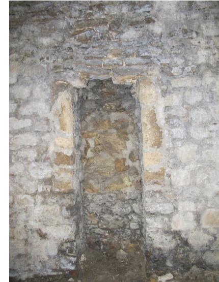
Abb.68 Objekt (C), Süd-West Seite, Kamin
