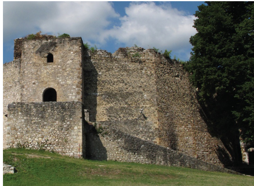
Abb.54 Bastion (E), Außenwand der Süd-Ost Seite
