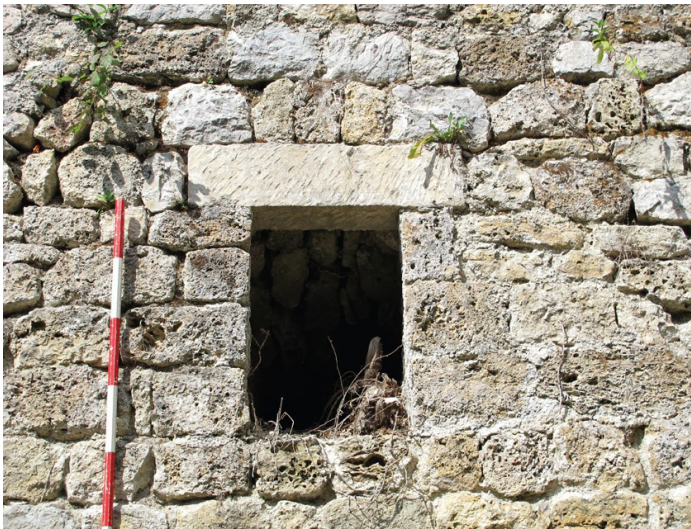
Abb.77 Objekt (B), Süd-West, Außenwand Fenster
