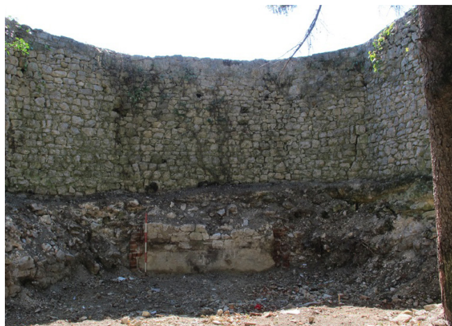
Abb.86 Bastion (H), Süd-Ost Seite Innenwand
