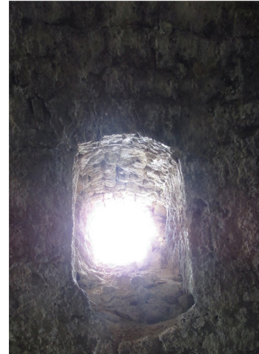
Abb.72 Objekt (B),West Raum-Ansicht von Innen
