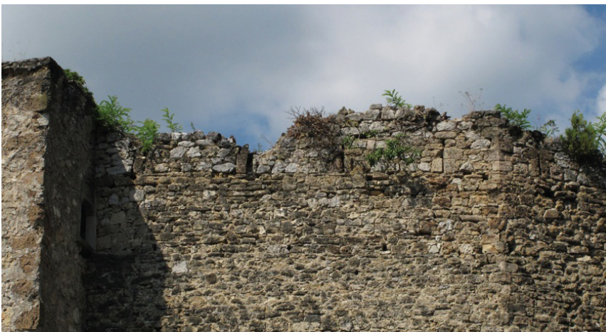
Abb.56 Ringmauer Süd-Ost Seite, Außenwand
