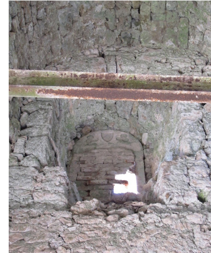
Abb.46 Bastion (E), Nord-West Seite , ein Fenster im zweiten Etage- Ansicht von Innen
