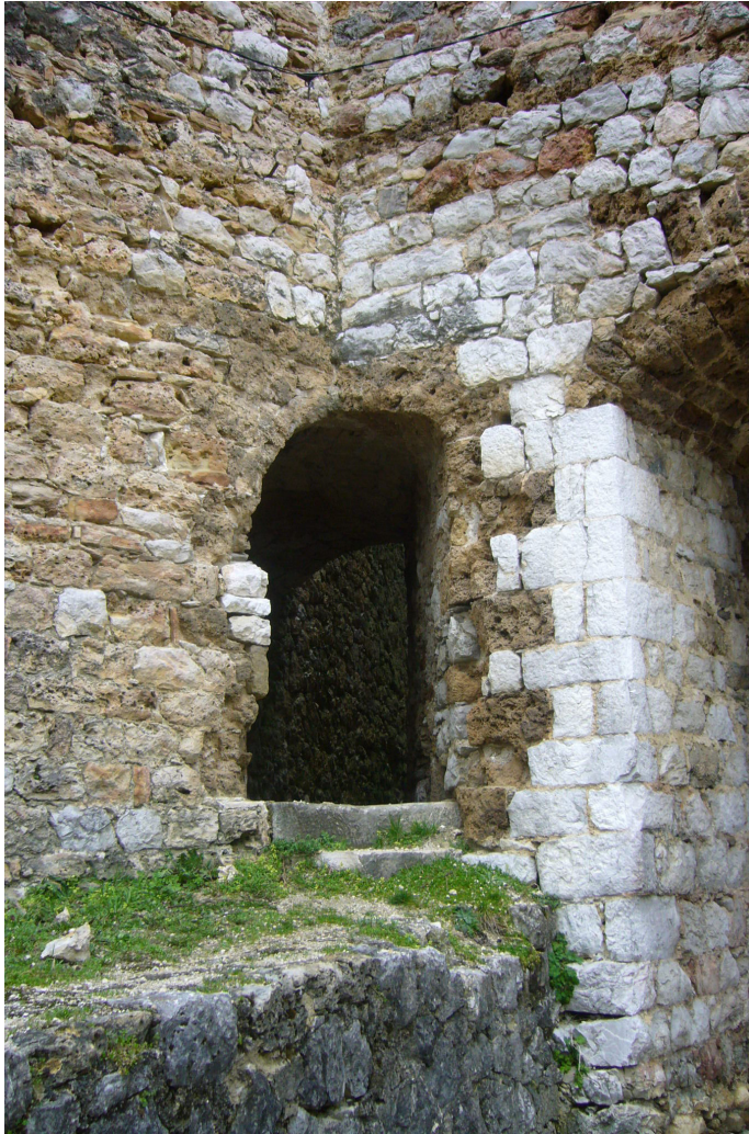
Abb.106 Bastion (G), Süd-West Seite, Eingang
