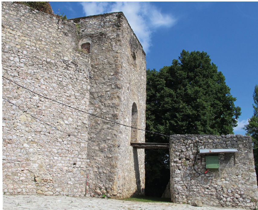
Abb.34 West Seite, Hängebrücke zwischen Bastion (E und F)
