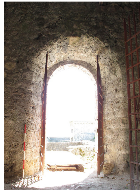
Abb.40 Bastion (E), Süd-West Seite, Innenwand Eingang
