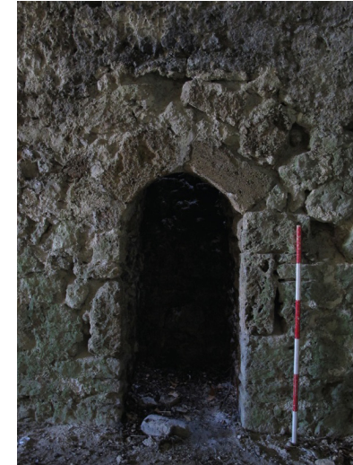
Abb.73 Objekt (B), West Raum –Ansicht von Innen Kamin
