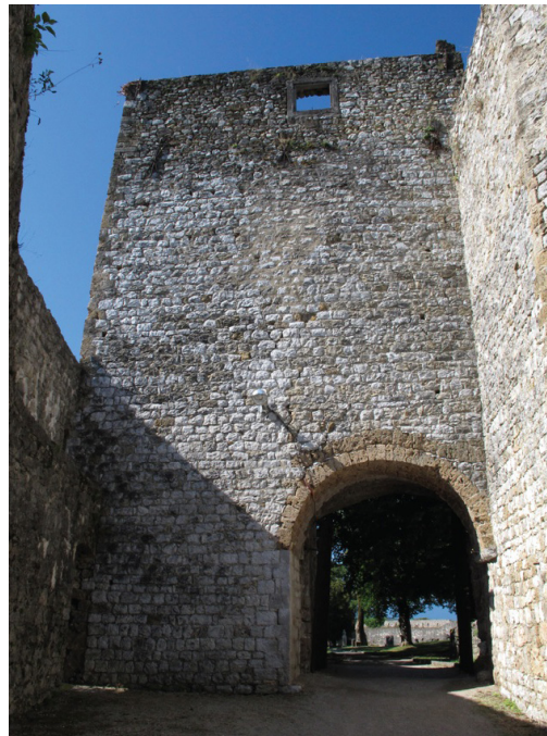
Abb.82 Bastion (G), Nord - Ost Seite, Außenwand Eingang
