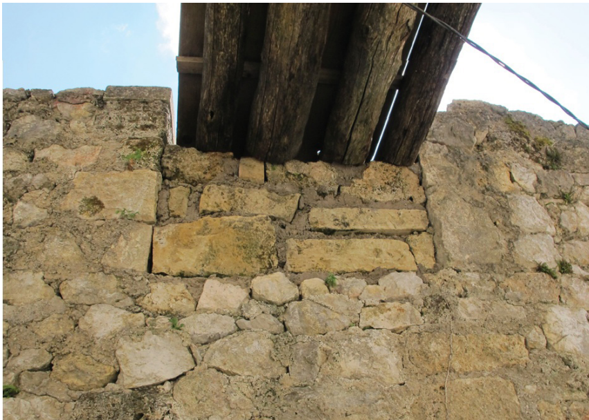
Abb.38 Bastion (F), Nord Seite, der alte und neu Niveau von Hängebrücke
