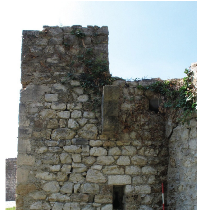
Abb.36 Bastion (F), Süd-Ost Seite, Außenwand
