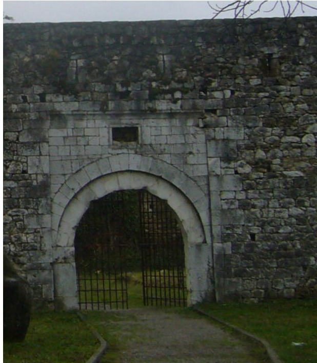
Abb.93 Innenhof (R), Nord Seite, Außenwand Eingang
