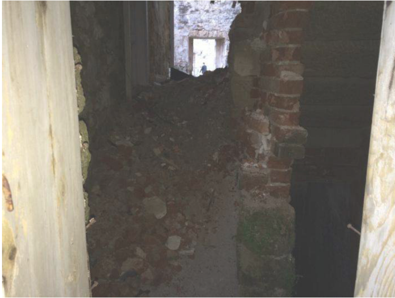
Abb.122 Eingang zu Keller West
