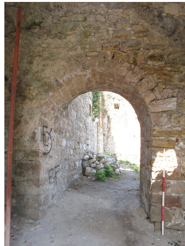
Abb.44 Bastion (E), Nord-Ost Seite, Eingang in das Innenhof (D)
