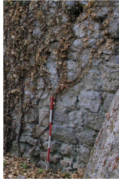
Abb.57 Zwingermauer (D) Nord-Ost Seite
