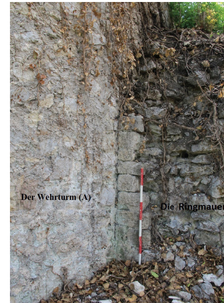
Abb. 31 Die Ringmauer, Außenwand Nord-West Seite lehnt sich an den Wehrturm (A)
