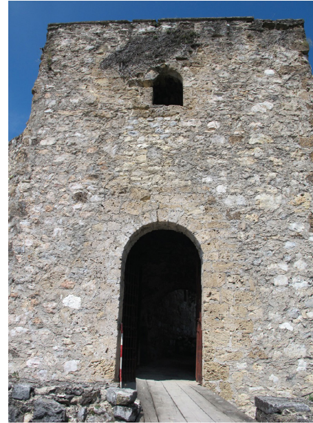
Abb.39 Bastion (E), Süd-West Seite, Außenwand Eingang
