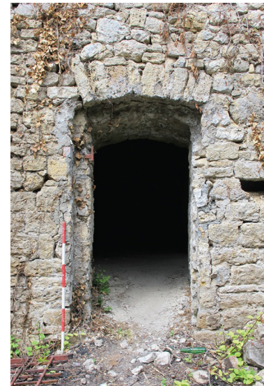
Abb.74 Objekt (B),Süd -West Seite, Außenwand Eingang
