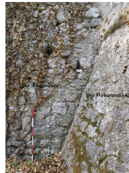
Abb.32 Die Ringmauer, Außenwand Süd-Ost lehnt sich an den Wehrturm (A)
