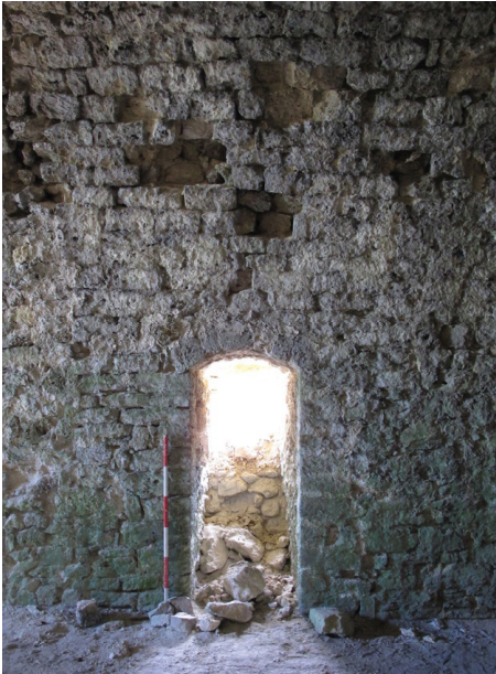
Abb.76 Objekt (B), Süd-West Seite, Innenwand Fenster
