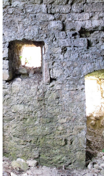
Abb.78 Objekt (B), Süd-West Seite, Innenwand Fenster
