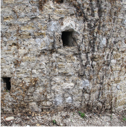
Abb.28 Der Wehrturm (A), Süd-West Seite, Ansicht von Außen
