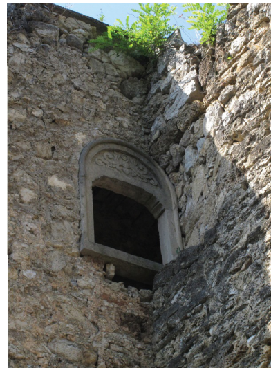
Abb.47 Bastion (E), Süd-Ost Seite, ein Fenster auf der zweiten Etage- Ansicht von Außen
