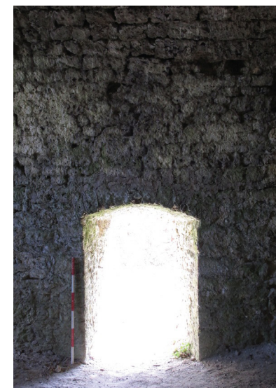
Abb.75 Objekt (B), Süd-West Seite, Innenwand Eingang
