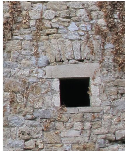
Abb.66 Objekt (C), Süd-Ost Seite , Fenster Ansicht von Außen
