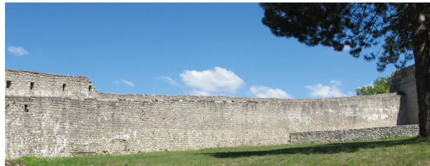
Abb.105 Ringmauer, West Seite, zwischen Bastion (L) und Innenhof (D) Ansicht von Innen
