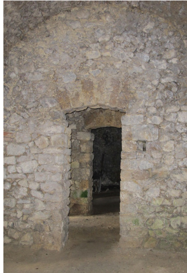
Abb.64 Objekt (C), Ansicht von Innen
