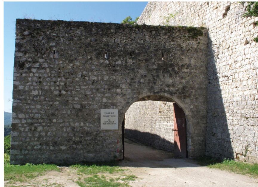
Abb.80 Zwinger (P), Nord Seite, Außenwand Eingang
