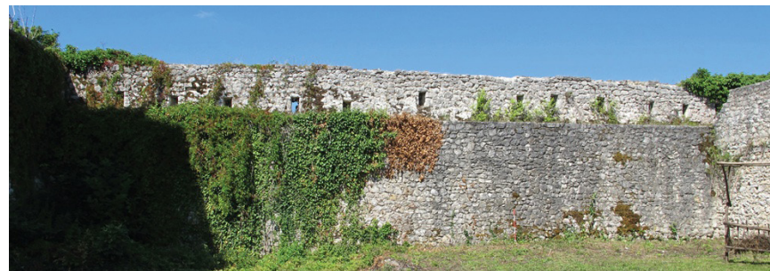
Abb.96 Innenhof (R), West Seite Außenwand, Ansicht von Innen
