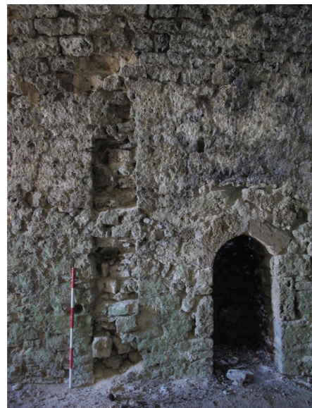
Abb.71 Objekt (B), West Seite, Überreste einer Trennwand
