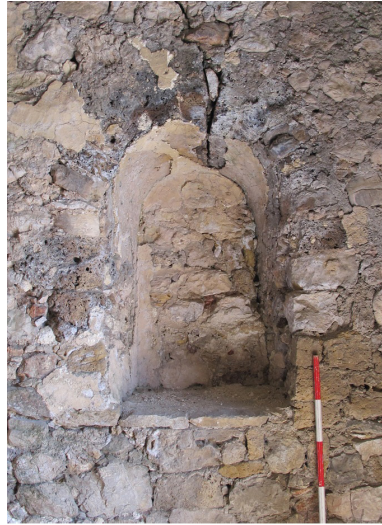
Abb.42 Bastion (E), Außenwand Süd-Ost Seite, Ansicht von Innen
