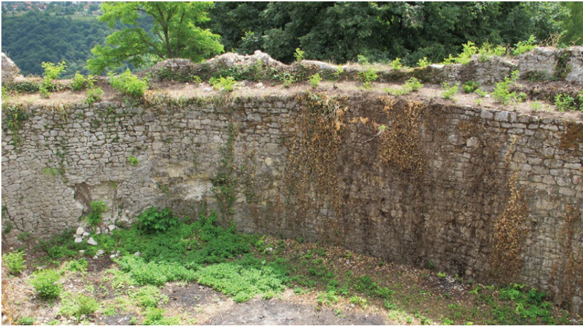
Abb.55 Innenhof (D), Innenwand Süd-Ost Seite, Ansicht von Innen
