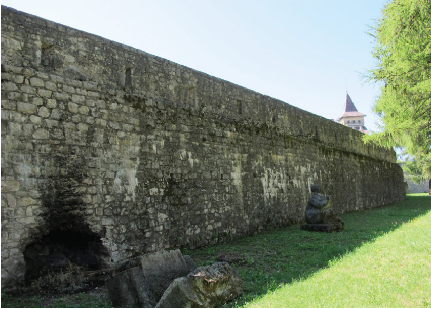
Abb.89 Ringmauer, Ost Seite, Innenwand
