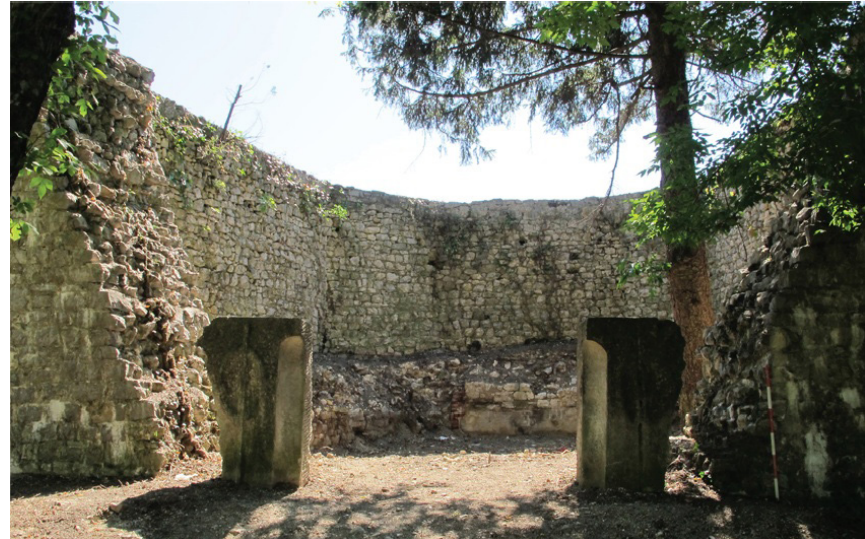
Abb.87 Bastion (H), Süd-Ost Seite , Innenwand
