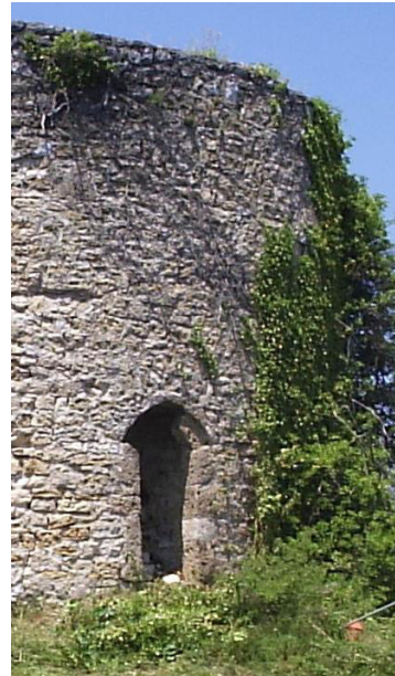
Abb.26 Der Wehrturm (A), Detail des südlichen Eingangs
