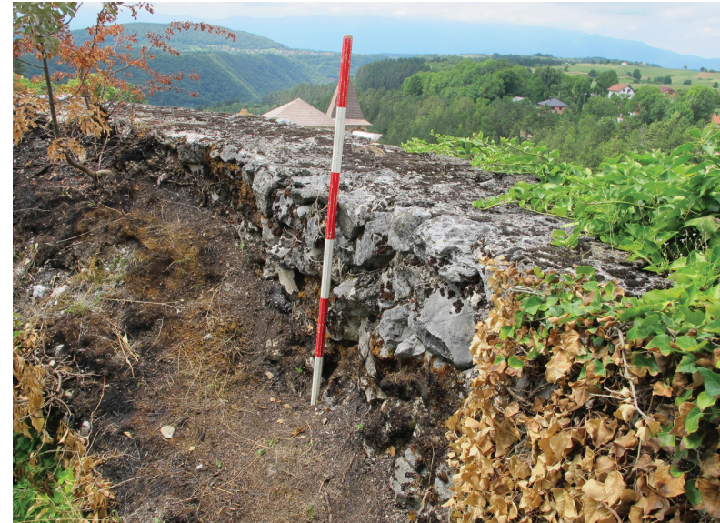
Abb.27 Der Wehrturm (A), Ansicht von Innen
