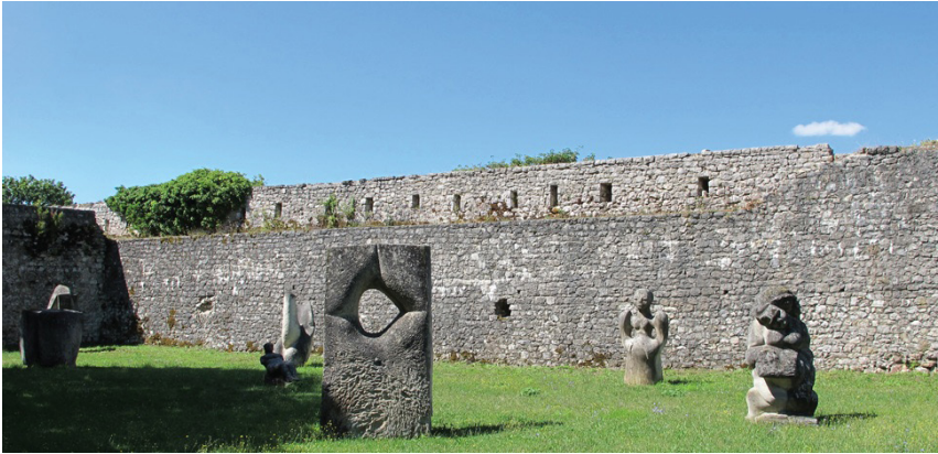
Abb.97 Trennwand zwischen den Innenhöfen (Q) und (R)
