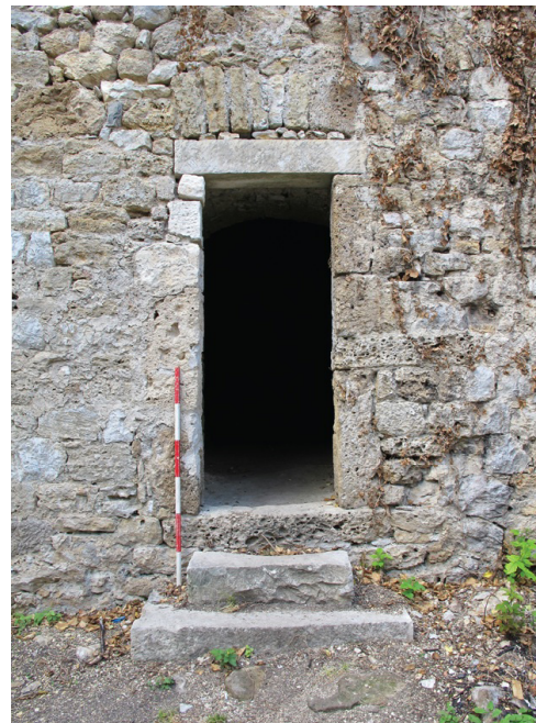
Abb.63 Objekt (C) Süd-Ost Seite, Außenwand Eingang
