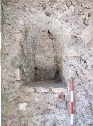
Abb.41 Bastion (E), Außenwand Nord-West Seite, Ansicht von Innen
