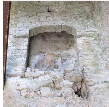
Abb.52 Bastion (E), Nord-West Seite , Außenwand Kamin- Ansicht von Innen
