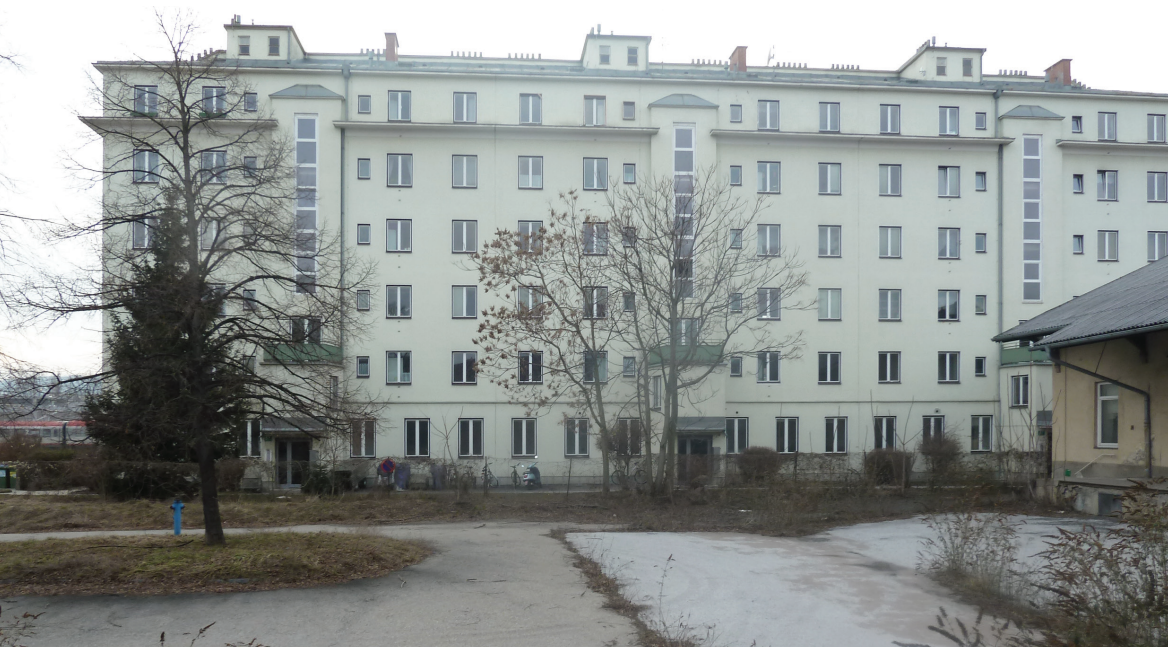
7 ^ Wohngebäude westlich des Zollamts
