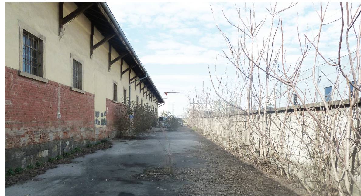
13 ^ 'Rückseite' des Zollamts mit Blick Richtung Norden
