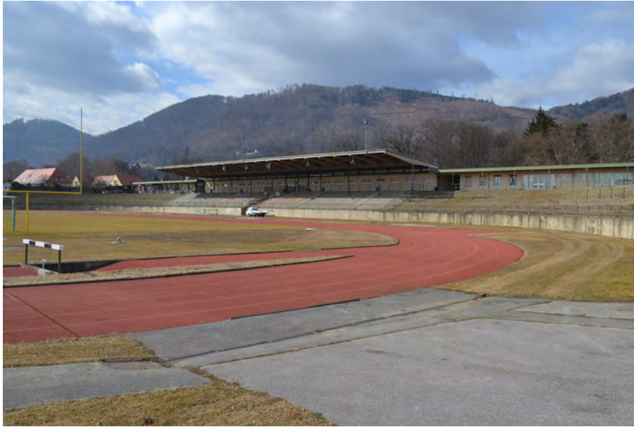
Abb. 21: Blick auf die Tribüne aus nordöstlicher Richtung
