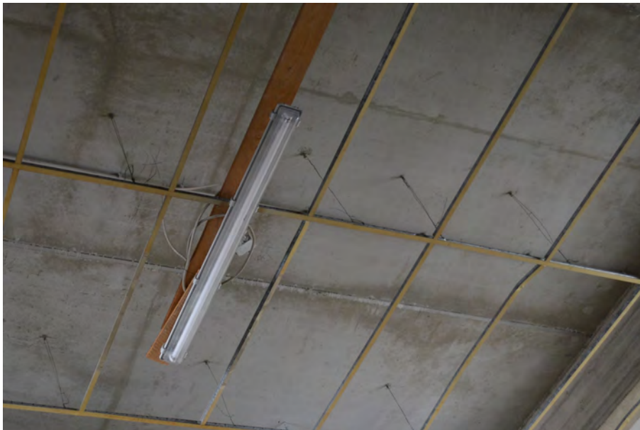
Abb. 13: Deckenbereich im Vorbereich der Halle B
