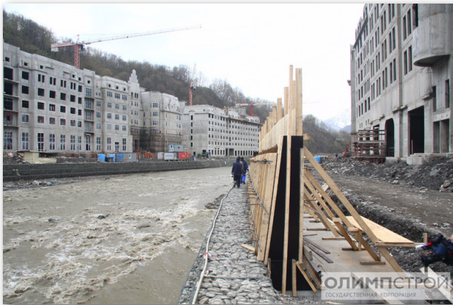
//////////////////// ABB 47 Schutzmauer gegen Hochwasser
