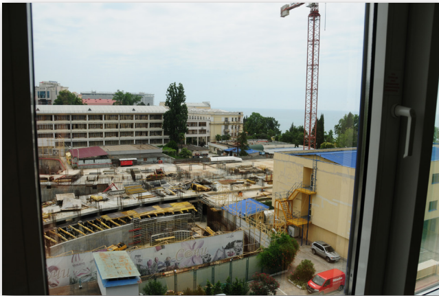
////////////////////ABB 51 stillgelegte Baustelle eines Hotels
