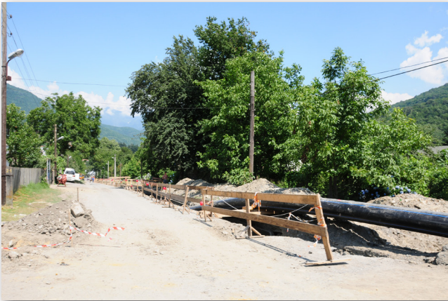
//////////////////// ABB 48 Baustelle in Krasnaja Poljana
