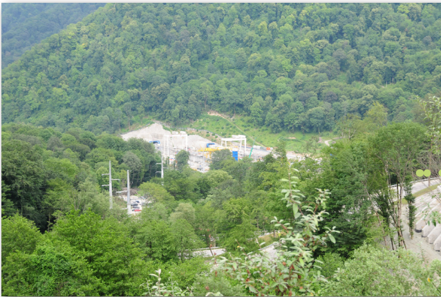
//////////////////// ABB 49 Baustelle für den Tunnel durch das Msyntatal
