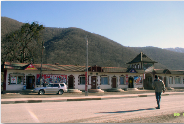
//////////////////// ABB 83 Bestandsgebäude im Süden
