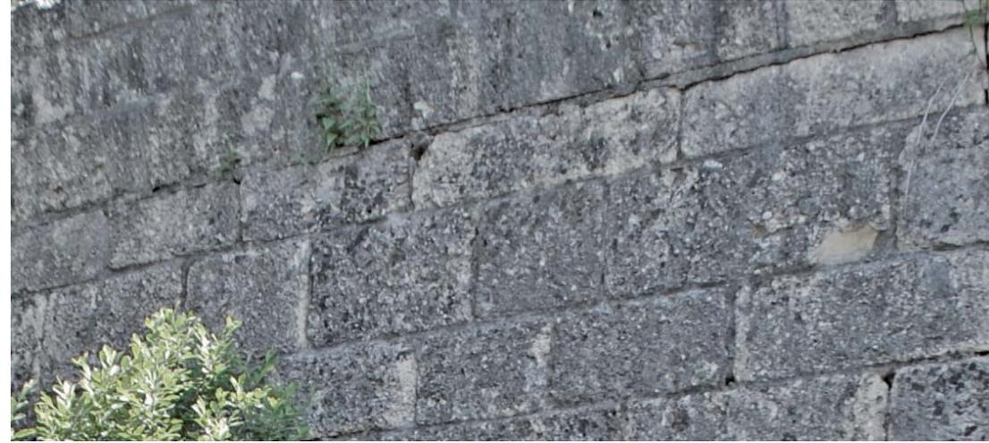
① Stützmauer Bestand: Betonmauer mit vorgeblendeten Steinen
