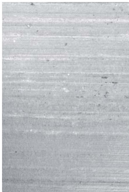
② Abb.63. Ortbetonbauweise mit Bürstenstrichen
