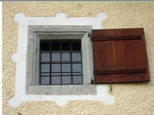
Foto Nr. 60: Fenster mit abgeschlagener Sohlbank
