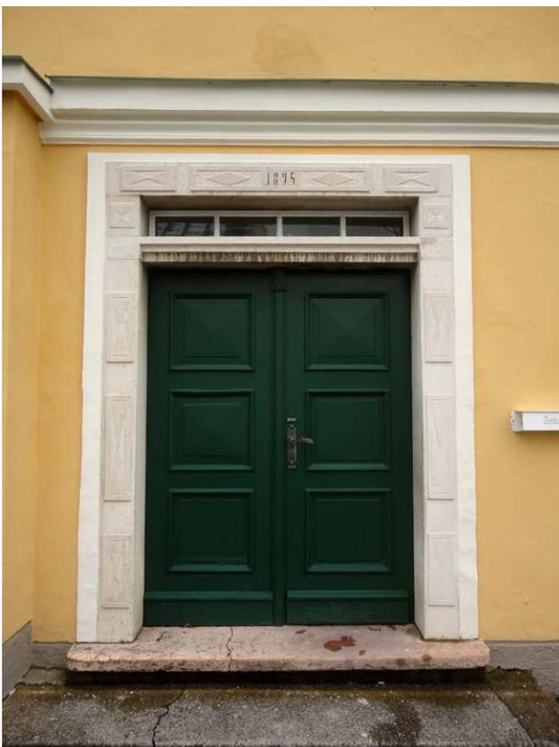
**Nr. 334:** Gewände aus Untersberger Marmor in Wildshut am Brauereigelände, Typ 7. An den Blenden sind Kartuschen mit Rautenmotiven. Diese Motive werden durch Abwechslung von glatter und gestockter Fläche erzeugt. Die Schwelle wurde aus Adneter Marmor gefertigt.
