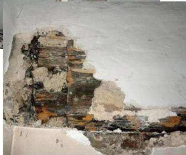
Abbildung 45: übrig gebliebene Blockwand
