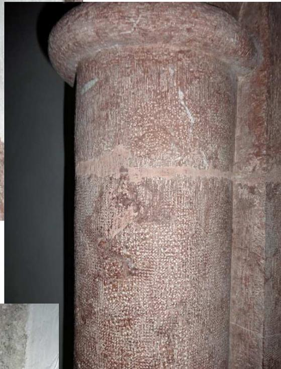
Abbildung 159: Rundpfeiler, gotisch, überstockt, die bahnscharrierte Oberfläche ist noch erkennbar, Pfarrkirche Oberalm
