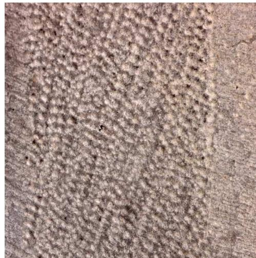
Abbildung 137: gepeckte Oberfläche
