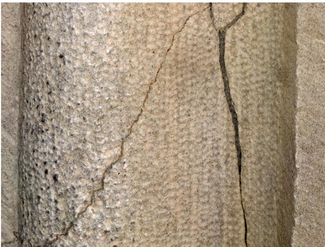
Abbildung 136: Profil mit den Zahnmeißel ausgearbeitet
