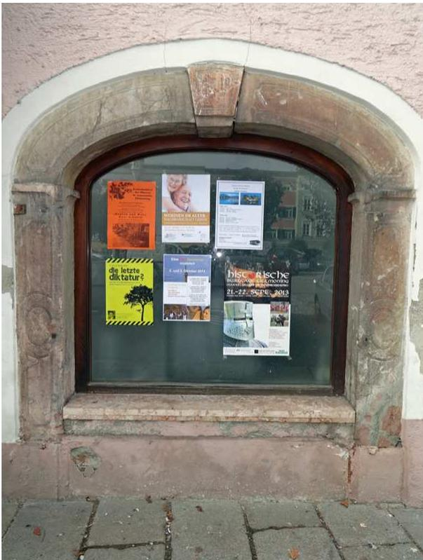
**Nr. 189:** Eingang zum Hotel „Alte Post“ in Tittmoning. Dieser steht direkt neben Katalog Nr. 188. Dieser wurde aber zu einem Schaufenster umgebaut. In den Kämpfersteinen und im Schlusstein sind Einschnitte. Sie wurden vermutlich wegen eines Fenstergitters eingearbeitet.
