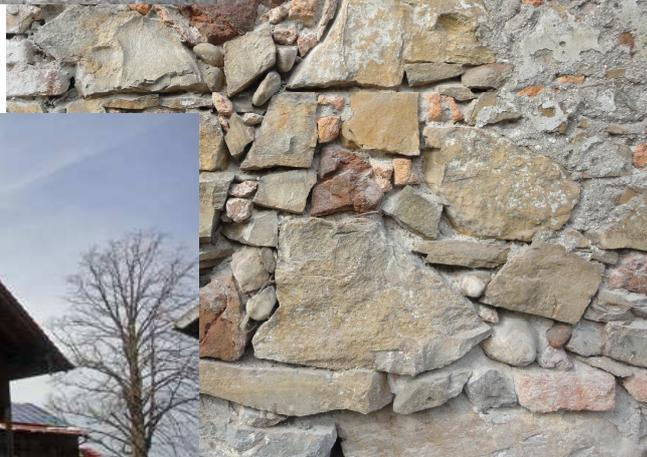
Abbildung 41: Kompartimentmauerwerk, Högler Sandstein, Ziegel
