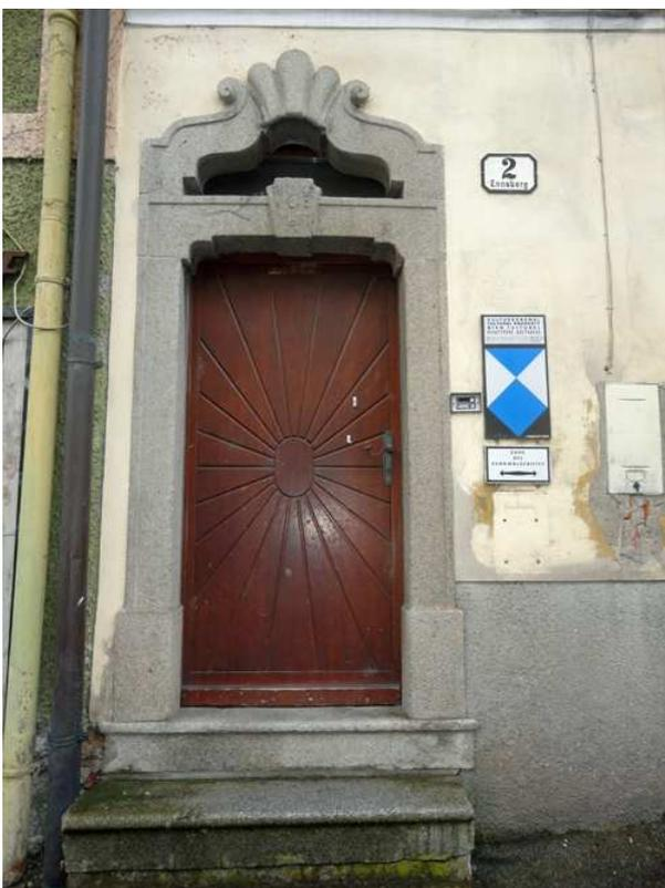
**Nr. 85:** Granittürstock in Enns. Dieser Eingang ist etwas besonderes, ab jetzt beginnen sich Türstockformen zu entwickeln, bei denen der Sturz eigentlich gerade, aber hohl ausgeschnitten ist. Sehr oft wird ein Schlussstein verwendet, der aber nur als Zierde dient, denn der Sturz ist aus einem Stück. Die ersten Exemplare dieses Typ 9 wurden im Raum Steyr, Enns und Linz gefunden.
