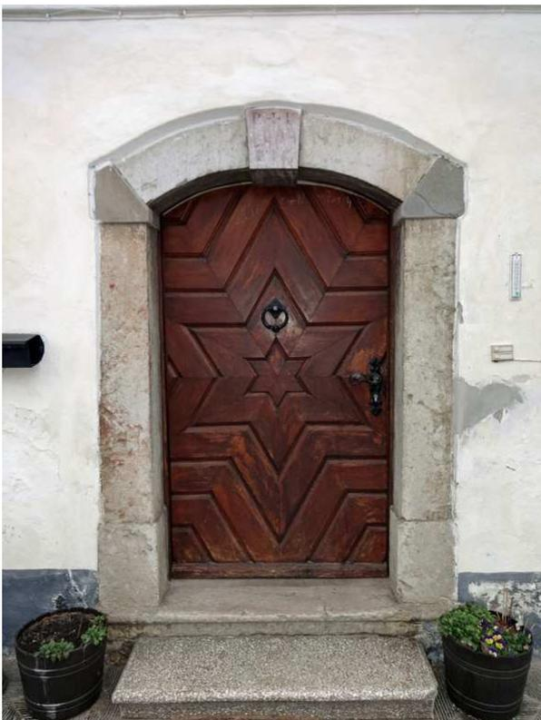
**Nr. 173:** Haustür eines Bauernhofes in Saaldorf. Das Gewände ist aus Untersberger Marmor, nur die Kämpfersteine sind aus Högler Sandstein. Für den Schlussstein wurde ein rötlicher Untersberger verwendet. Die Oberfläche ist gestockt, er gehört zum Typ 8.
