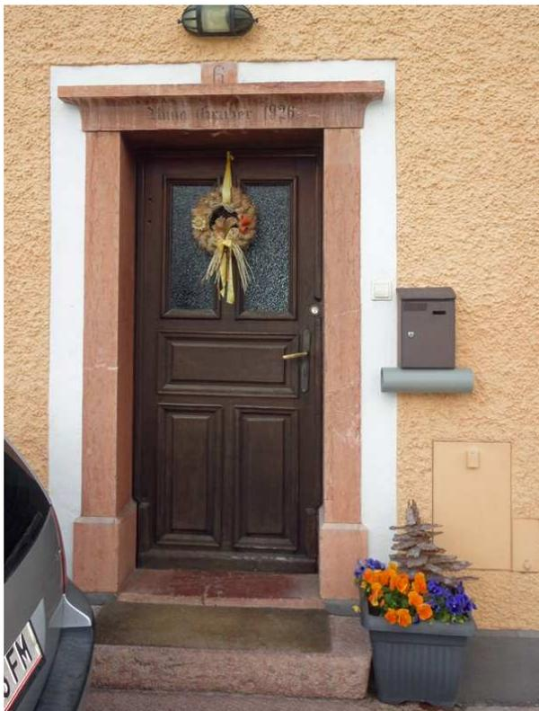
**Nr. 386:** Türstock in Adnet, Typ 7. Bei diesem einfachen und schlichten Türstock wurde die Oberfläche sehr fein gestockt. Als Stufe wurde ein gepeckter Adneter Marmor verwendet.
