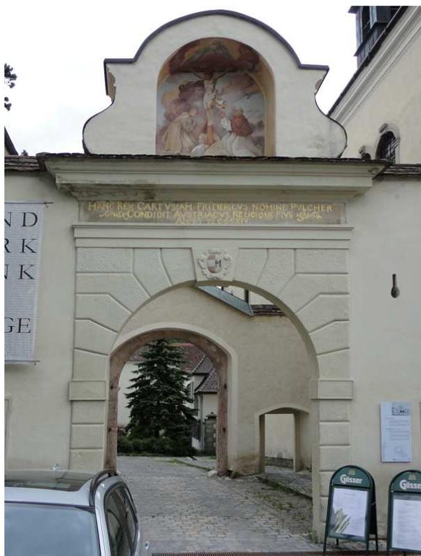
**Nr.110:** Torbogen der Toranlage der Kartause Mauerbach. Vergleicht man diesen Bogen mit Katalog Nr.104 dann wird die Ähnlichkeit in der „Quaderung“ deutlich. Aus den Bossen werden nun Linierungen, ähnlich wie kleine Fugen von exakt behauenen Steinen. Aus den Quadern werden abstrakte Vielecke, um das Eckige ins Runde überzuleiten. Der äußere Torbogen wurde bereits bei Katalog Nr. 78 beschrieben.
