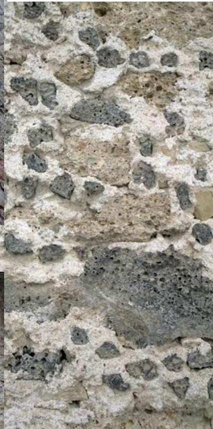
Abbildung 39: Kompartimentmauerwerk, Konglomerat. Schlacke
