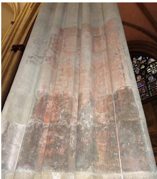
Abbildung 169: Regensburger Dom, Bündelpfeiler, original, gereinigt, Farbe entfernt
