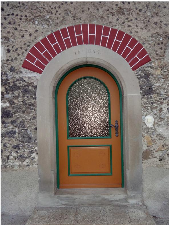
**Nr. 239:** Türstock eines Bauernhauses in Abtsdorf. Er gehört zum Typ 5. Das Haus wurde aus Sandstein, Schlacke und Konglomerat errichtet. Um eine gerade Wand zu erzeugen, wurden Flussteinchen und Schlacke in den Putz gedrückt. Für die Giebelmauer wurden Ziegel verwendet.
