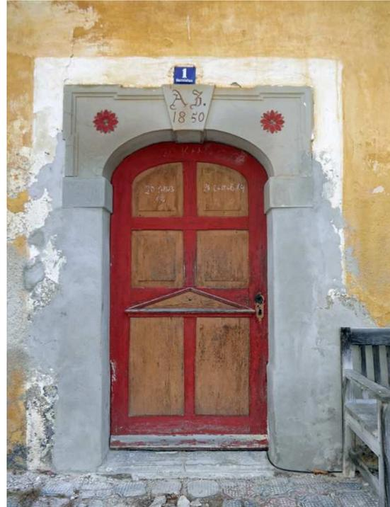
Abbildung 182: Herrenlehen bei Teisendorf, 1850, Högler Sandstein farblich gefasst
