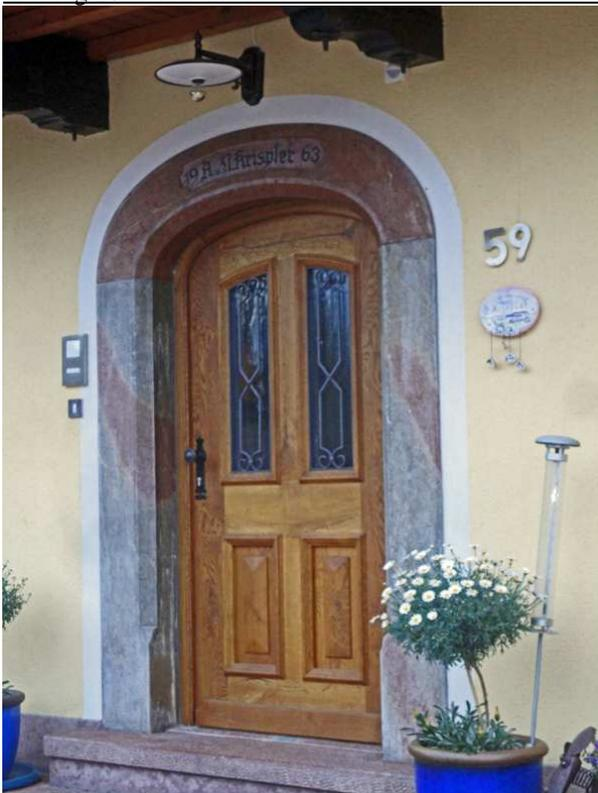
**Nr. 396:** Türgewände in Adnet. Dieser Türstock wurde nach Typ 4, spätere Ausführung mit schmaler Fase, gefertigt. Als Stein wurde Rot-Grau-Schnöll (Adneter Marmor) verwendet. Die Oberfläche konnte nicht begutachtet werden.
