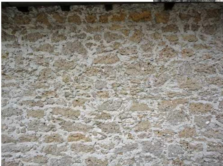
Abbildung 40: Kompartimentmauerwerk Konglomerat
