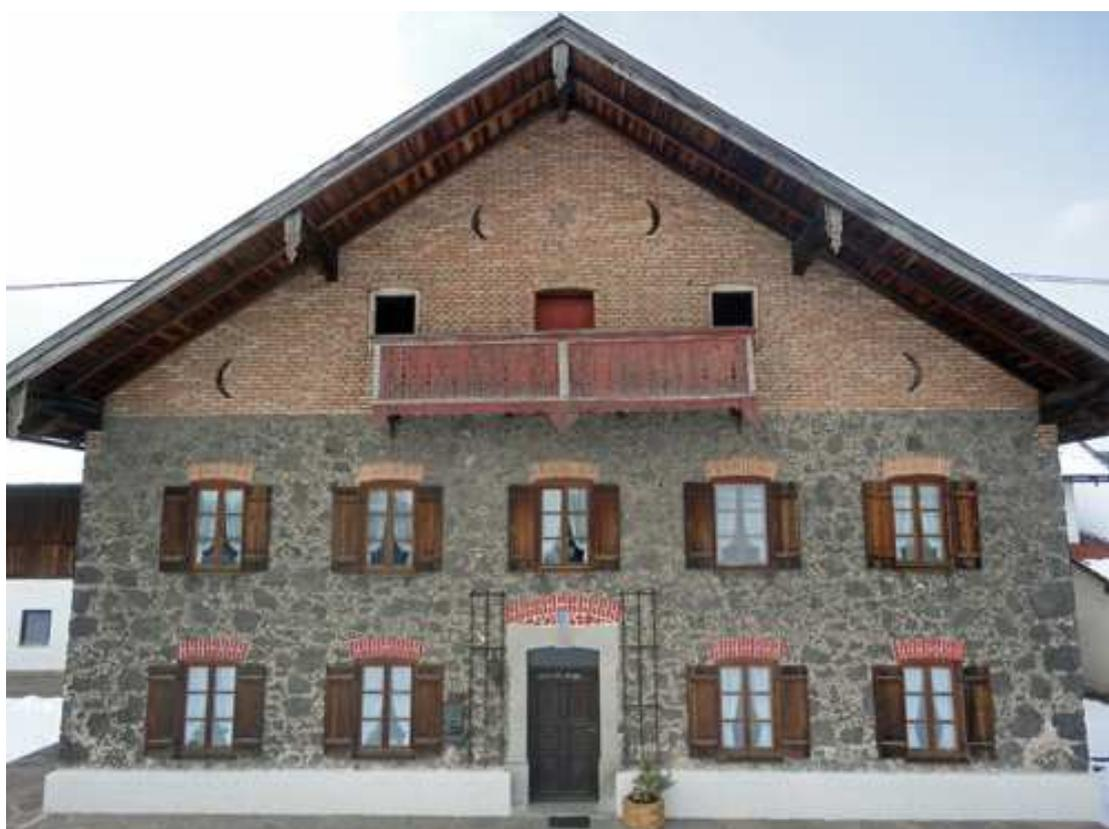
Abbildung 50: Mitterfelden 33, Schlacke- Ziegelbau 1909
