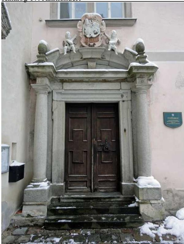
**Nr. 98:** Eingang des Stadtpfarrhofes in Steyr. Er ist aus Granit, nur die bildhauerischen Arbeiten sind aus Kalkstein. Er entspricht der Grundform Typ 7, ist gehrt und abgetreppt. Durch die Vorlagerung der Säulen wurde der Segmentgiebel verkröpft. Auf den Vorlagerungen stehen nun Vasen mit Pinienzapfen. Die Kugel wird von Pinienzapfen abgelöst.
