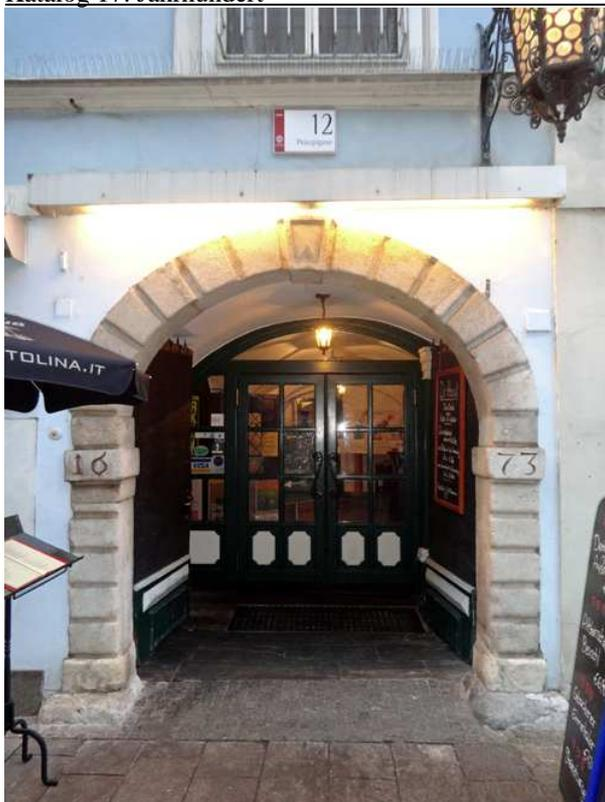
**Nr. 90:** Portal in der Prokopigasse 12 in Graz. Es ist vergleichbar mit Katalog Nr. 87, ebenfalls in Graz. Der aus Kalkstein gefertigte Türstock wurde komplett gestockt. Es ist nirgends ein Randschlag ersichtlich, deshalb kann man davon ausgehen, dass das Portal händisch überstockt wurde. Die Bauteile sind wieder bossiert, die Jahreszahl wurde eingraviert, der Schlussstein ist diamantiert.
