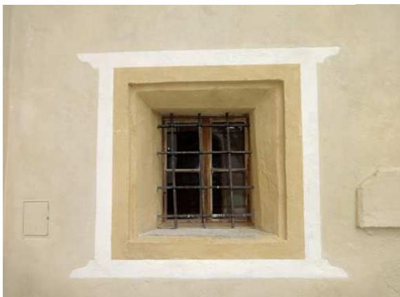
Abbildung 171: Schloss Hoch in Flachau, alle Fenster- und Türleibungen sind mit einer gelben Kalkschlämme versehen
