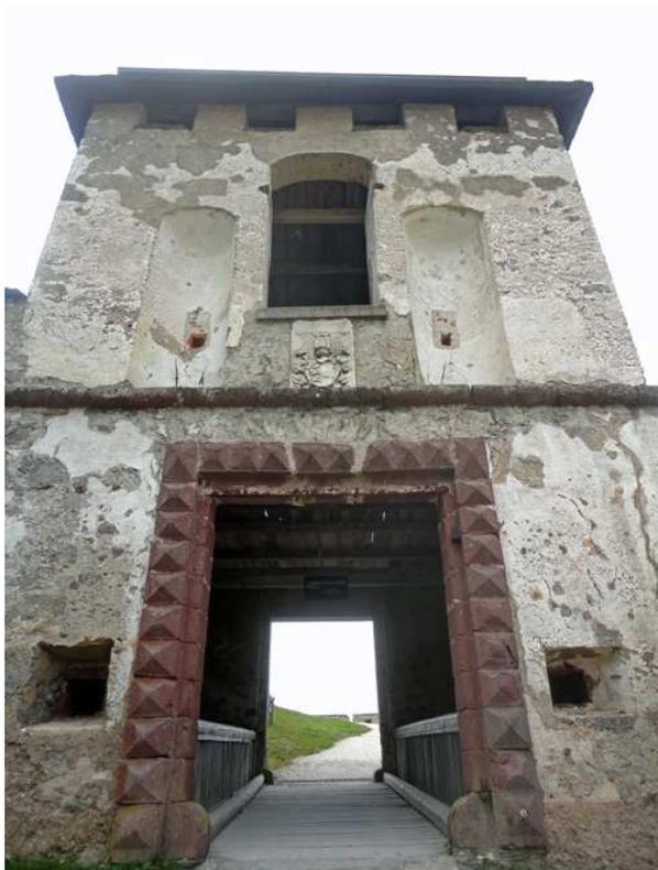
**Nr. 25:** Tor der Burg Hochosterwitz. Datiert wurde dieses Portal aus rotem Sandstein über das Wappenschild. Der gerade Sturz wurde gemauert, jedoch durch ein Eisenband verstärkt. Die Bosse sind diamantiert und haben durch diese klare und kantige Wirkung eine „abweisende, wehrhafte, stachelige“ Form. Durch die rötliche Farbe des Gesteins und des Gesimses setzt sich dieses Tor von der Turmfassade farblich deutlich ab.
