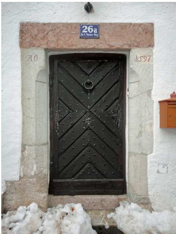
Abbildung 220: Hallstatt 1597, die Seitenteile sind falsch herum eingebaut, der Sturz und die Steine von der Schwelle haben zudem auch noch eine andere Oberfläche. Dies zeigt, dass die Laibung wieder verwendet und falsch herum eingebaut wurde. Die Jahreszahl ist sehr gut gefälscht, könnte jedoch im Bezug auf das Alter der Seitenteile stimmen
