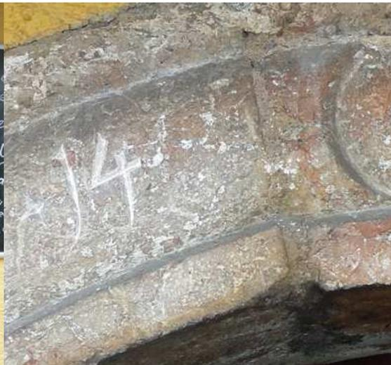
Abbildung 219: die Zahlen sind in moderner Schreibweise geschrieben, außerdem ist die Oberfläche der Gravur nicht verwittert. Dies entlarvt, dass die Jahreszahl nicht stimmt
