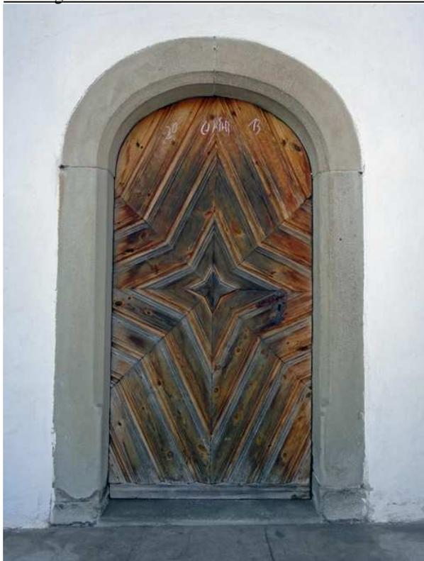
**Nr. 168:** Hauseingang in Anger, aus Högler Sandstein. Er wurde nach Typ 5 gefertigt und die Oberfläche ist gestockt. Besonders ist, dass die Jahreszahl in römischen Ziffern angegeben wurde. Auch diese Variante kommt in diesem Zeitraum öfter vor. Die Schwelle wurde wieder herausgeschnitten.
