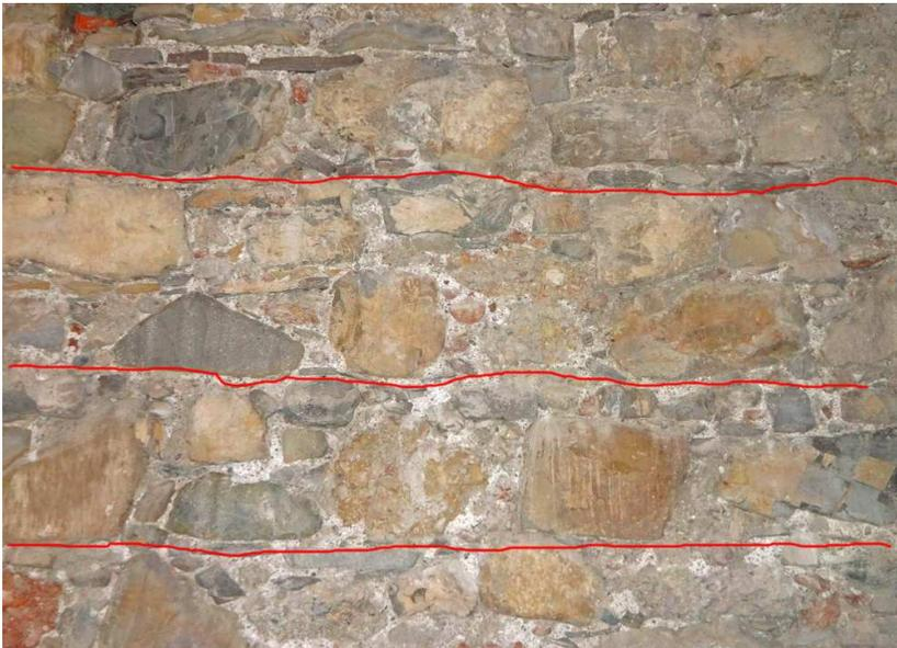
Abbildung 36: Saaldorf, Kirchturm, Kompartimentmauerwerk mit Abgleichungen
