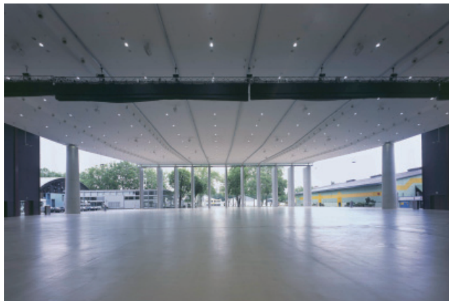
Abb. 29: Stadthalle Graz, Saal
