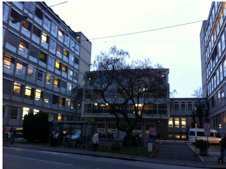
Abb.154: Institutsgebäude Heinrichstraße 26 und 28
