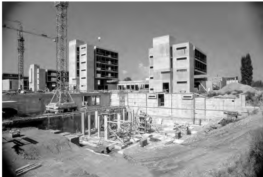
Abb.157: Bauarbeiten am Maschinenbaukomplex
