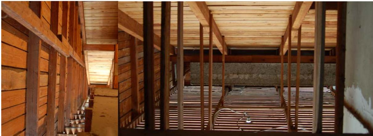
*Abb. 130-131: Balkondeckenabhängung*
