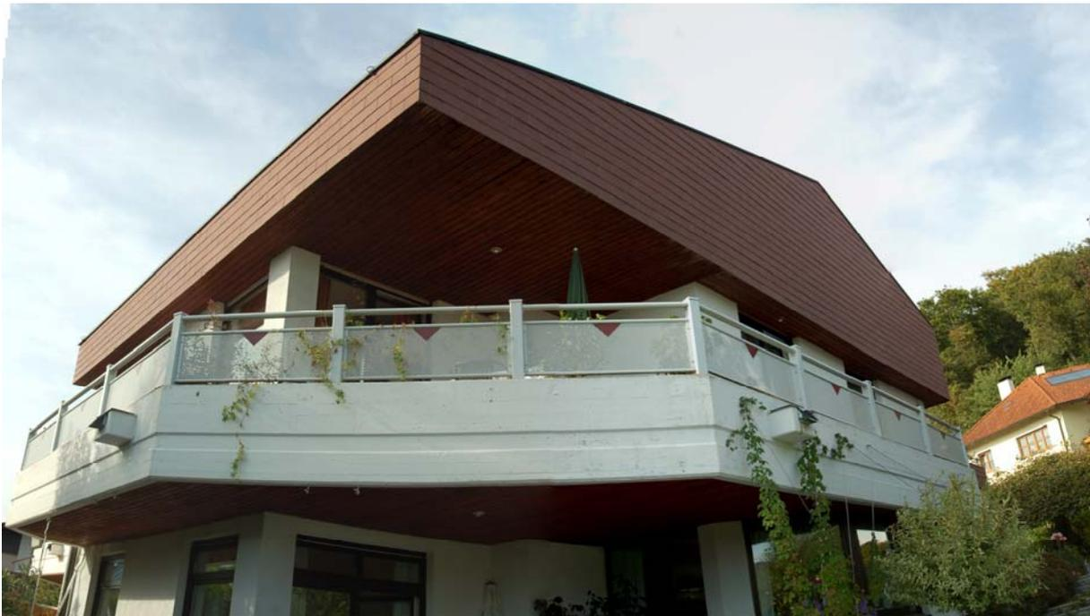
Abb. 88: Balkon des Hauses mit Holzdeckenverkleidungen
