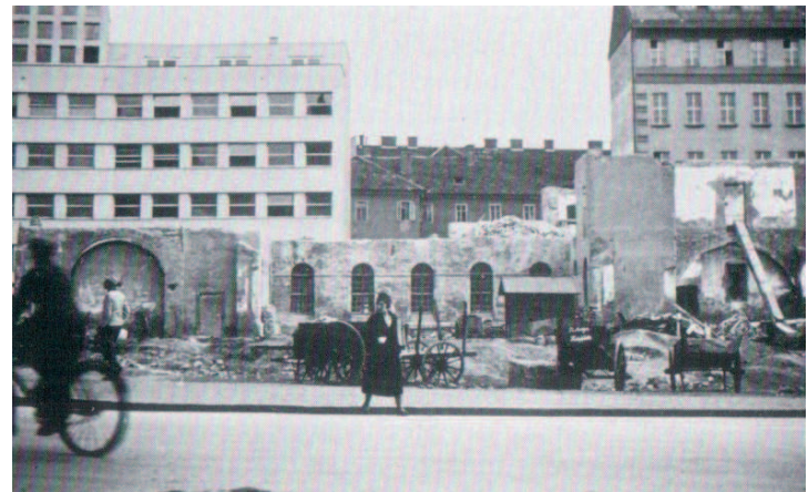
Abb.18 Abbruch des Monturdepots; 1934
