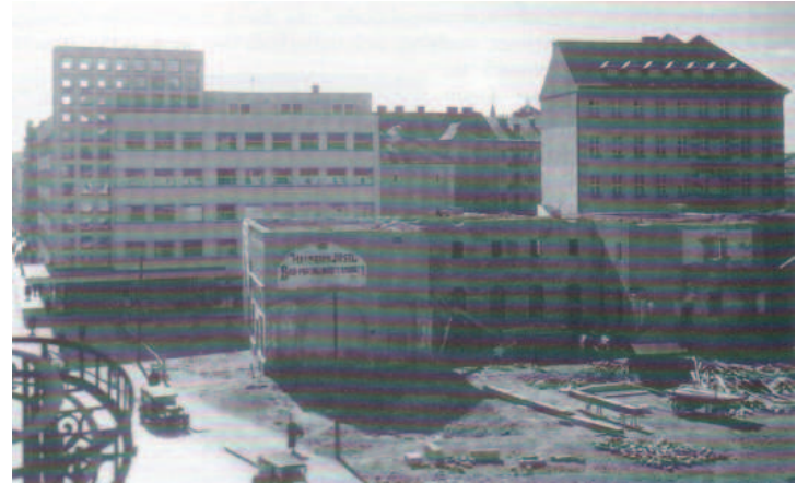
Abb.16 Abbruch des ehemaligen Monturdepots; 1934
