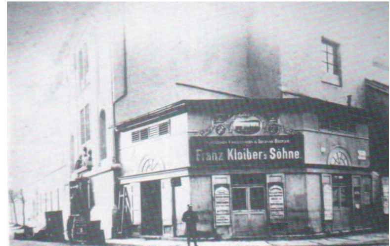
Abb.22 Kloibereck des Monturdepots Fischplatz, Neutorgasse
