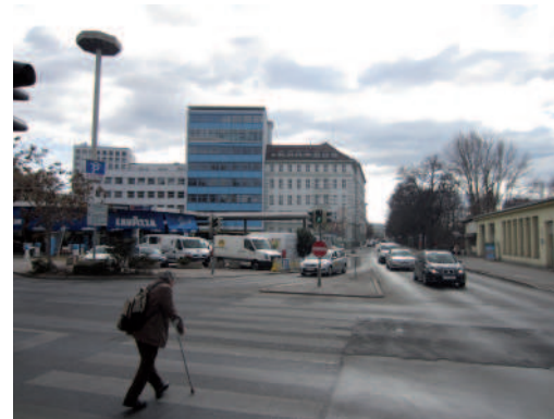
Abb.34 Trafohäuschen- Blick Richtung Marburger Kai
