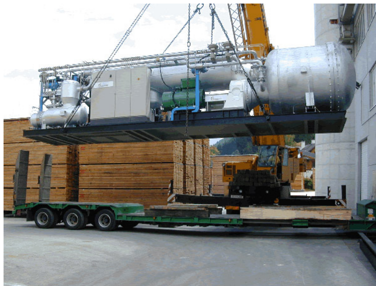
Abbildung 1: ORC Anlage bei der Anlieferung in Admont ( http://www.bios-bioenergy.at )
