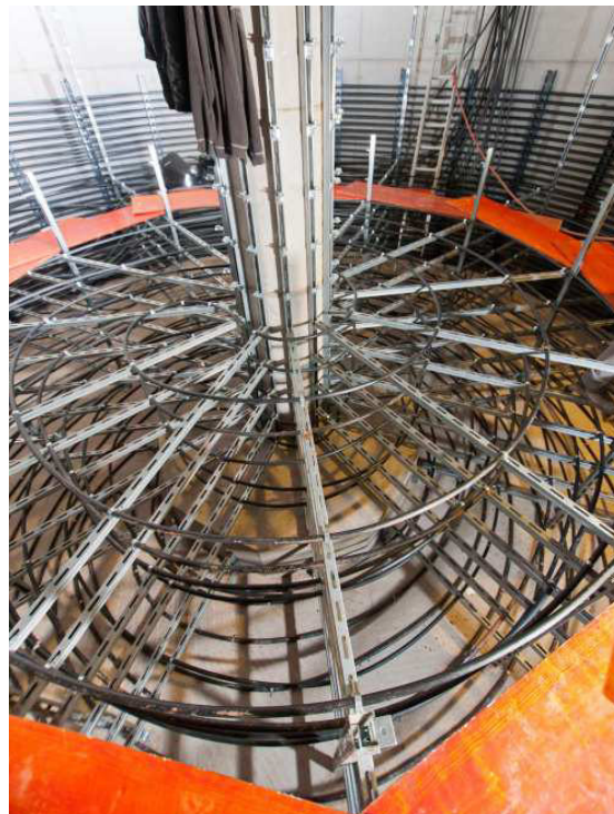
24 + 25) Eisspeicherheizung im Aufbau
