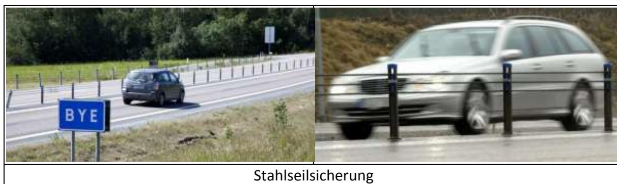
Abbildung 8: Stahlseilsicherung auf schwedischen Landesstraßen [58]
