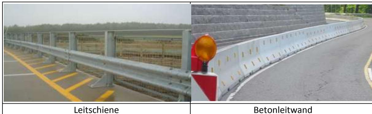
Abbildung 7: Leitschiene [13], Betonleitwand [6]
