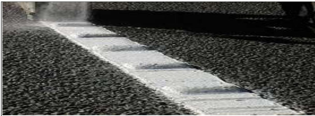
Abbildung 14: Einformen von Rumble Strips [9]
