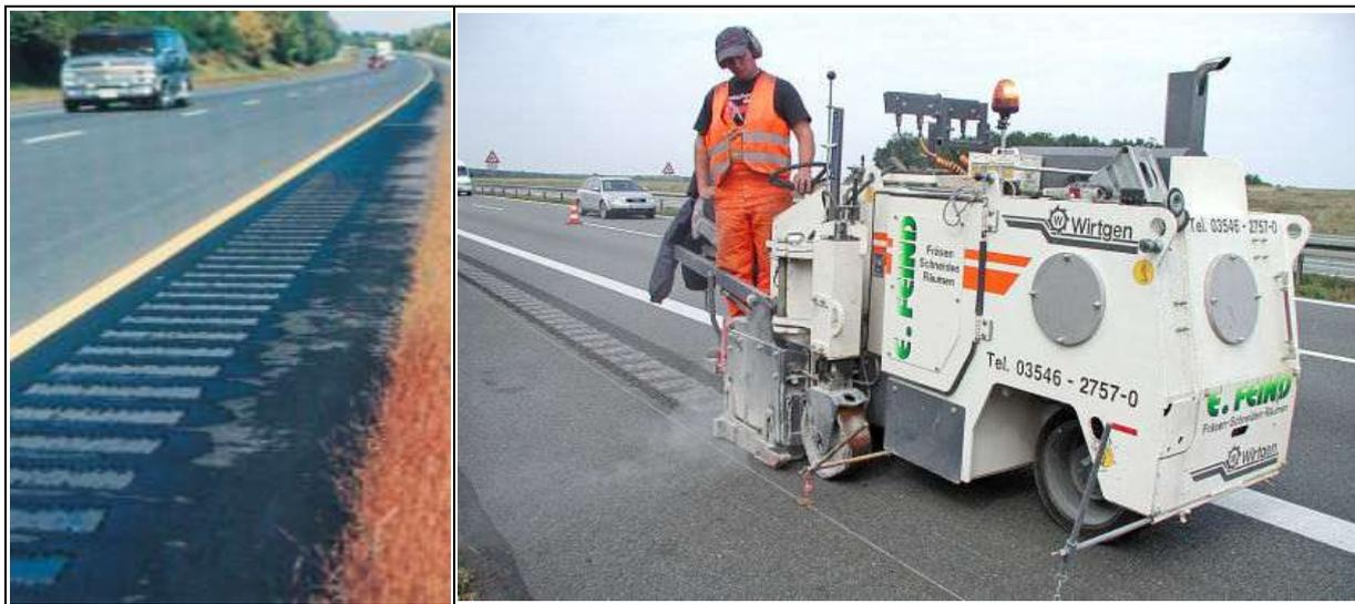
Abbildung 12: Einfräsen von Rumble Strips [10], [11]
