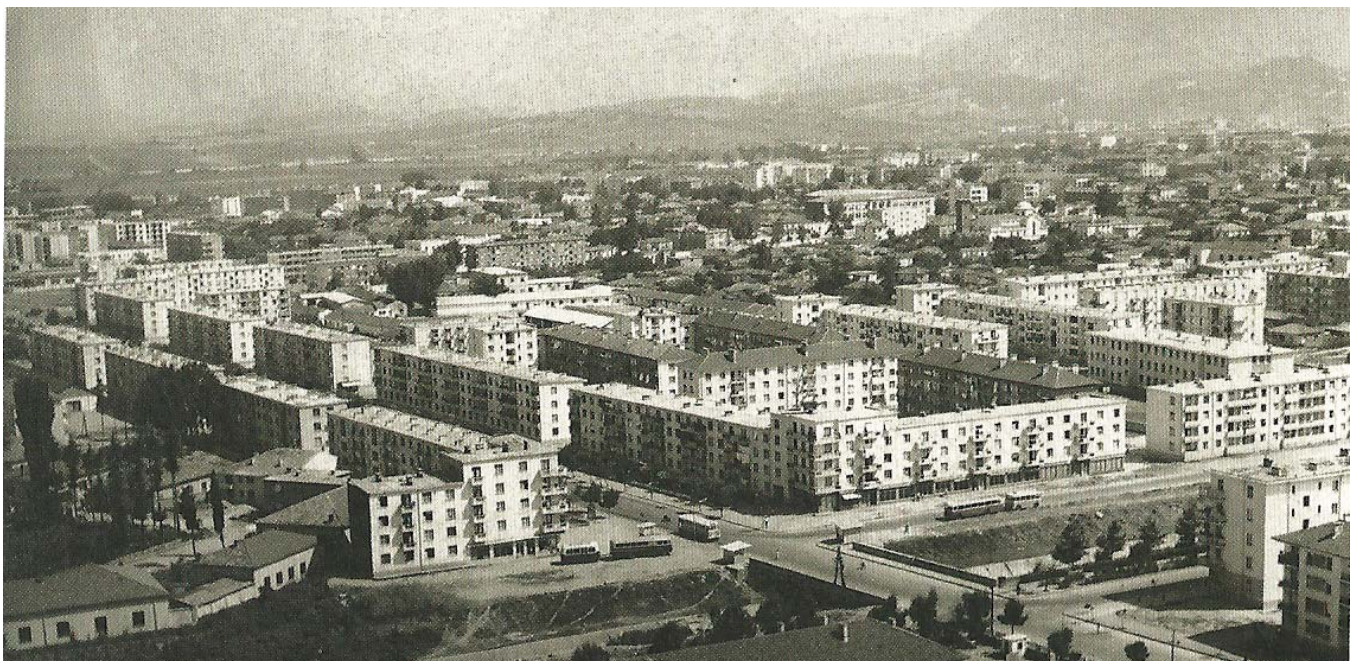
Abb. 19: Neues Wohnviertel im Westen der Stadt. Mitte der 60er Jahre.
