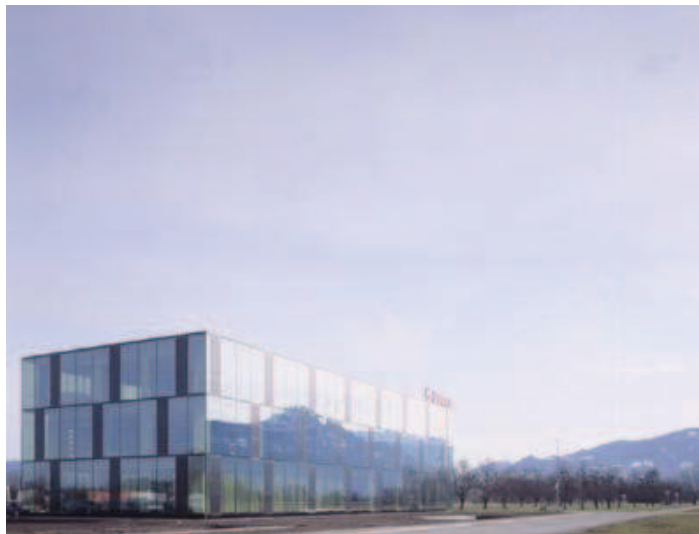
Abb. 40 Gesamtansicht Burobau Saeco
