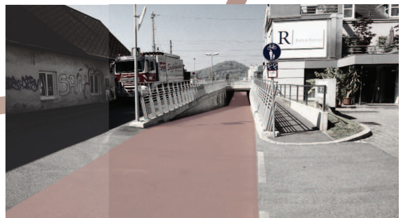
Unterführung Friedhofgasse Osteinfahrt
