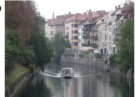
Bild 93 Uferbebauung mit 18 - 20m
