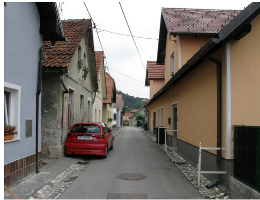
Bild 101 Enge Gassen zwischen kleinen Einfamilienhäusern.
