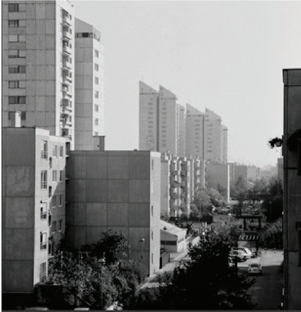
Bild 80 Wohnsiedlung BS3, 1976-1981, Architekt: Ilija Arnautović; Anlage viergeschossigen Wohnblocks aus 1976 und später errichtete zwanzig geschossigen Wohnhäuser aus 1981. Ilija Arnautović projektierte zwischen 1962-1981 acht neue Wohnsiedlungen in Ljubljana.
