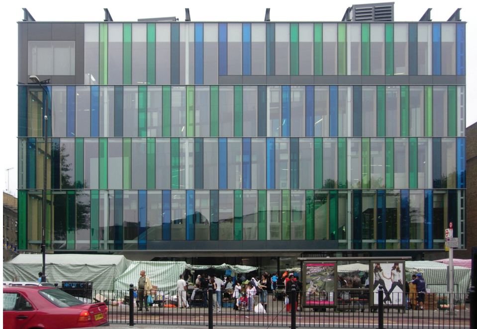
Bild 25 (oben) Idea Store Whitechapel, Adjaye Associates, Eingangssituation Bild 26 (rechts) Idea Store Whitechapel, Adjaye Associates, Eingangssituation
