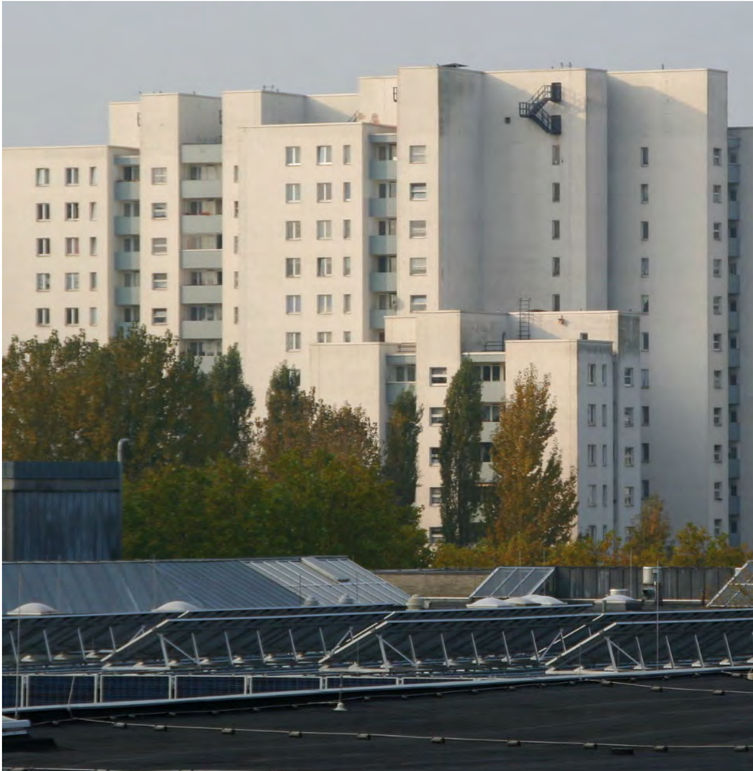
Wohnhausgruppe 909 am Wilhelmsruher Damm Architekt Oswald Mathias Ungers Wohnungen 1 305
