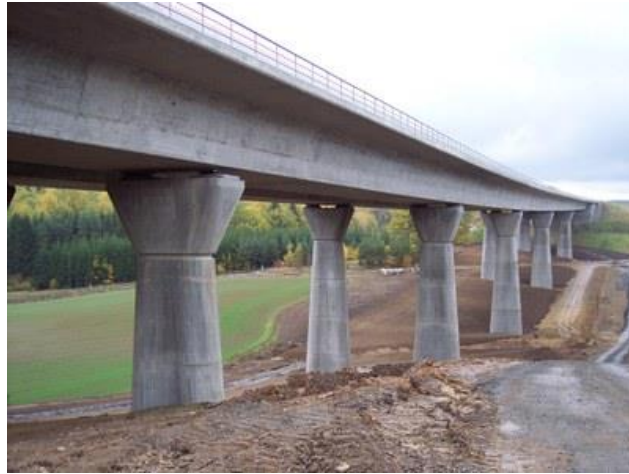
Bild 6-1 Brücke mit Kastenquerschnitt
