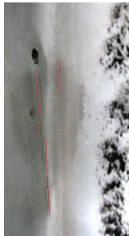
Bild 4-169 Rissausbildung an den vertikalen Ränder – Außenseite
