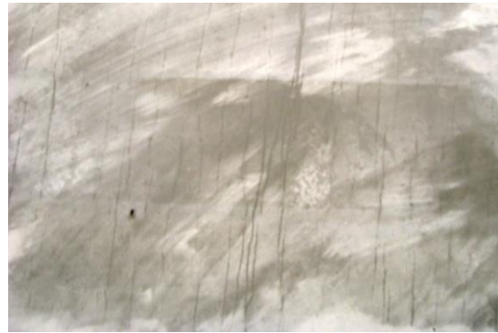
Bild 4-185 Rissbildung an der Stelle 2 (Links) und an der Stelle 3 (Rechts)
