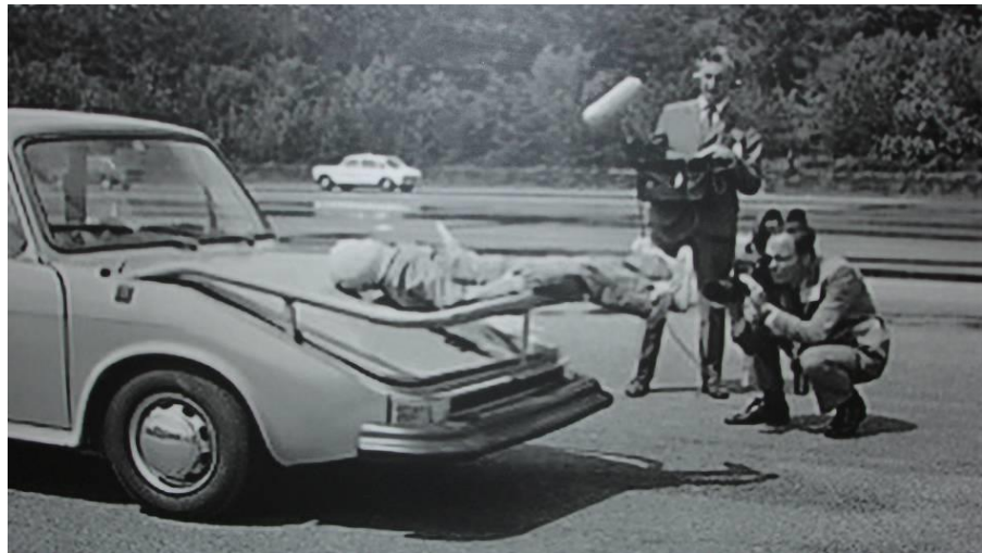
Abb. 6: Zeitgenössische Dummy-Versuche mit dem SRV 5 zeigten die Funktionsweise der Fußgängerschutz- Maßnahmen (Foto: Lorenz 2009, S. 3)
