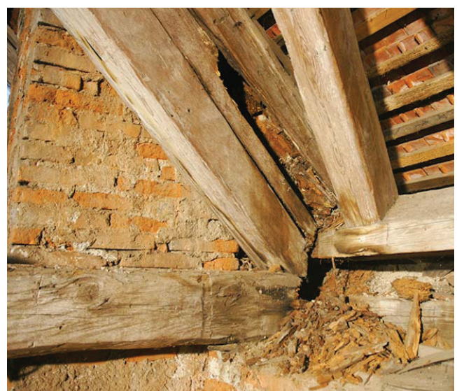
Bild 5.3 Zerstörter Knotenpunkt.
