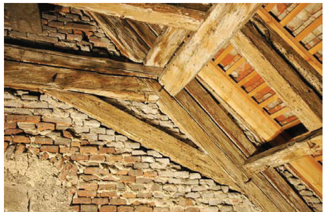
Bild A.26 Gekappte Bauteile infolge des Einbaus von Kaminen beziehungsweise Haustechnikanlagen, in die Giebelmauer eingebundene und zum Teil geschädigte Holzbauteile.
