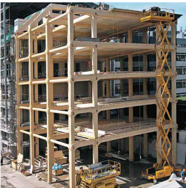
Bild 6.10 Ansicht bei der Montage, ANTEMANN (2014).
