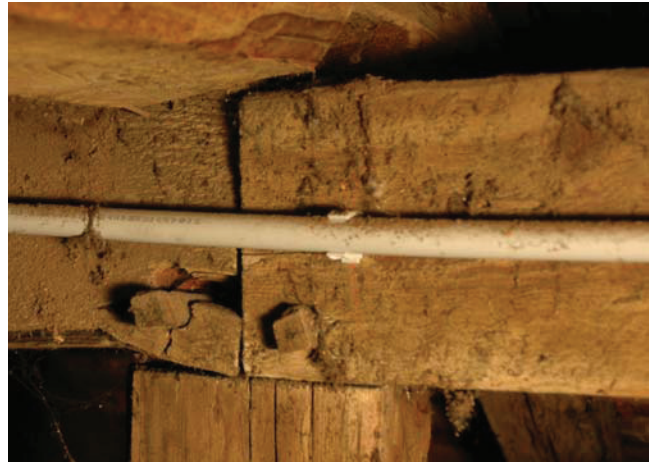
Bild 4B.10 Stumpfer Stoß eines Rähms (Färbergasse 11, Graz). Fig. 4B.10 Butt joint of a collar plate (Färbergasse 11, Graz).
