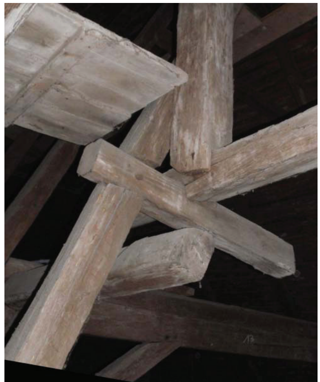
Bild 4F.3 Links: Firstbereich ohne adequate Aussteifung in Firstrichtung, Rechts: Flickwerk im Bereich einer Ichse (= Kehle). Fig. 4F.3 Left: ridge area without adequate bracing in ridge direction, Right: structural disorder in the area of a valley.
