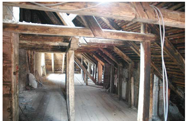
Bild A.40 Links: klaffende Zapfenverbindung von Kehlbalcken-Stuhlsäule, Rechts: gekappte Streben und Sparren (Kamindurchdringung, Rinne). Fig. A.40 Left: gaping mortise and tenon joint of collar beam and post, Right: cut off struts and rafters (chimney, inner gutter).
