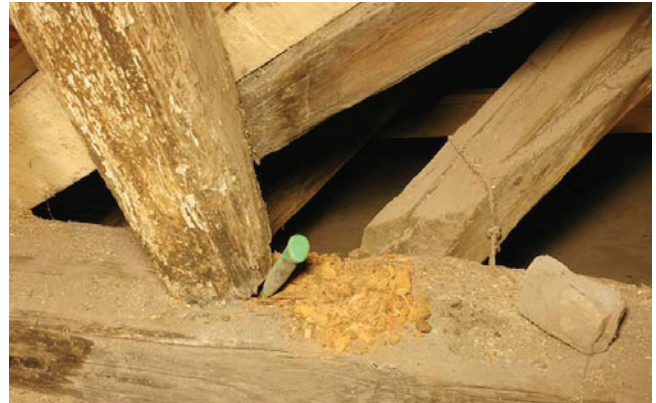
Bild A.47 Links oben, unten und Rechts oben: geschädigter Sparrenfußpunkt vor und nach der Bearbeitung mit der Hammerspitze, Rechts unten: die Mauerbank ist infolge von Innenfäule zerstört (siehe Eindringtiefe des Lattenhammers).
