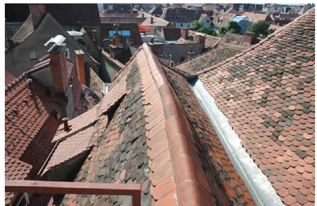
Bild A.36 Links: Dachraum im Bereich des Spitzbodens des Satteldaches, Rechts: innenliegende Dachrinne. Fig. A.36 Left: attic in the area of the top of the double pitch roof, Right: internal gutter.
