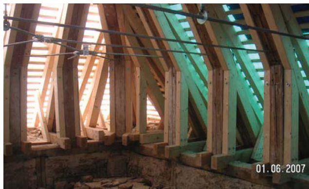
Bild 5.6 „Additive Reparatur“ beziehungsweise Verstärkung der Sparrenfußpunkte, ZEHETGRUBER (2008).
