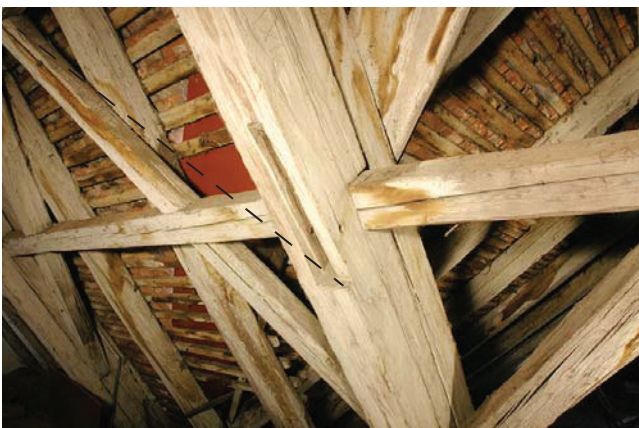
Bild A.65 Links: fehlendes Kopfband, Rechts: durch Pilzbefall geschädigter Stuhlsäulenfußpunkt.
