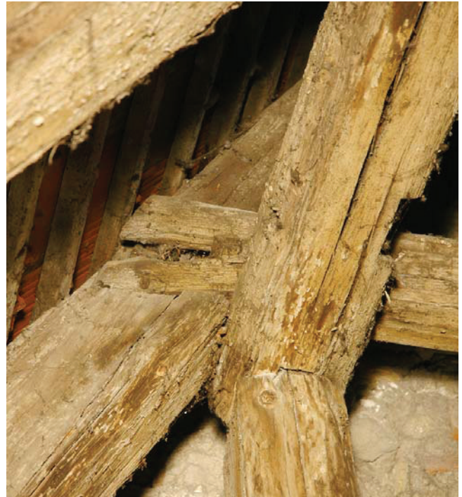
Bild A.49 Links: klaffende Weißschwanzverbindung, Rechts: versagte Weißschwanzverbindung. Fig. A.49 Left: gaping dovetail lap joint, Right: failed dovetail lap joint.
