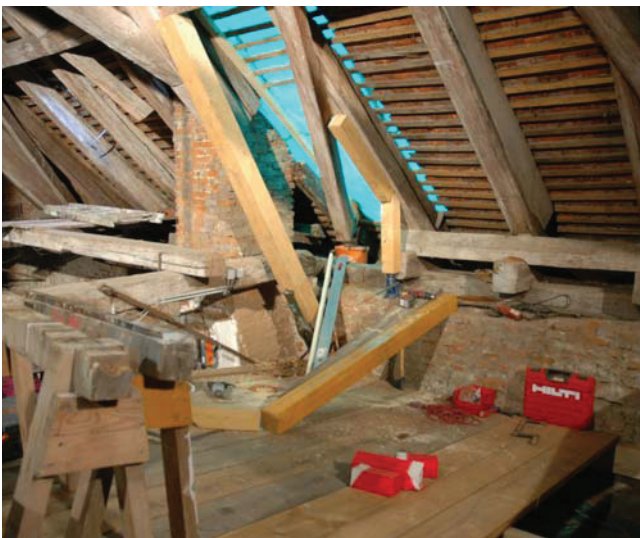
(c) Hilfsunterstellung einbauen und anheben, pilzgeschädigte Hölzer gesundschnitten
