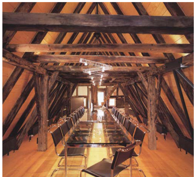
Bild 1.3 Dachgeschoßausbau in einem historischen Dachwerk (KÖNNER U. WAGENBLAST U. A. (1998 S. 67)).
