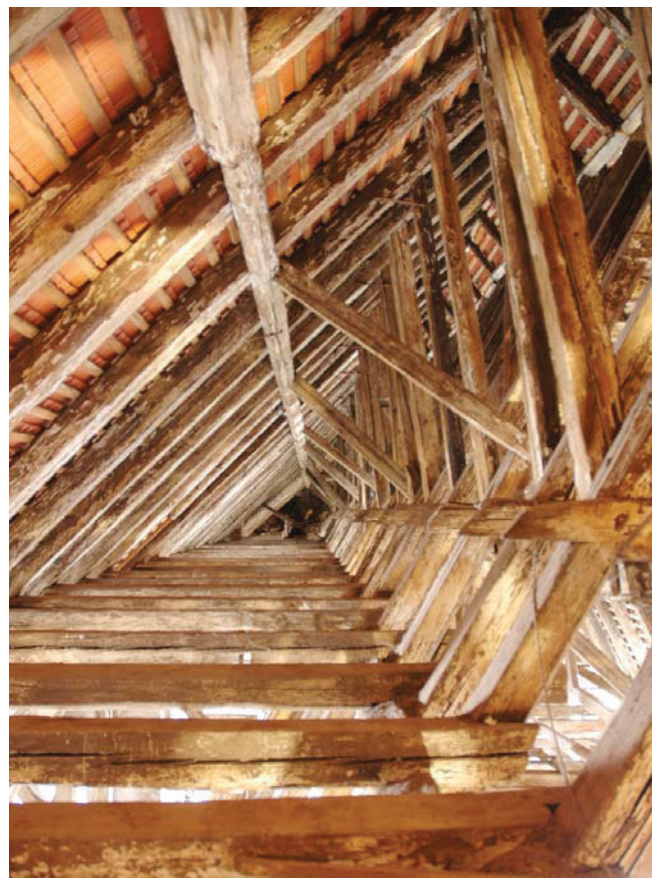
Bild A.52 Links: hinzugefügte Stuhlwand, Rechts: Pfettenstrang (von Stützböcken getragen).
