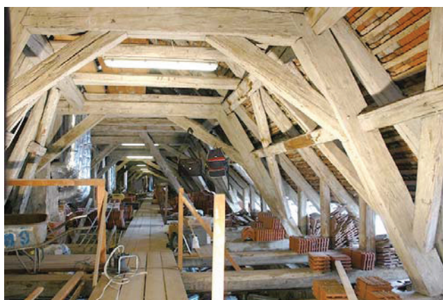
Bild A.59 Dachraum des Mitteltraktes.
