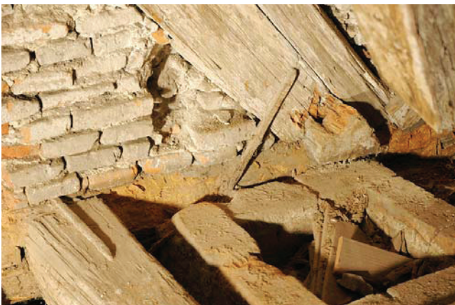
Bild A.26 Gekappte Bauteile infolge des Einbaus von Kaminen beziehungsweise Haustechnikanlagen, in die Giebelmauer eingebundene und zum Teil geschädigte Holzbauteile.
