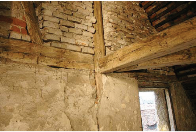
Bild A.39 Links: eingemauerte Tragwerksteile, Rechts: die Innenrinne (vom Dachraum aus betrachtet, hier existiert der Rinnenträger). Fig. A.39 Left: walled members, Right: inner gutter (view from the attic, with existing support).
