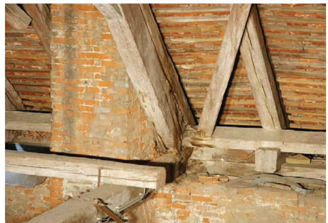
Bild 5.2 Stuhlsäulenfußpunkt in der Nähe eines Kamins, Alte Universität Graz.
