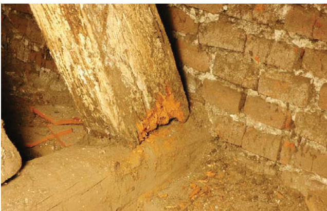
Bild A.48 Geschädigte Fußpunkte in unterschiedlichen Vollgespärren.
