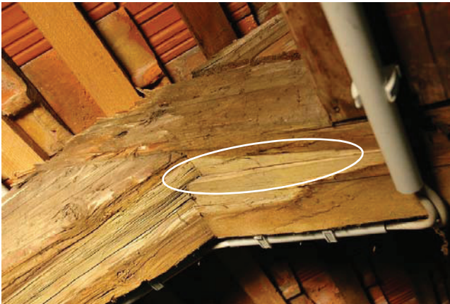
Bild A.8 Links: auf Rollschub versagte Verbindung, Rechts: klaffende Mauerbankverbindung.
