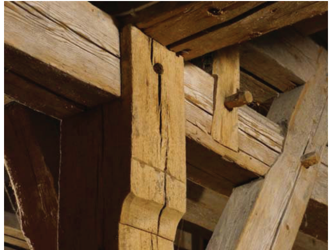
Bild 4B.13 Einhalsung des Spannriegels (Münster in Ingolstadt). Fig. 4B.13 Fork joint of the straining beam (Münster in Ingolstadt).
