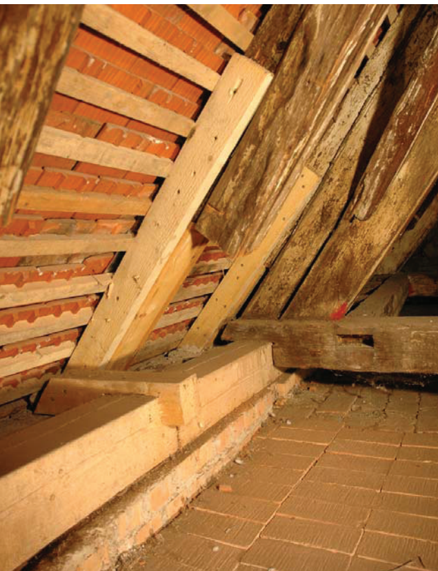
Bild A.30 Nicht fachgerechte Instandsetzungen, Links: Leergespärre 3.1 und Vollgespärre 3, Rechts: Vollgespärre (VG) 5. Fig. A.30 Incompetent interventions, Left: secondary truss 3.1 and principal truss 3, Right: principal truss (PT) 5.
