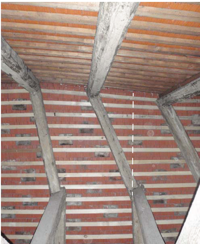
Bild 4F.3 Links: Firstbereich ohne adequate Aussteifung in Firstrichtung, Rechts: Flickwerk im Bereich einer Ichse (= Kehle). Fig. 4F.3 Left: ridge area without adequate bracing in ridge direction, Right: structural disorder in the area of a valley.
