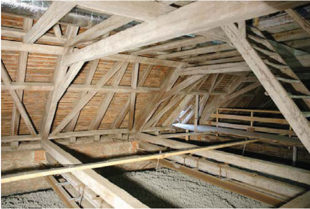
Bild A.33 Kehlbalkendach mit zweistöckigem, liegendem Stuhl, Links: 1. Stockwerk Rechts: 2. Stockwerk.
