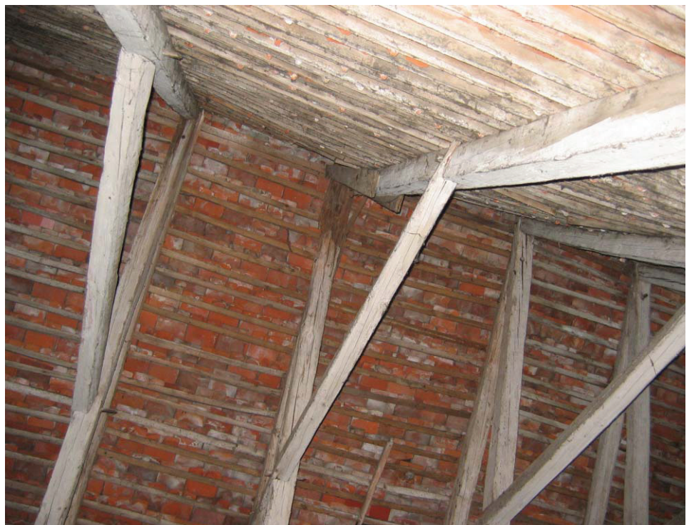
Bild 4F.1 Firstbereich im Nordtrakt des Dachwerks von Schloss Hainfeld.
