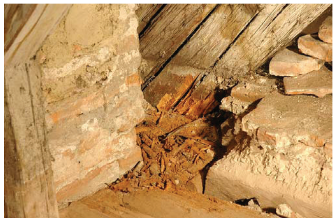
Bild A.65 Links: fehlendes Kopfband, Rechts: durch Pilzbefall geschädigter Stuhlsäulenfußpunkt.
