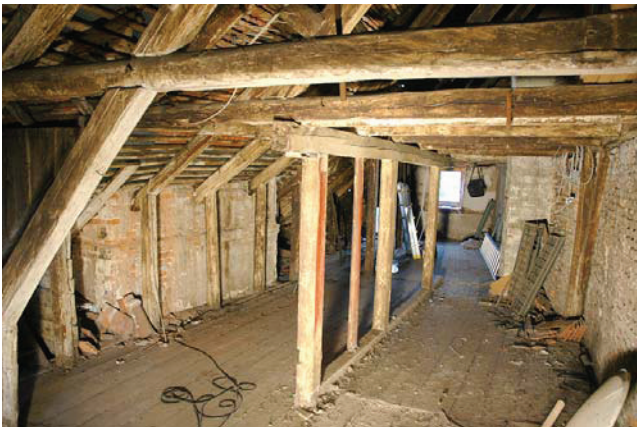
Bild A.35 Dachraum im Bereich des Pultdaches. Fig. A.35 Attic in the area of the mono pitch roof.
