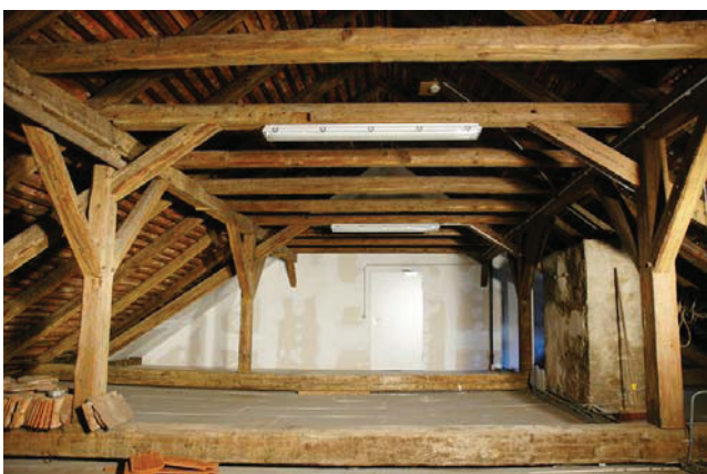
Bild A.2 Links oben: einfaches Kehlbalkendach, Rechts oben: Grat- und Walmbereich, unten: Kehlbalkendach mit Stuhl (Südosttrakt). Fig. A.2 Top Left: collar beam roof structure, top Right: hip area, below: collar beam roof structure with frame (southeast wing).
