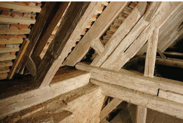
Bild A.22 Verschiedene Stuhlsäulen- und Sparrenfußpunkte, alle mit historischen Instandsetzungen. Fig. A.22 Different bases of rafters and raking struts, all with historic interventions.
