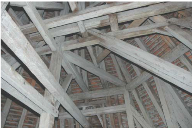
Bild 3.10 Statisch hochgradig unbestimmtes Dachwerk über der Apsis des Doms in Graz.
