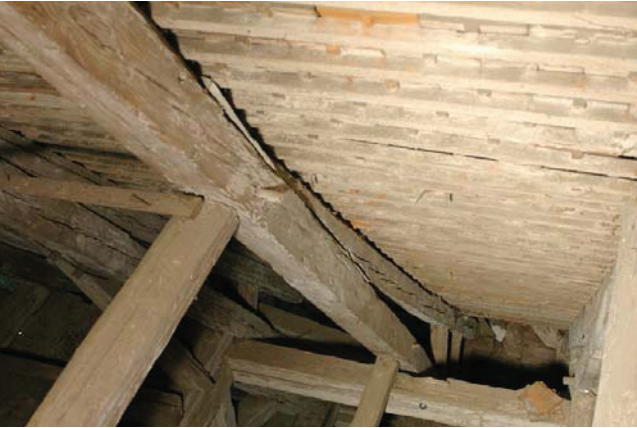
Bild A.21 Durchhang der nordseitigen Sparren. Fig. A.21 Deformations of the rafters in the north.
