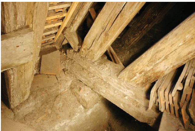
Bild A.45 Links: verschmutzter Sparren-/Strebenfußpunkt, Rechts: grob gereinigter Sparren-/Strebenfußpunkt. Fig. A.45 Left: dirty rafter/strut base, Right: roughly cleaned rafter/strut base.
