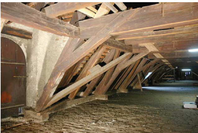
Bild A.15 Links: Vollgespärre (VG) 11, Fußpunkt ohne geschmiedete Klammer. Rechts: Verformung des Rähms zwischen VG 10 und VG 12. Fig. A.15 Left: principal truss (PT) 11, base without forged clamp, Right: Deformation of the collar plate between PT 10 and PT 12.
