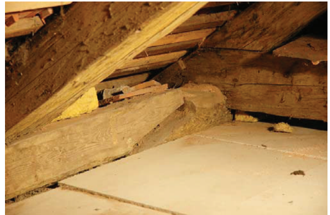
Bild A.8 Links: auf Rollschub versagte Verbindung, Rechts: klaffende Mauerbankverbindung.
