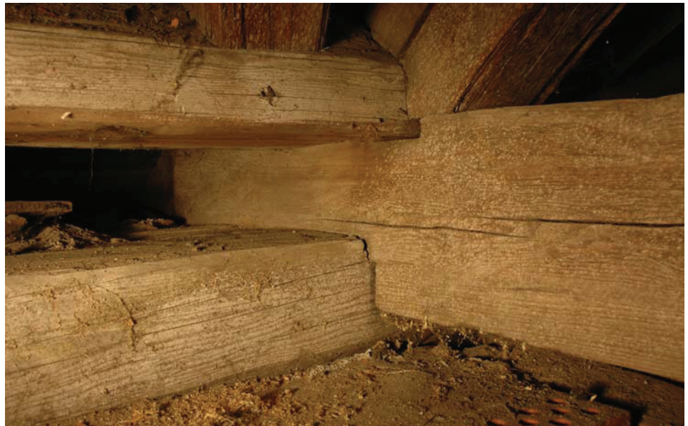
Bild 4E.1 Stuhlsäulenfußpunkt eines Kehlbalkendachs mit liegendem Stuhl.
