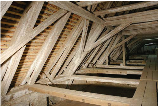
Bild A.17 Links: nordseitige, liegende Stuhlwand, Rechts: stehende Stuhlwand.
