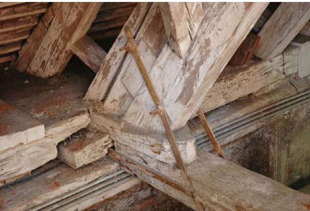
Bild A.21 Durchhang der nordseitigen Sparren. Fig. A.21 Deformations of the rafters in the north.
