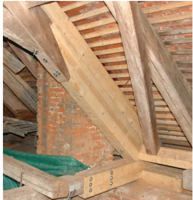
Bild 5.15 Links: Instandsetzungsplanung (Skizze vgl. ORTNER (2014)), Rechts: Instandsetzungsausführung, Alte Universität Graz. Fig. 5.15 Left: design of the intervention (sketch see ORTNER (2014)), Right: execution of the intervention, Old University Graz.
