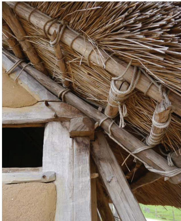
Bild 4B.4 Dachfußdetail aus dem Vikingermuseum Haithabu. Fig. 4B.4 Roof base detail from the Viking Museum Haithabu.
