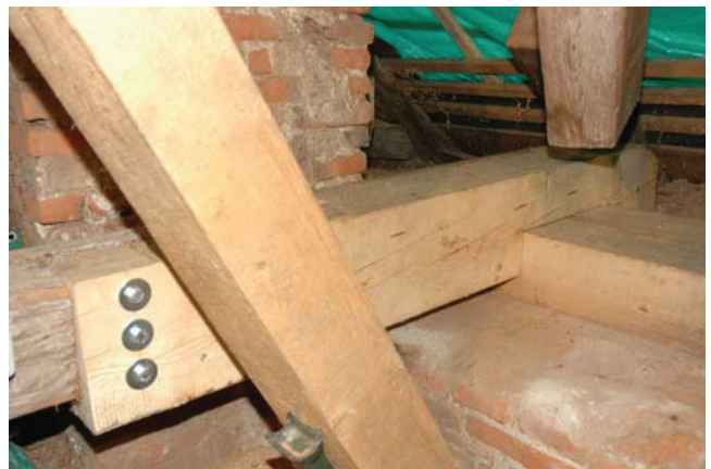
(d) neue Mauerbänke und Bundtramkopf herstellen
