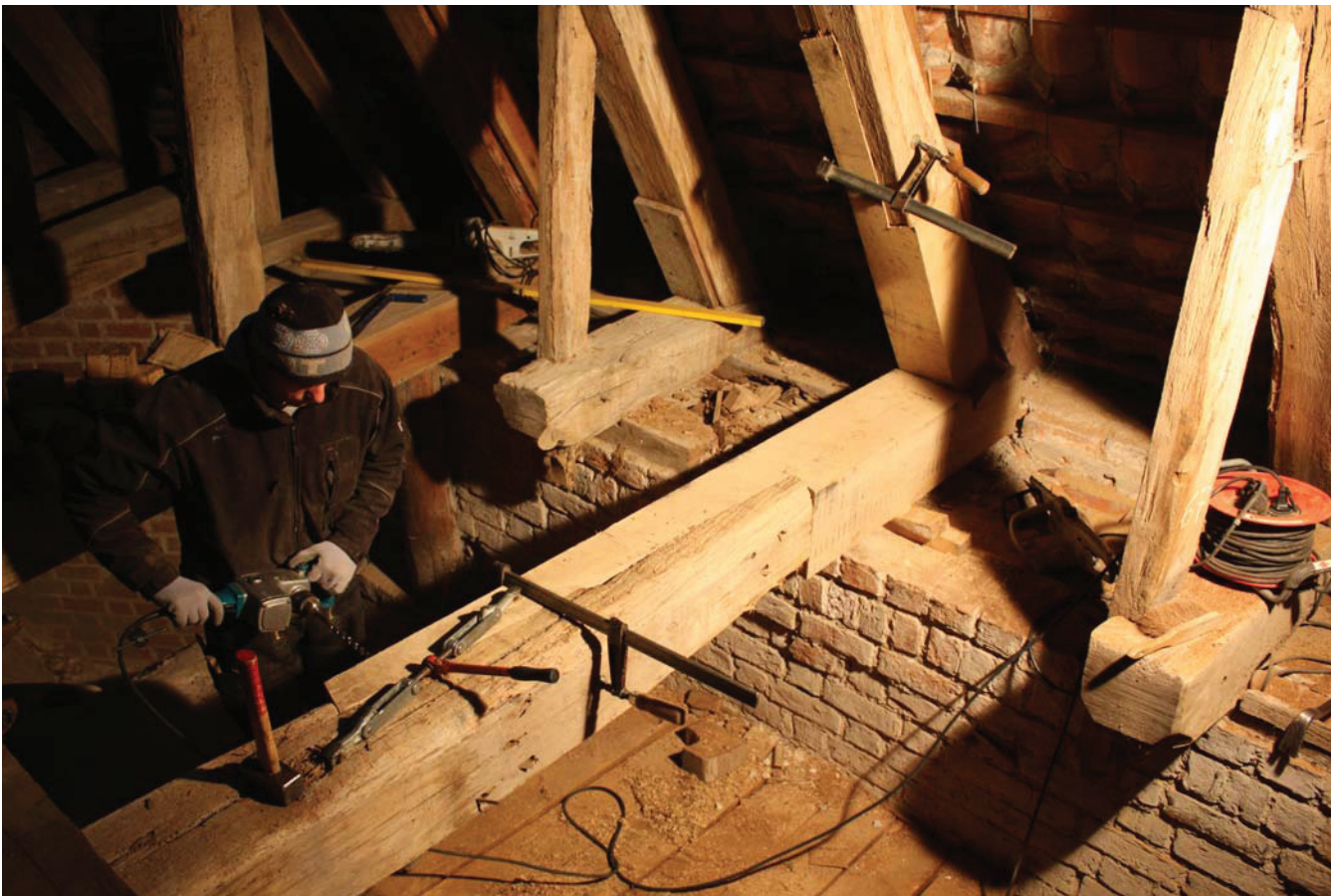
Bild 6.15 Vorbildliche Instandsetzungsarbeiten in St. Petri in Altentreptow (NORDKURIER 2011/12).
