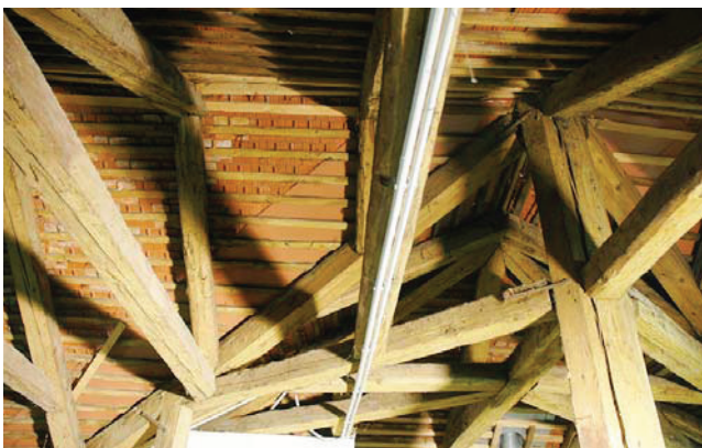
Bild A.6 Links: Firstsäule im Gratbereich, Rechts: klaffende Verbindungen am Firstpunkt. Fig. A.6 Left: ridge post in the hip area, Right: gaping joints at the ridge.
