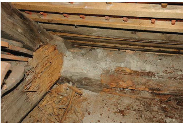
Bild A.9 Infolge von Pilzbefall geschädigte Mauerbank und Sparrenfußpunkte.
