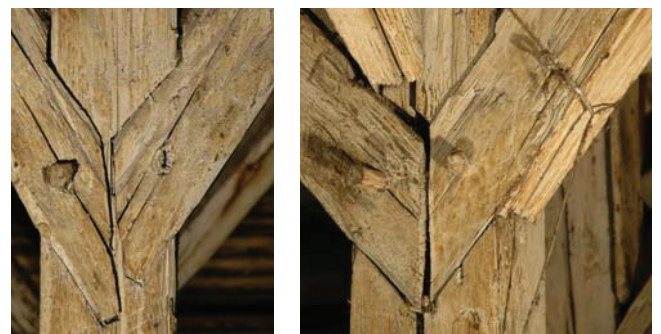
Bild 4D.4 Einseitige Schwalbenschwanz-Querblätter (Weißschwänze), Links: verdeckt, Rechts: unverdeckt.
