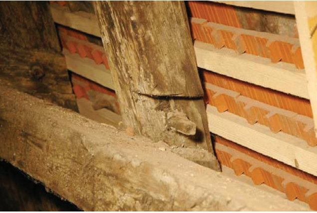
Bild A.55 Links: fehlender Kehlbalken, Rechts: Blick zum First – zahlreiche Kehlbalken wurden ersatzlos gekappt. Fig. A.55 Left: missing collar beam, Right: view to the ridge – numerous collar beams were cut without replacement.
