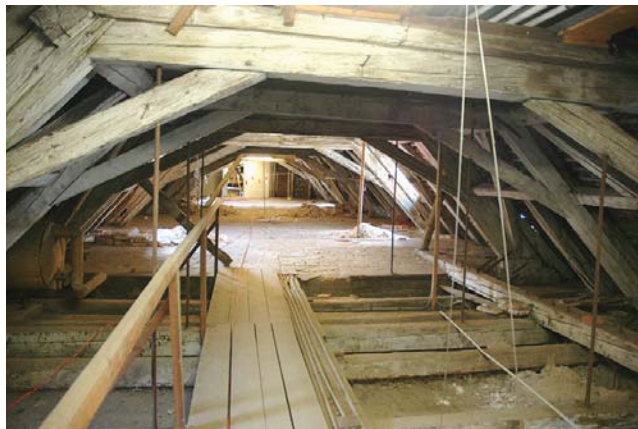
Bild A.58 Dachraum des Nordtraktes.
