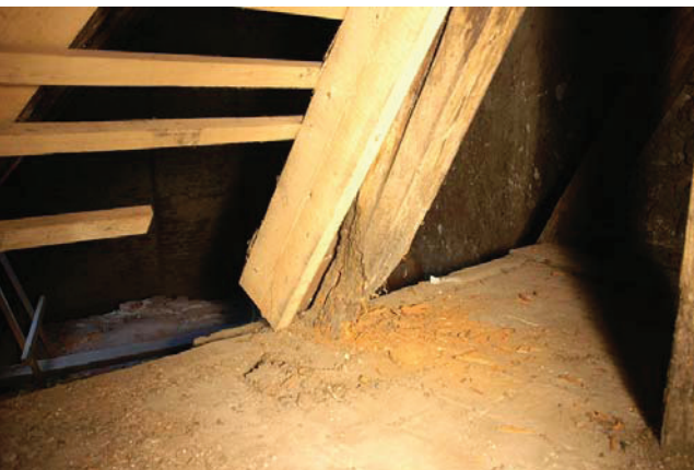
Bild A.57 Geschädigter Sparrenfußpunkt und teilweise zerstörte Verbindung infolge von Pilzbefall. Fig. A.57 Damaged rafter base and partially destroyed joint due to fungi.
