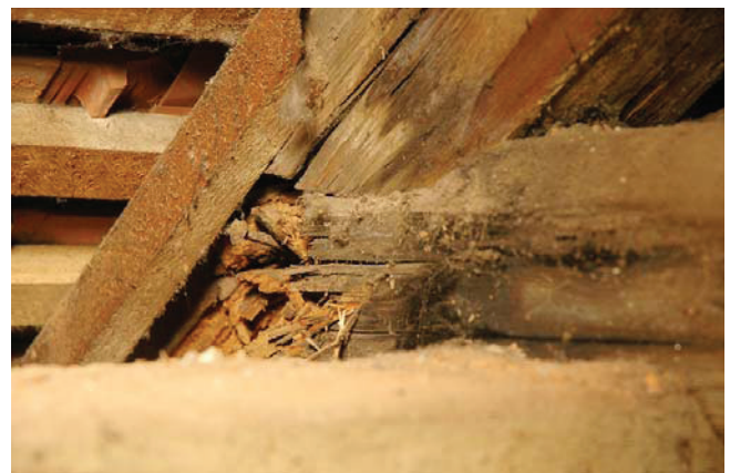
Bild A.10 Links: geschädigter Sparren, Rechts: geschädigte Sparren-Kehlbalken-Verbindung.
