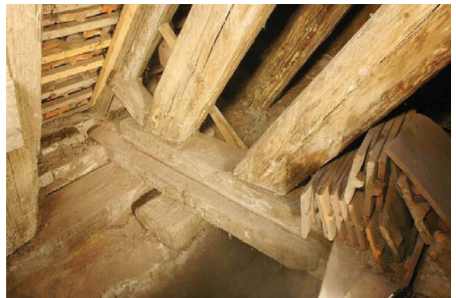
Bild A.45 Links: verschmutzter Sparren-/Strebenfußpunkt, Rechts: grob gereinigter Sparren-/Strebenfußpunkt. Fig. A.45 Left: dirty rafter/strut base, Right: roughly cleaned rafter/strut base.
