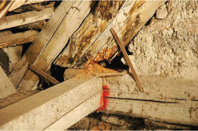
Bild A.29 Links: geschädigter und mangelhaft instand gesetzter Stuhlsäulenfußpunkt von VG 1, Rechts: Bundtrankkopf von VG 3. Fig. A.29 Left: damaged and incompetent repaired raking strut base of PT 1, Right: tie-beam head of PT 3.
