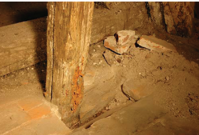
Bild A.56 Links: leicht geschädigter Stuhlsäulenfußpunkt, Rechts: klaffende Blattverbindung an einem Rähmstoß. Fig. A.56 Left: partially damaged post base, Right: gaping lap at a collar plate butt.
