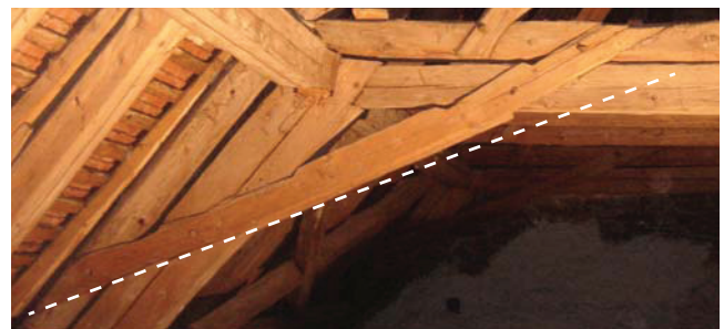
Bild 4A.10 Biegung eines eingeblatteten Kopfbandes (BUCHHÄUSL (2010)).
