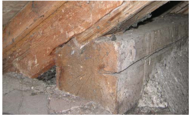
Bild 4B.15 Gaißfuß an einer Fußpfette (Rechbauerstr. 12, Graz).
