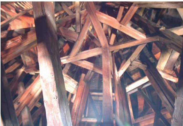
Bild 6.2 Blick ins statisch hochgradig unbestimmte Tragwerk des Turmdachs der Franziskanerkirche.
