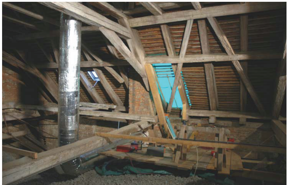
Bild 5.1 Instandsetzungsarbeiten (2011) in der Alten Universität Graz.
