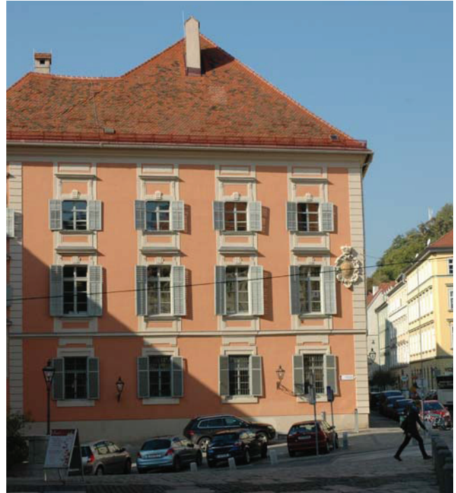
Bild A.31 Ansicht der Fassade stirnseitig. Fig. A.31 View of the end facade.
