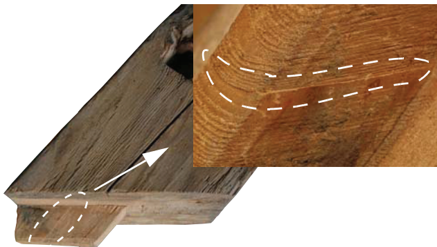
Bild 6.4 Schräger Zapfen an einem Stuhlsäulen-Fußpunkt mit Schubversagen.
