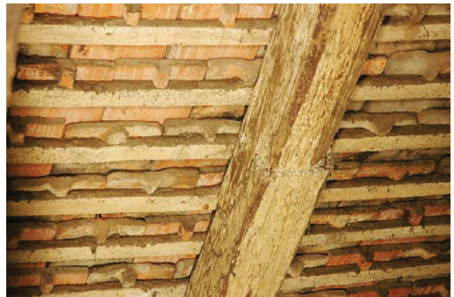
Bild A.51 Nicht fachgerechte Instandsetzungen, Links: geschädigter Sparren mit Einstückelung, Rechts: Sparrenstoß mit liegendem Blatt. Fig. A.51 Incompetent interventions, Left: damaged rafter with shaped part, Right: rafter butt with horizontal lap.
