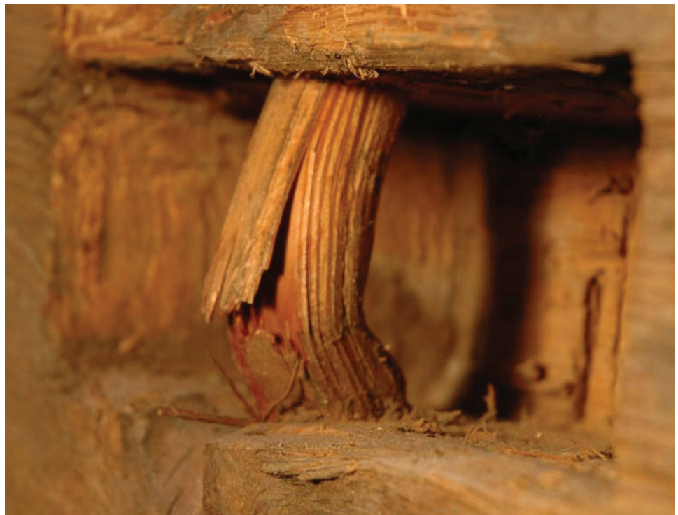
Bild 4C.1 Zapfenloch mit auf Biegung versagtem Weichholznagel. Fig. 4C.1 Mortice with timber peg from soft wood failed in bending.
