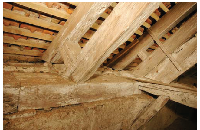
Bild A.22 Verschiedene Stuhlsäulen- und Sparrenfußpunkte, alle mit historischen Instandsetzungen. Fig. A.22 Different bases of rafters and raking struts, all with historic interventions.
