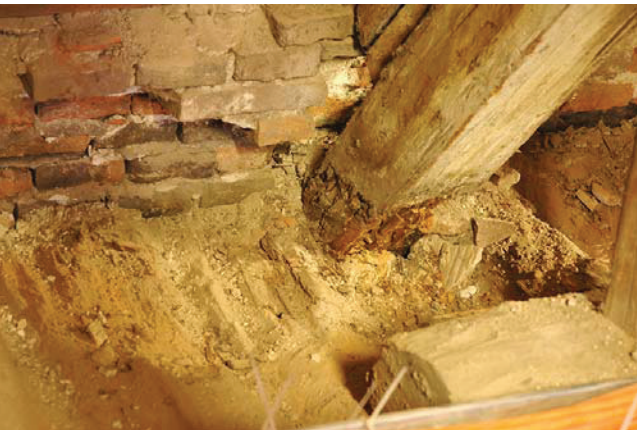
Bild A.66 Infolge Pilzbefall stark geschädigte Sparren- und Stuhlsäulenfußpunkte. Fig. A.66 Seriously damaged rafter and raking strut bases due to fungi.
