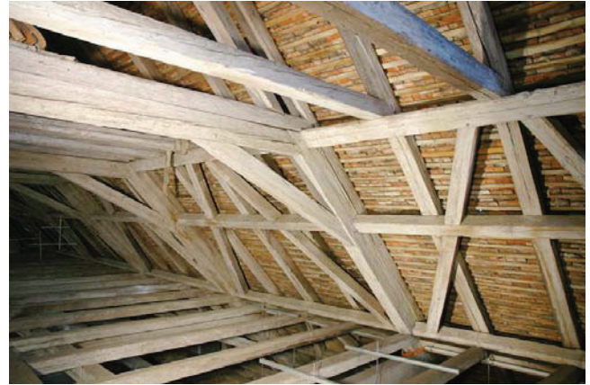
Bild A.33 Kehlbalkendach mit zweistöckigem, liegendem Stuhl, Links: 1. Stockwerk Rechts: 2. Stockwerk.
