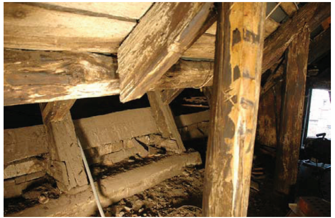
Bild A.39 Links: eingemauerte Tragwerksteile, Rechts: die Innenrinne (vom Dachraum aus betrachtet, hier existiert der Rinnenträger). Fig. A.39 Left: walled members, Right: inner gutter (view from the attic, with existing support).
