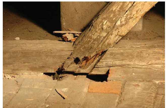
Bild A.57 Geschädigter Sparrenfußpunkt und teilweise zerstörte Verbindung infolge von Pilzbefall. Fig. A.57 Damaged rafter base and partially destroyed joint due to fungi.
