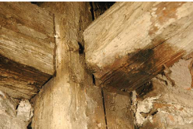
Bild A.40 Links: klaffende Zapfenverbindung von Kehlbalcken-Stuhlsäule, Rechts: gekappte Streben und Sparren (Kamindurchdringung, Rinne). Fig. A.40 Left: gaping mortise and tenon joint of collar beam and post, Right: cut off struts and rafters (chimney, inner gutter).
