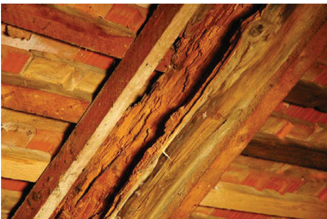
Bild A.10 Links: geschädigter Sparren, Rechts: geschädigte Sparren-Kehlbalken-Verbindung.
