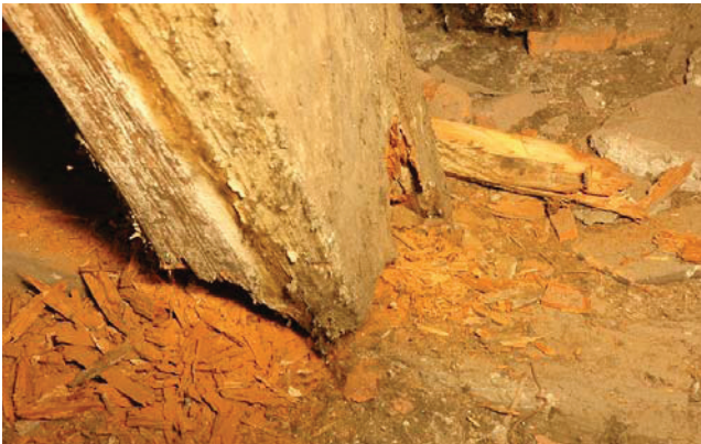
Bild A.47 Links oben, unten und Rechts oben: geschädigter Sparrenfußpunkt vor und nach der Bearbeitung mit der Hammerspitze, Rechts unten: die Mauerbank ist infolge von Innenfäule zerstört (siehe Eindringtiefe des Lattenhammers).
