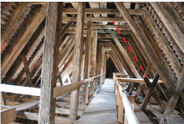
Bild A.50 Links: gekappte Strebe, Rechts: fehlendes Blatt eines Weißschwanzes. Fig. A.50 Left: cut off strut, Right: lacking of the dovetail lap joint.
