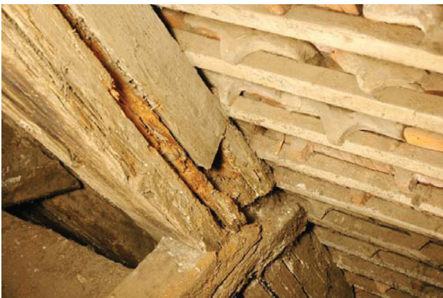
Bild A.51 Nicht fachgerechte Instandsetzungen, Links: geschädigter Sparren mit Einstückelung, Rechts: Sparrenstoß mit liegendem Blatt. Fig. A.51 Incompetent interventions, Left: damaged rafter with shaped part, Right: rafter butt with horizontal lap.
