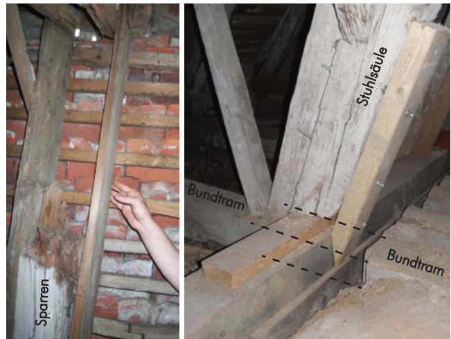
Bild 3.11 Nicht fachgerechte Instandsetzungen.
