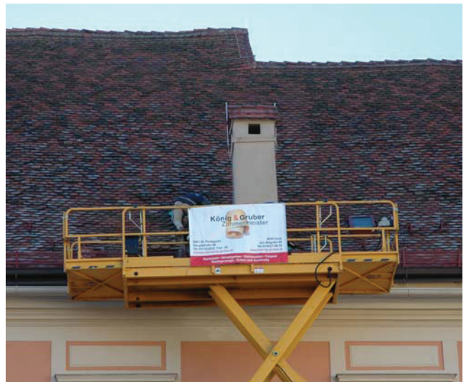
(b) lokales Entfernen der Dachdeckung von einer Scherenhubbühne aus
