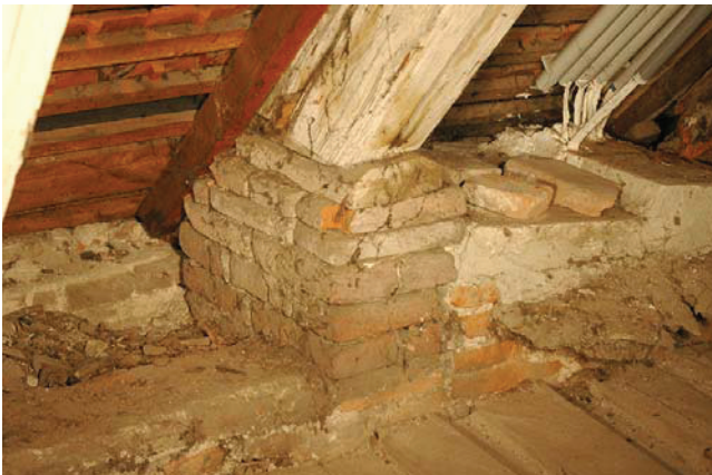
Bild A.64 Nicht fachgerechte Instandsetzungen an Sparren- und Stuhlsäulenfußpunkten.
