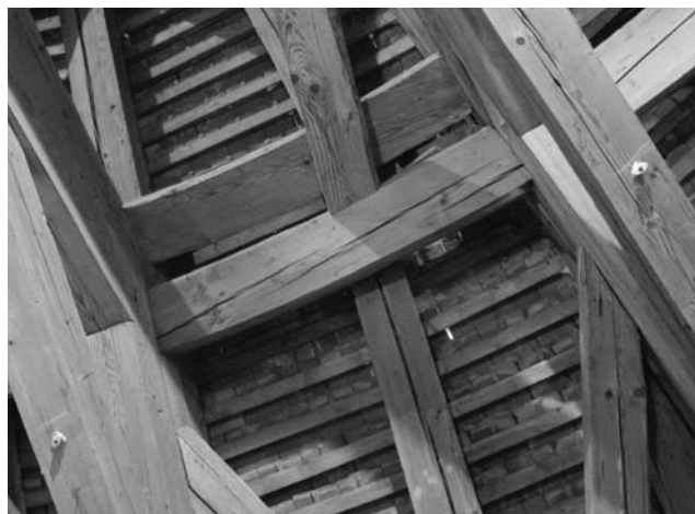
Bild 4A.26 Gekrümmt ausgesägte Rähm und Schwelle im Bereich der Apsis der Marienkirche Fürstenfeld.
