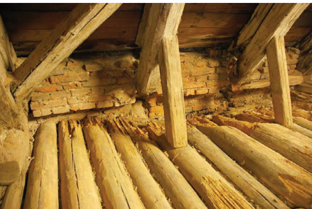
Bild A.67 Zerstörter Auflagerbereich der Dippelbaumdecke. Fig. A.67 Destroyed support areas of the „Dippelbaum“-ceiling.
