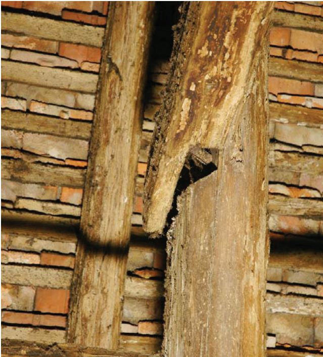
Bild A.49 Links: klaffende Weißschwanzverbindung, Rechts: versagte Weißschwanzverbindung. Fig. A.49 Left: gaping dovetail lap joint, Right: failed dovetail lap joint.
