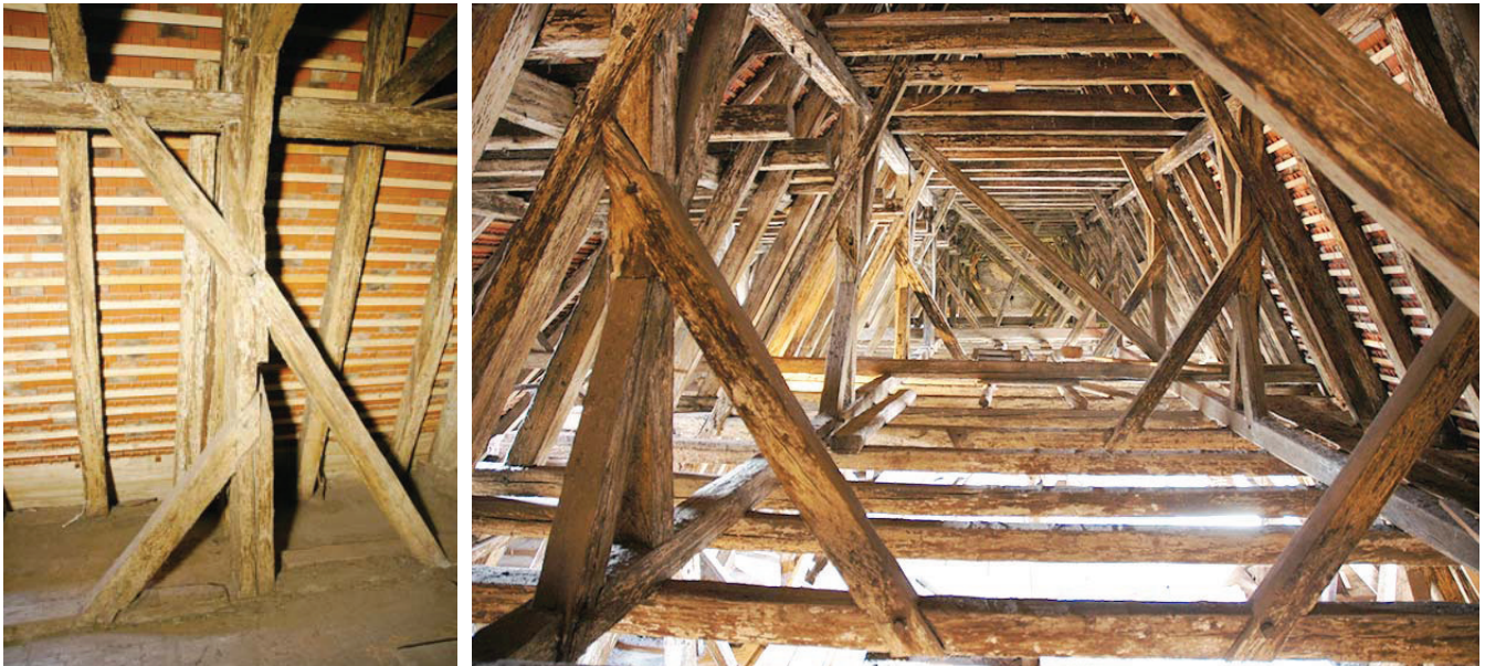
Bild A.53 Links: Stuhlwand im ersten Stockwerk, Rechts: Übersicht des zweiten Stockwerks. Fig. A.53 Left: braced longitudinal wall in the first floor, Right: overview in the second floor.
