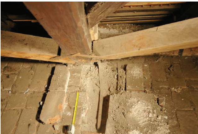
Bild A.14 Nicht fachgerechte Instandsetzung der Stuhlsäulenfußpunkte. Fig. A.14 Incompetent interventions of the raking strut bases.
