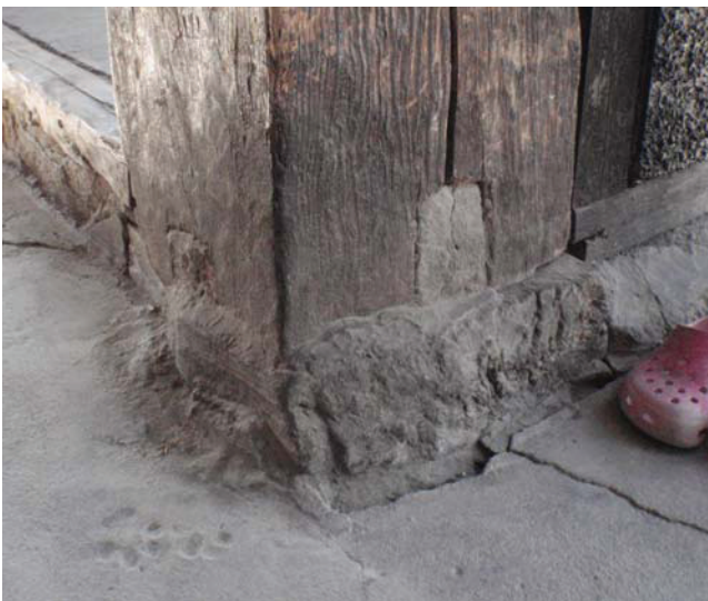
Bild 4B.16 Lagesicherung einer Tempelsäule mit steinernem Kreuzzapfen (Ladakh/Westhimalaya).
