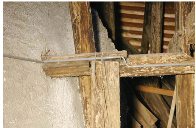
Bild A.56 Links: leicht geschädigter Stuhlsäulenfußpunkt, Rechts: klaffende Blattverbindung an einem Rähmstoß. Fig. A.56 Left: partially damaged post base, Right: gaping lap at a collar plate butt.
