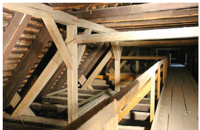
Bild A.12 Links: liegender Stuhl des Kehlbalkendachs. Rechts: 1. Kehlbalkenebene mit nachträglich eingefügtem Hängewerk. Fig. A.12 Left: trapezoidal portal frame of the collar beam roof, Right: 1. collar beam floor with afterwards inserted truss.
