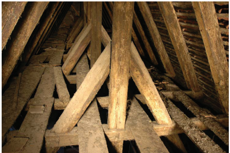
Bild 3.1 Firstbereich im Dachwerk der Franziskanerkirche von Graz.
