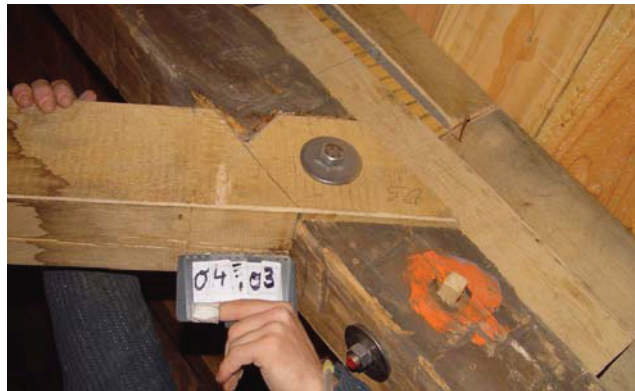
Bild 5.5 „Reine Reparatur“ eines zerstörten Hakenblattes mittels eines neuen Kehlbalckensegmentes, GÖTZ (2011).
