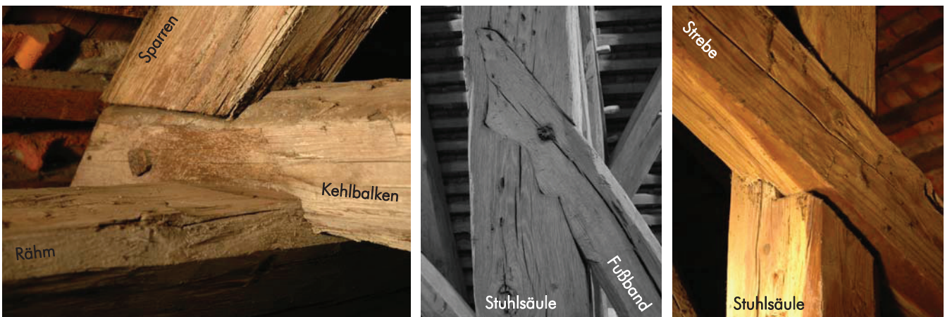
Bild 4D.2 Links: einseitiges, unverdecktes Schwalbenschwanzquerblatt (Weißschwanz) und Halbkamm (Palais Herberstein in Graz), Mitte: verdecktes Hakenquerblatt (Münster in Ingolstadt), Rechts: schräge Überblattung (Mandellstr. 9 in Graz).
