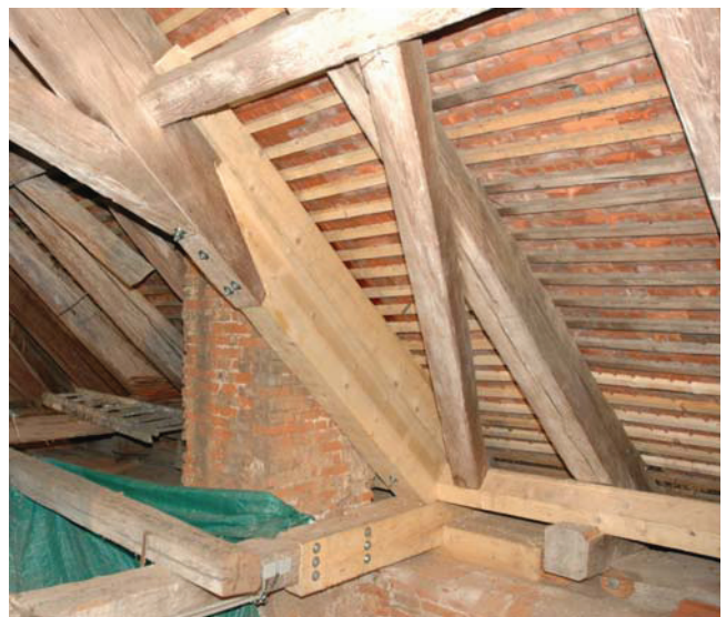
(f) die fertige Instandsetzung
