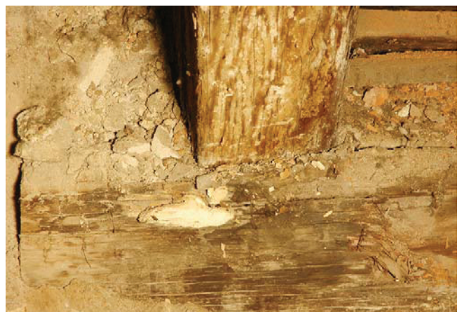
Bild A.46 Links: Bohrwiderstandsmessung durch einen Sparren, Rechts: Fruchtkörper des „Weißen Porenschwammes“. Fig. A.46 Left: drilling resistance measurement through a rafter rotten inside, Right: fruiting body of the "white pore sponge".
