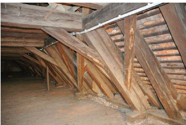
Bild A.12 Links: liegender Stuhl des Kehlbalkendachs. Rechts: 1. Kehlbalkenebene mit nachträglich eingefügtem Hängewerk. Fig. A.12 Left: trapezoidal portal frame of the collar beam roof, Right: 1. collar beam floor with afterwards inserted truss.
