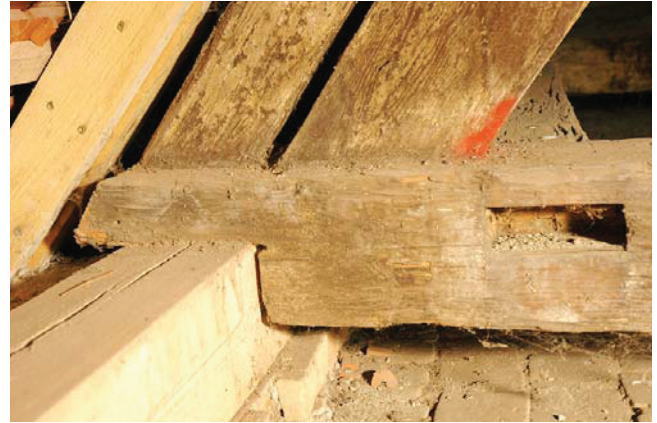
Bild A.29 Links: geschädigter und mangelhaft instand gesetzter Stuhlsäulenfußpunkt von VG 1, Rechts: Bundtrankkopf von VG 3. Fig. A.29 Left: damaged and incompetent repaired raking strut base of PT 1, Right: tie-beam head of PT 3.
