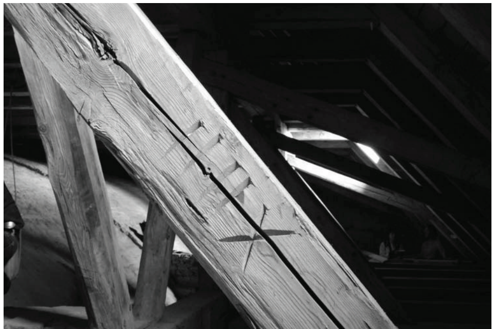
Bild 6.1 Abbundzeichen an einer Strebe in der Pfarrkirche Weyarn. Fig. 6.1 Carpenters mark at a strut in the church of Weyarn.
