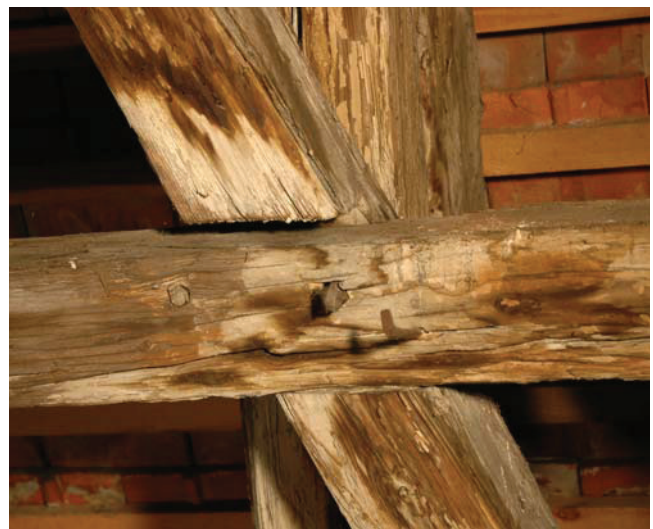
Bild C.2 Brustriegel-Windstreben-Knoten mit Passungenauigkeit.
