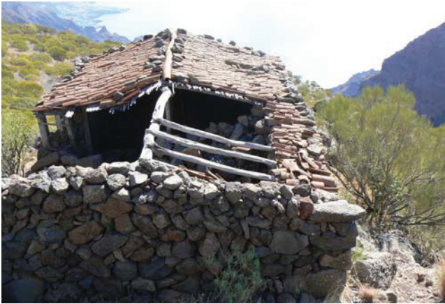
Bild 4B.5 Ansicht einer Finca auf Teneriffa mit Pfettendach. Fig. 4B.5 View of a finca in Teneriffa with purlin roof structure.
