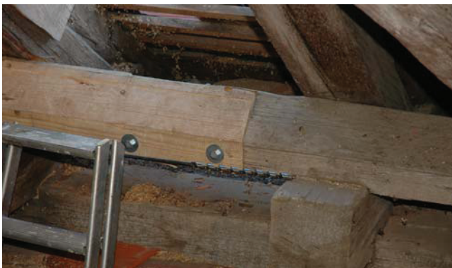
(e) neue Schwelle, mit stehendem Blatt angeschlossen
