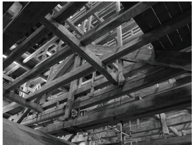
Bild 6.14 Ausschnitt aus dem Dachraum des Münsters in Ingolstadt.
