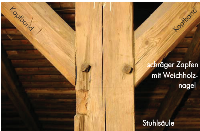
Bild A.5 Verbindungen in der Stuhlwand des Südosttraktes. Fig. A.5 Joints in the baced longitudinal wall of the southeast wing.
