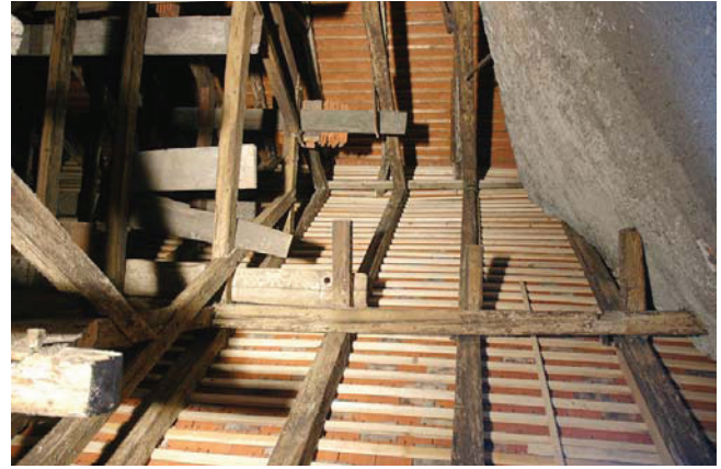
Bild A.55 Links: fehlender Kehlbalken, Rechts: Blick zum First – zahlreiche Kehlbalken wurden ersatzlos gekappt. Fig. A.55 Left: missing collar beam, Right: view to the ridge – numerous collar beams were cut without replacement.
