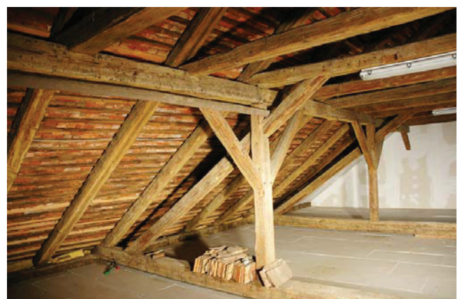
Bild A.2 Links oben: einfaches Kehlbalkendach, Rechts oben: Grat- und Walmbereich, unten: Kehlbalkendach mit Stuhl (Südosttrakt). Fig. A.2 Top Left: collar beam roof structure, top Right: hip area, below: collar beam roof structure with frame (southeast wing).
