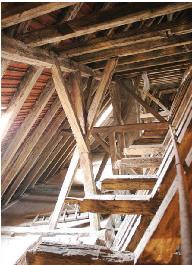
Bild A.52 Links: hinzugefügte Stuhlwand, Rechts: Pfettenstrang (von Stützböcken getragen).
