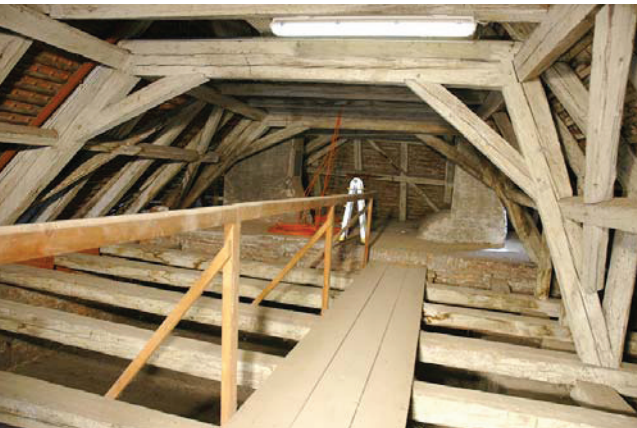
Bild A.61 Dachraum des Osttraktes (südlicher Bereich). Fig. A.61 Attic of the eastern wing (southern part).
