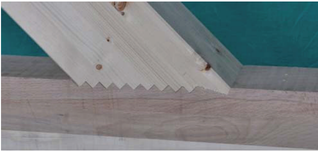
Bild 6.8 Trepperversatz, BLASS U. ENDERS-COMBERG (2012, S. 67).
