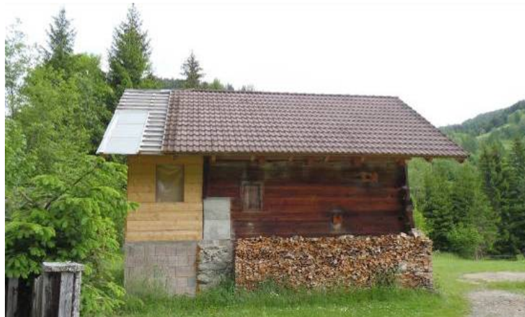
Abb. 194 Ehemalige Getreidemühle am Schöderbach. Vom ursprünglichen Gebäude blieben die Blockwand und Reste des Steinsockels erhalten, Aufnahme am 19.6.2010.
