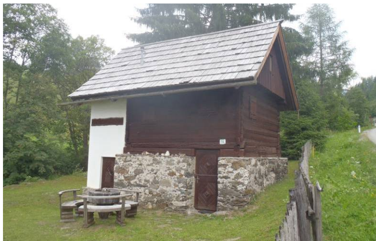
Abb.197 Beispiel einer für den Ferientourismus umgebauten ehemaligen Hausmühle am Schönbergbach, bei der die Sanierungs- und Adaptierungsmaßnahmen im System des Bestandes gehalten wurden, um das homogene Erscheinungsbild des Gebäudes zu erhalten, Aufnahme am 2.7.2012
