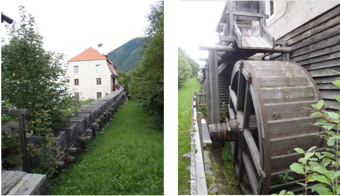
Abb. 15 Westansicht der Mühlenanlage (A) und Detailaufnahme des ober-schläch-tigen Wasserrades (B) der erhaltenen, einläufigen Mautmühle in St. Lambrecht, Aufnahmen am 11.9.2010
