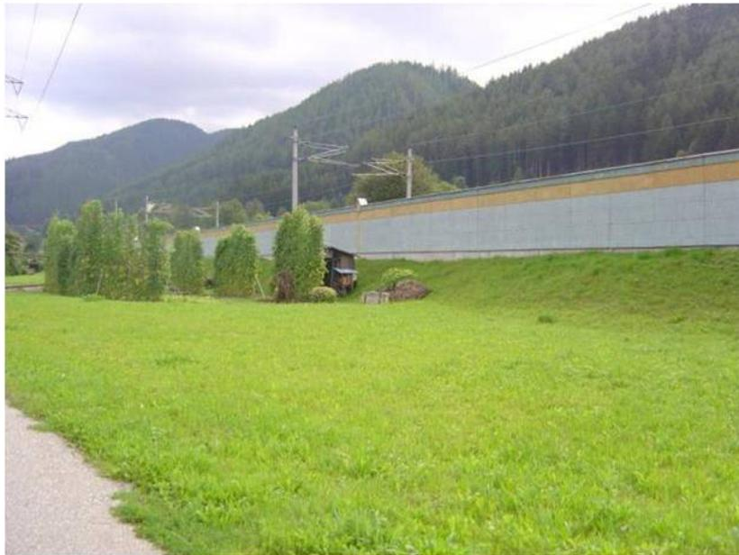
Abbildung 2.6: Unterschiedliche Hinterfüllung der Lärmschutzwand im Außenbereich [Holzfeind 2009]
