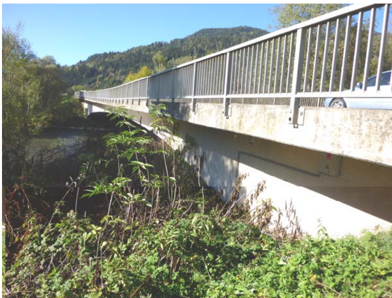
4.2.3 a Ansicht Brücke Lind
