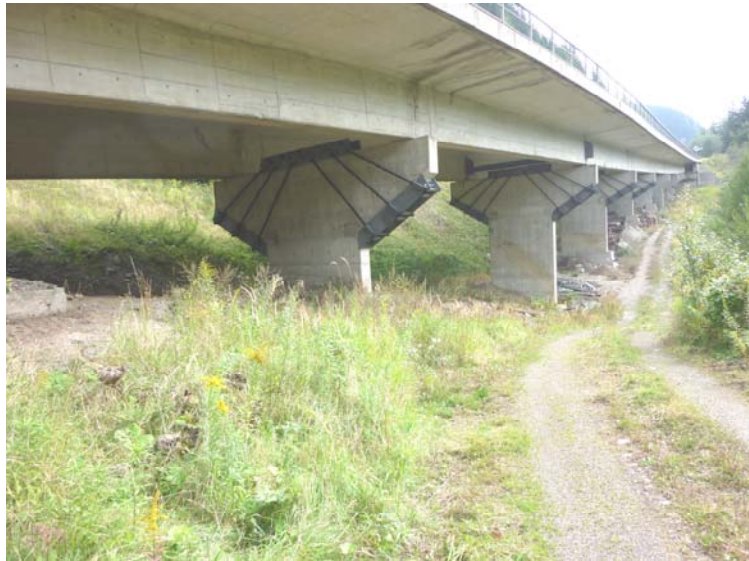
4.1.16.b Untersicht Brücke II
