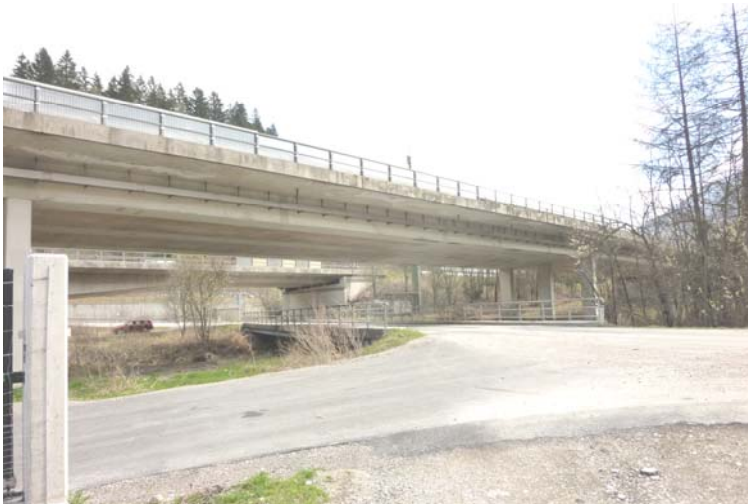
4.1.12.a Ansicht Brücke I
