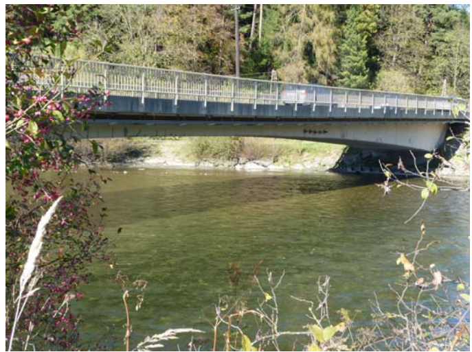
4.2.3 c Ansicht Brücke Teufenbach
