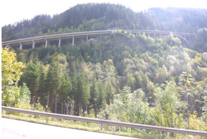
4.1.16 a Ansicht Brücke I
