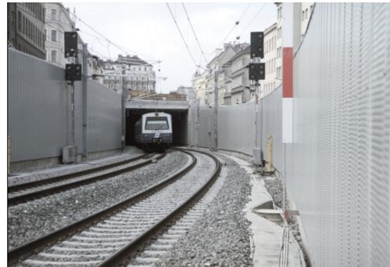
Abbildung 8: Lärmschutzsysteme im Freiland bzw. Tunnel
