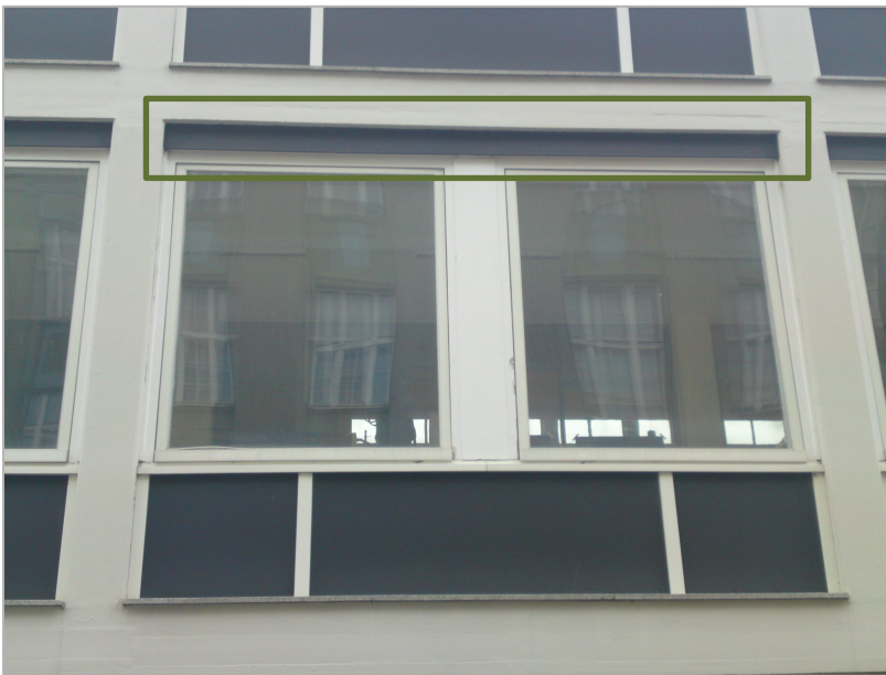
Abbildung 6-57: Durch Fassadenverkleidung überdeckter Fensteranschluss mit Markise
