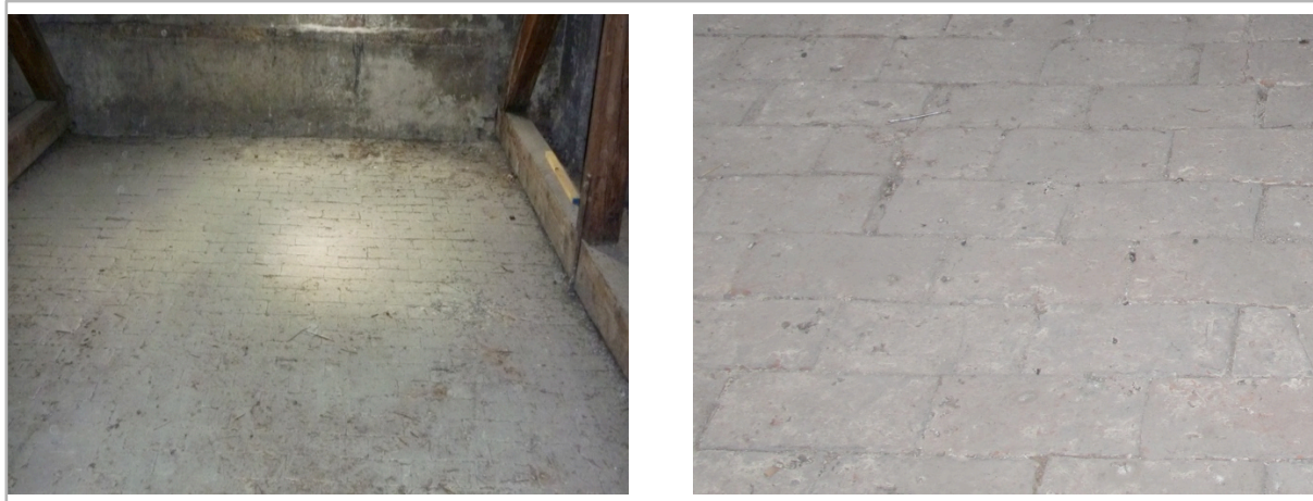
Abbildung 6-30: Darstellung des Fußbodens der obersten Geschoßdecke im Dachboden
