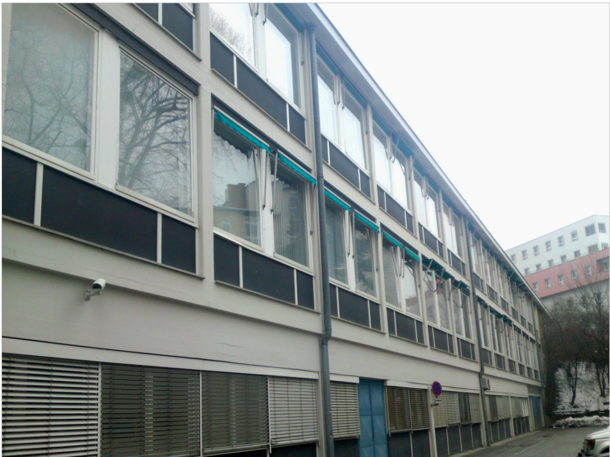
Abbildung 6-39: Charakteristische Außenfassade des Wasserbaulabors
