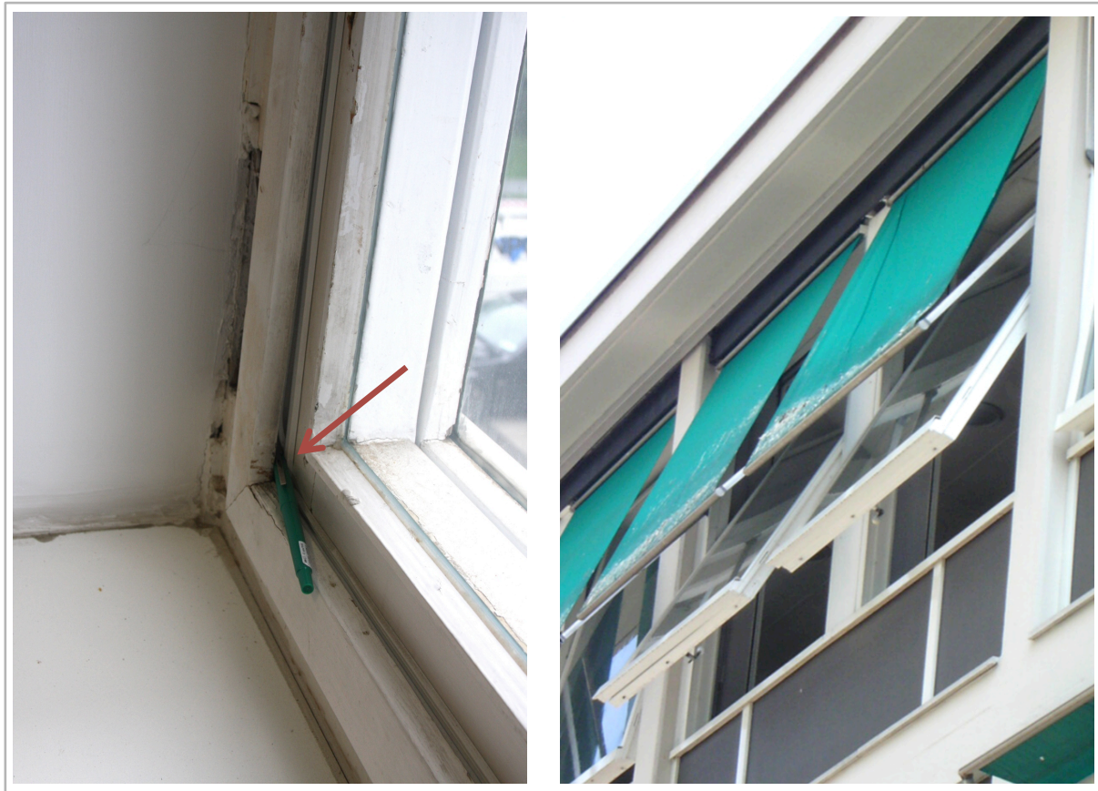
Abbildung 6-44: Vollständig geschlossenes Fenster (li) sowie Fenster im geöffneten Zustand in der Stremayrgasse 10
