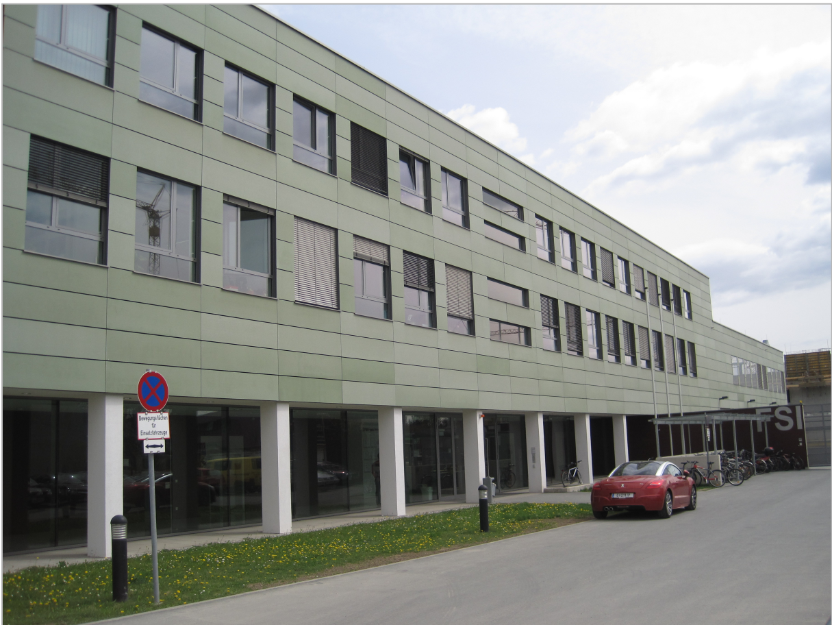
Abbildung 6-58: West-Ansicht FSJ mit Fensterkonstruktion
