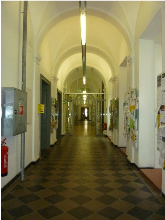
Abbildung 6-26: Ziegelgewölbe im Gangbereich der Alten Technik (Erdgeschoß)
