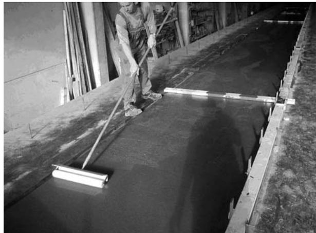
**Bild A 6.15 a) Betonage der Fertigteile b) Abziehen der Oberfläche mit einer Nadelwalze**
