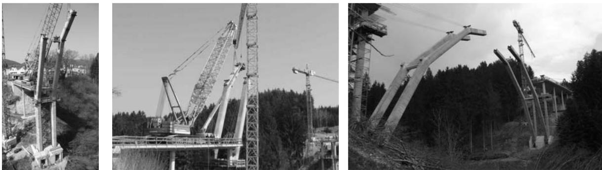
**Bild A 6.7 Bogenmontage und Einklappvorgang**
