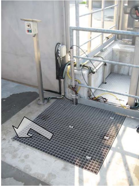
Abbildung 4.9: Trübungssonde im eingebauten Zustand im Zulauf der Vorklärbecken (Foto: Günter Gruber)
