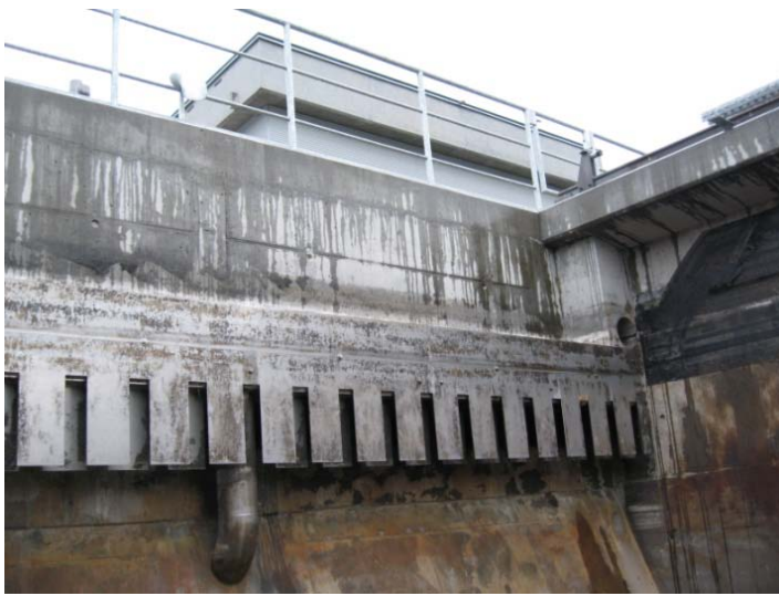
Abbildung 4.2: Lamellen im Einströmbereich (Foto: Günter Gruber)
