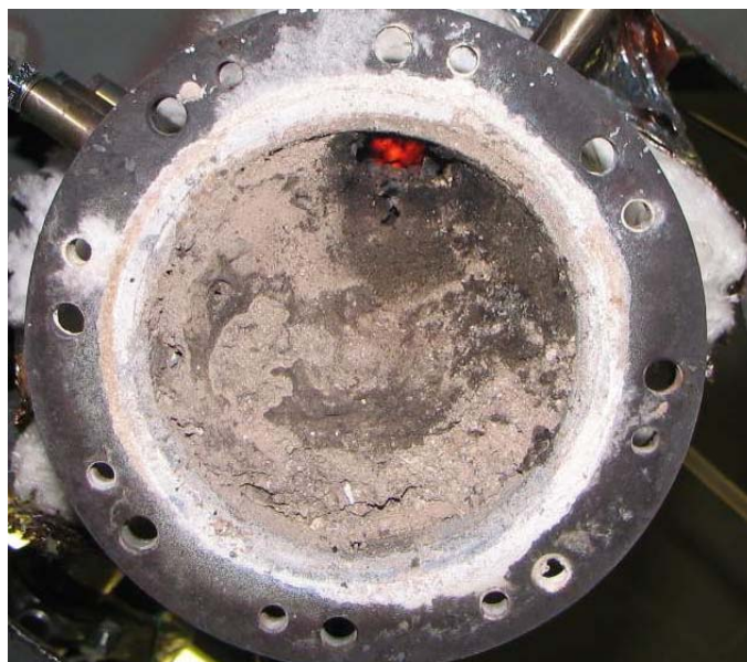
Abbildung 71: Blick in das Vergaserrohr der modifizierten Versuchsanlage 1 von unten Erläuterungen: Testlauf vom 26.09. bis 28.09.2007; Betriebsdauer 48 h; Brennstoff: Weichholzpellets
