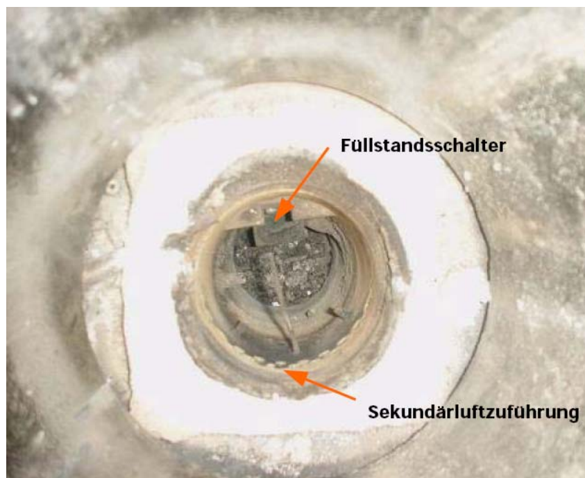
Abbildung 64: Blick auf das Brennstoffbett nach Testlauf
