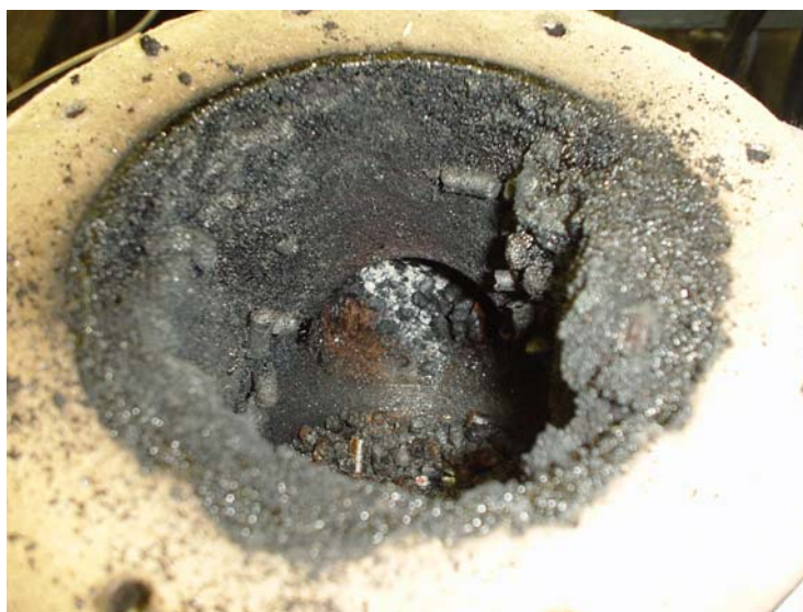
Abbildung 52: Pellets in der Fallrinne und Vergaserinnenwand
