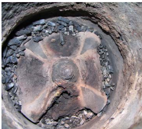
Abbildung 115: Blick in das Vergaserrohr auf das Primärluftkreuz
