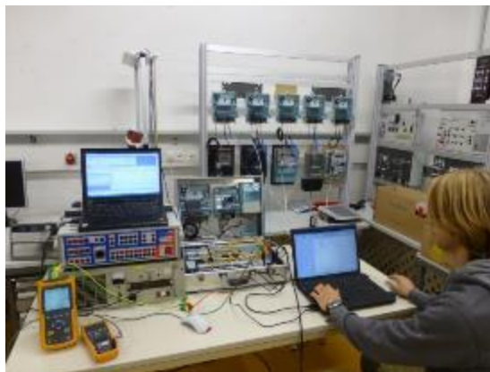
Abbildung 68: Testaufbau eines „Smart Emergency Grids“ im Smart-Grids-Labor des Instituts für Elektrische Anlagen mit AMIS-Smart Meter von Siemens
