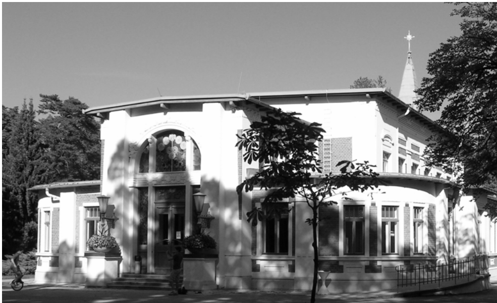
Abb. 64: EINGANGSFASSADE GESELLSCHAFTSHAUS, HEUTE
