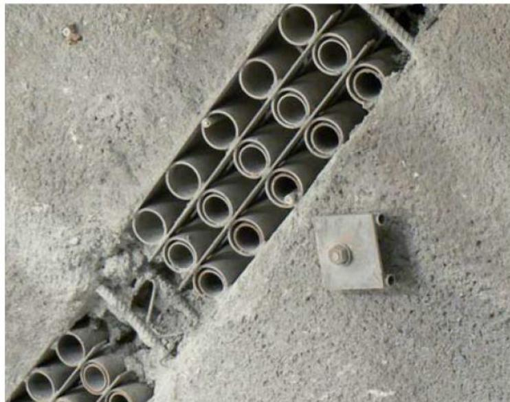
**Abbildung 5:** Stauchelement WABE mit Einschubrohren (Quelle: Bochumer Eisenhütte)
