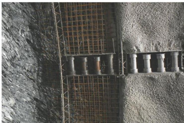
**Abbildung 1:** Eingebaute LSC (Foto: R. Vergeiner)
