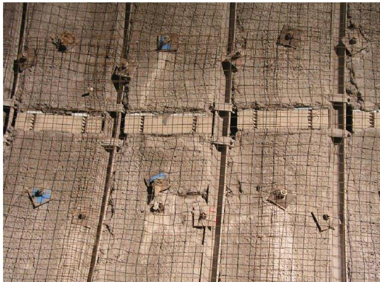
Abbildung 3: Eingebaute hiDCon-Elemente (Kovári, 2009)
