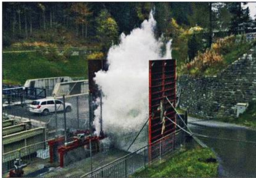
Abb. 34: "Blow Out" an der Wasserfassung des WKW Küblis/ Schweiz während des Testbetriebs (Arnason, Lardelli 2012)
