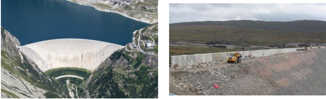
Abb. 5: a) Bogenstaumauer des Speichers Kölnbrein (Verbund 2014), b) Schüttdamm des Wasserkraftwerks Glendoe, Schottland
