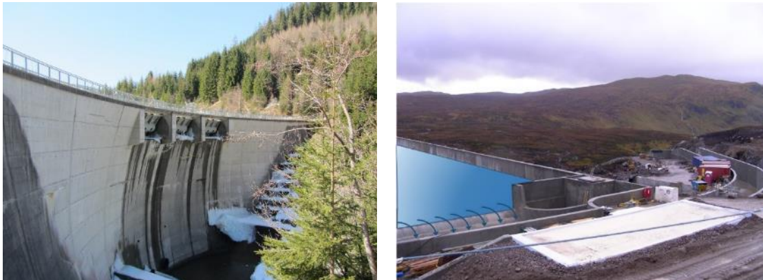
Abb. 10: a) Überfall mit steuerbaren Verschlüssen der Paalsperre, b) Überfall der Hochwasserentlastung des WKW Glendoe
