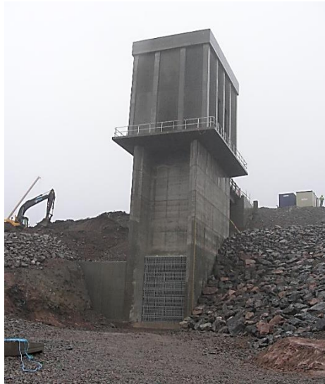
Abb. 13: Entnahmebauwerk des WKW Glendoe
