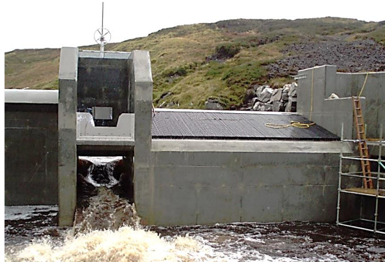
Abb. 16: Sohlentnahme am Intake 1 des Wasserkraftwerks Glendoe
