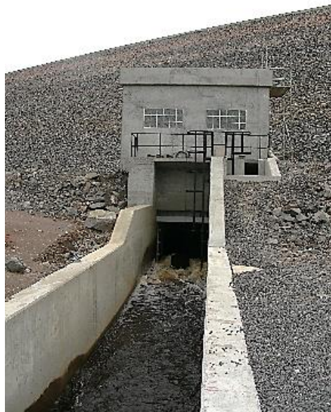
Abb. 11: Grundablass (luftseitig) des WKW Glendoe mit offenem Verschlussorgan
