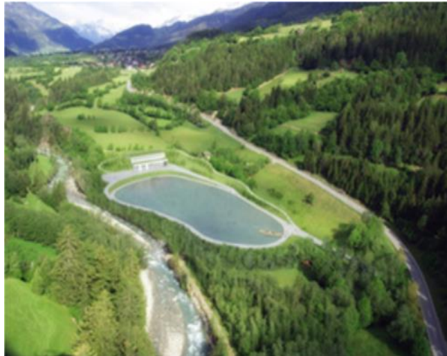
Abb. 29: Animation des Ausgleichsbecken im Bereich des Krafthauses Mitteldorf, WKW Obere Isel, (Der Virgentaler Weg 2013)
