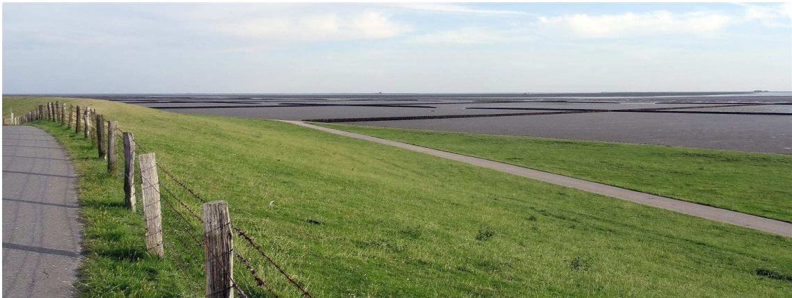
(a) Übersicht Kabelstrecke: Landesschutzdeich (links) und Hallig Gröde (rechts)
