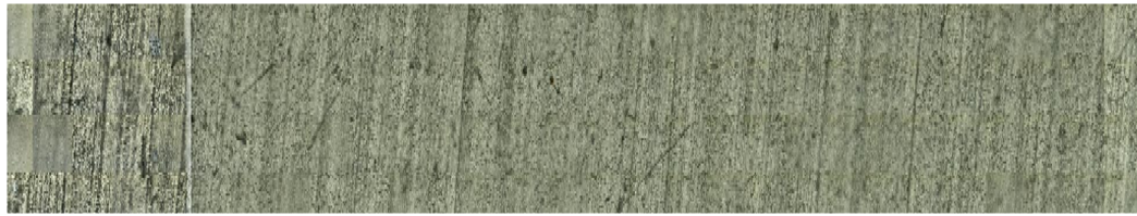
(a) 1-12-09-A1 Lichtmikroskopie - vor der Sanierung
