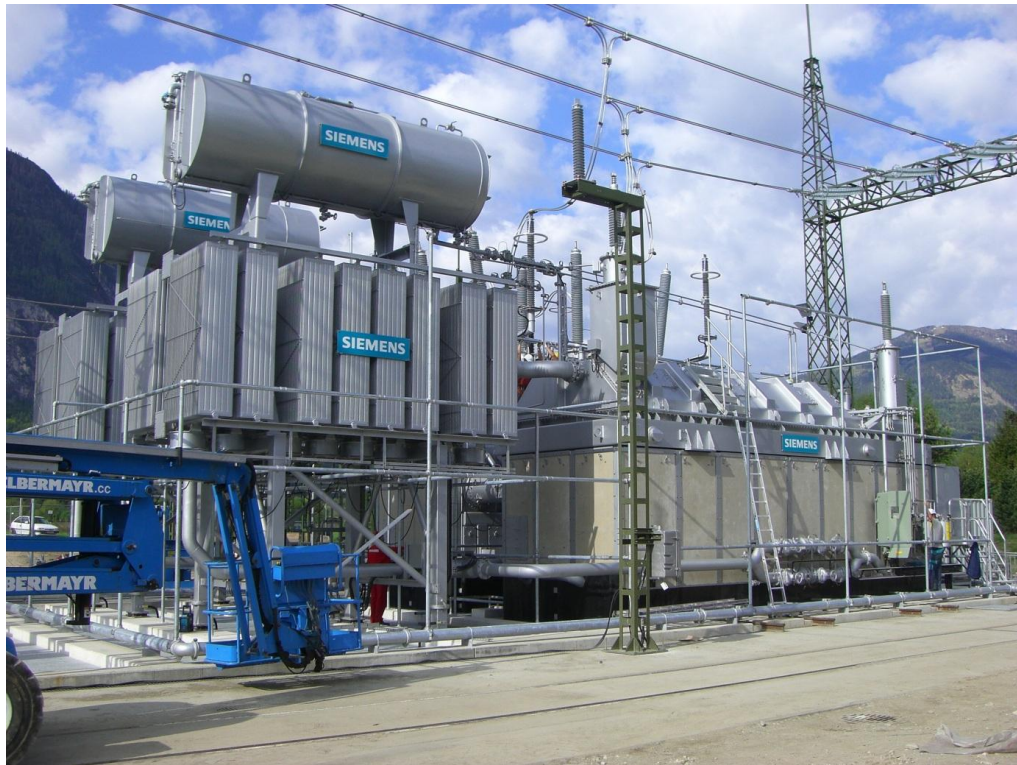
Abbildung 4-1 Foto, des in dieser Arbeit behandelten PST beim Aufstellen im Umspannwerk
