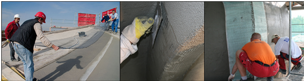
Abbildung 4.3: Anwendung von Textilbeton in der Verstärkung bzw. Instandsetzung bestehender Bauteile [26]
