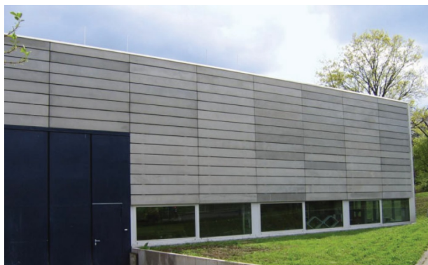
Abbildung 2.3: Fassadenplatten aus Textilbeton [12, S. 367]
