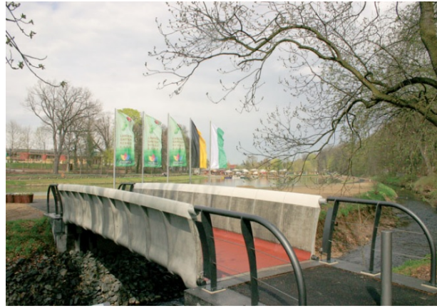
Abbildung 2.4: Brücke aus Textilbeton [11, S. 342]
