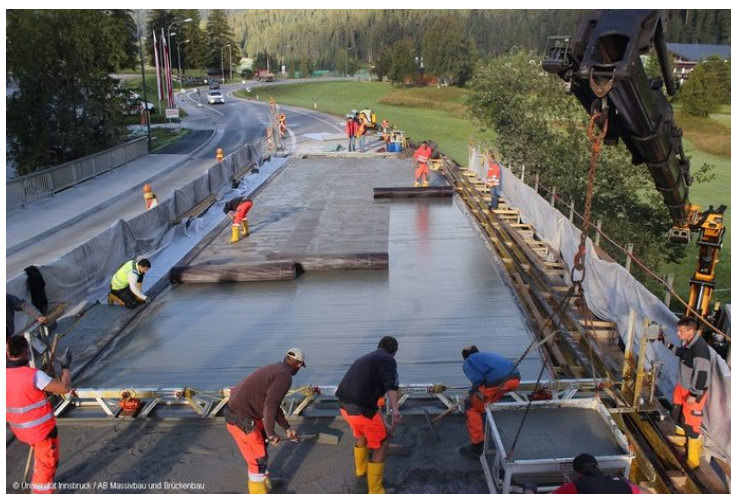
Abbildung 4.5: Anwendung von Textilbeton bei einer Bestandsbrücke [28]
