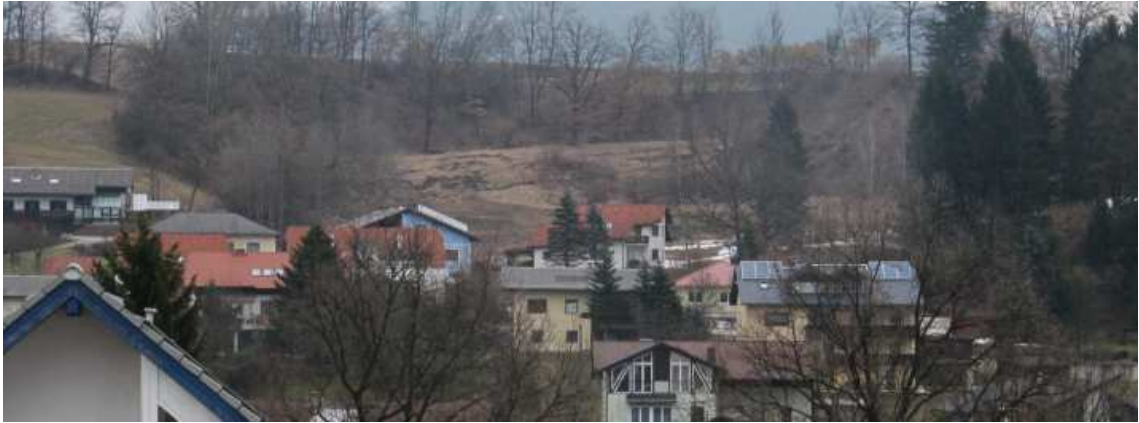
Abbildung 6-4 – Erdbeben im Oberhang der Siedlung Weinkorbweg
