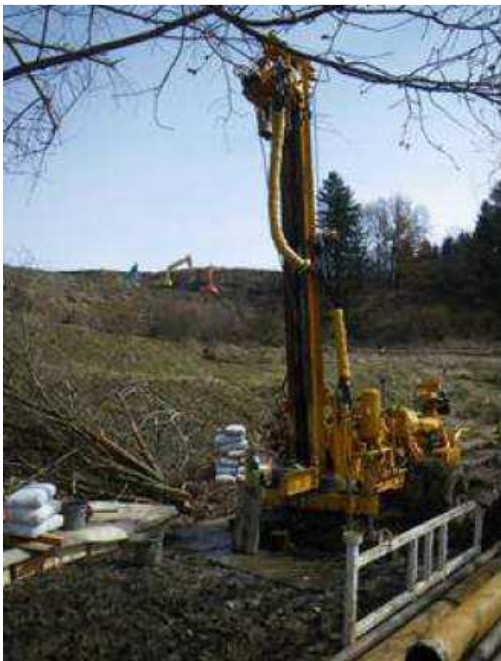
Abbildung 6-6 – Durchführung der Erkundungsbohrung
