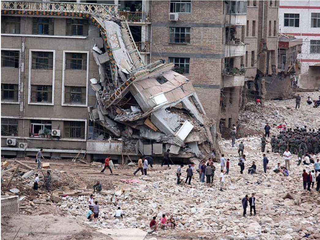
Abbildung 5-6 – Zerstörte Häuser in Zhouqu 231
