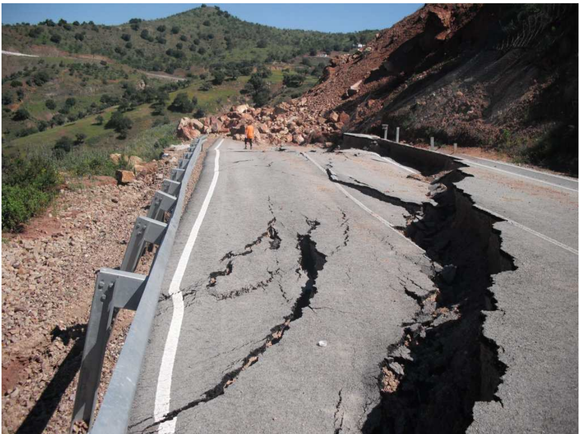
Abbildung 1-1 – Rutschereignis und Schadensausmaß (Beispiel aus Almogía) 3
