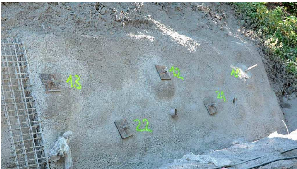
Abbildung 2-20 – Sicherung eines instabilen Hanges mit Felsankern 92
