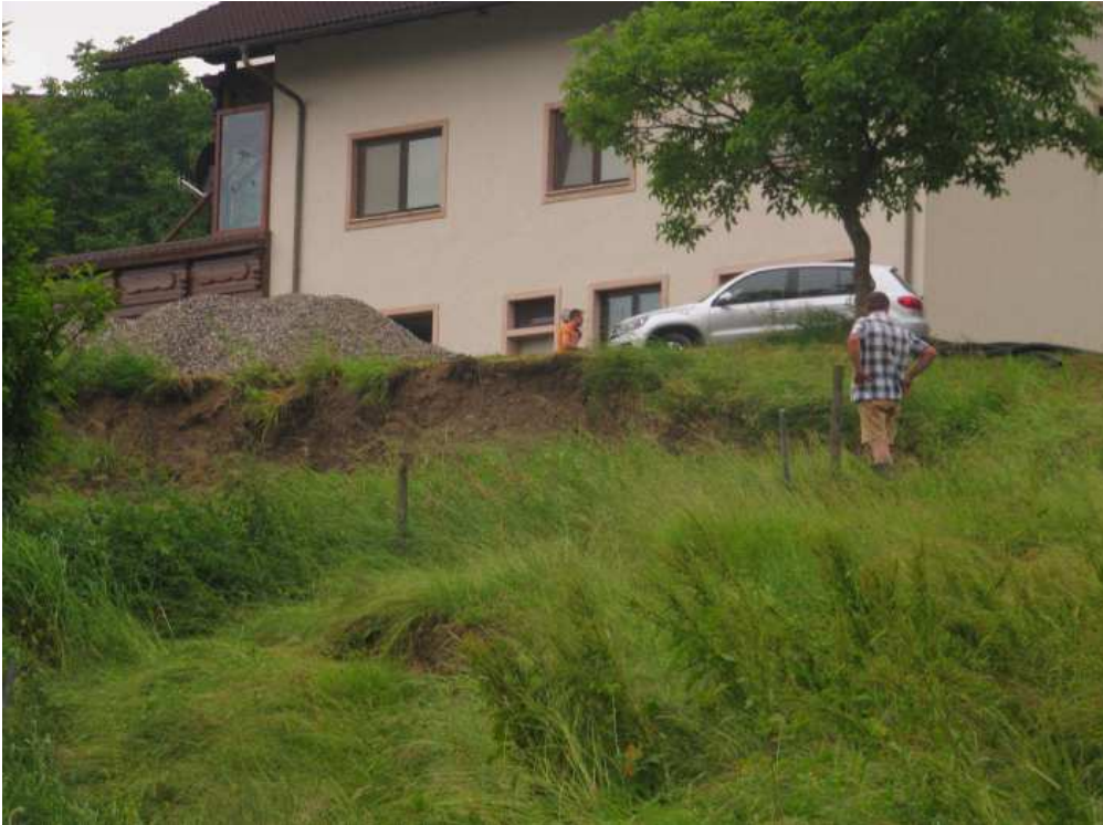
Abbildung 6-16 – Versatz am Hauptanbruch der Hangrutschung 255
