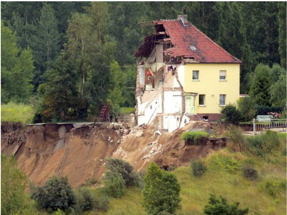
Abbildung 5-5 – Abgerissene Haushälfte als Folge des Erdbebens in Nachterstedt 227
