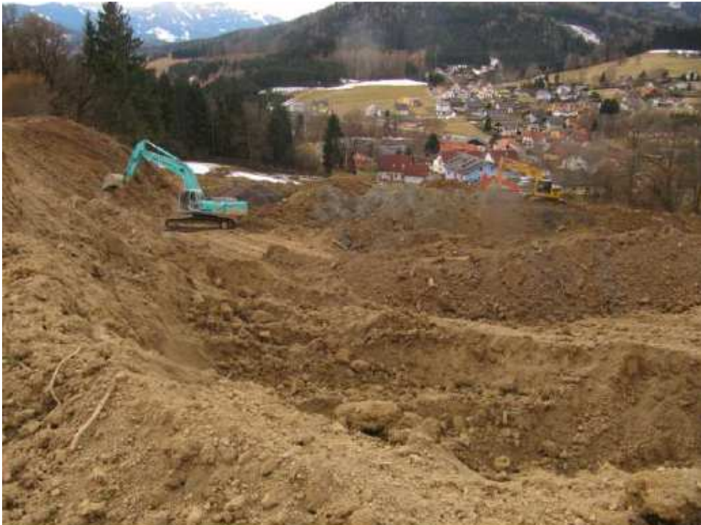
Abbildung 6-9 – Erdarbeiten zu Sanierungszwecken
