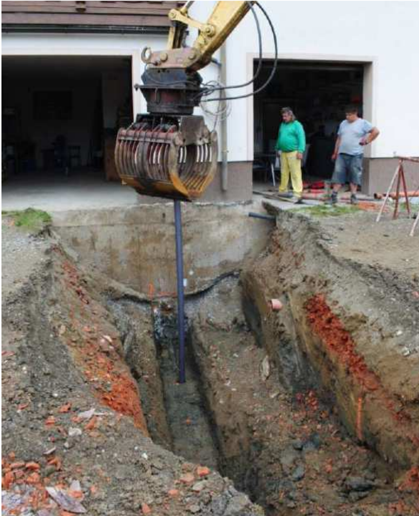
Abbildung 6-20 – Unterfangungsscheibe – Versetzen der Stahlrohre 263
