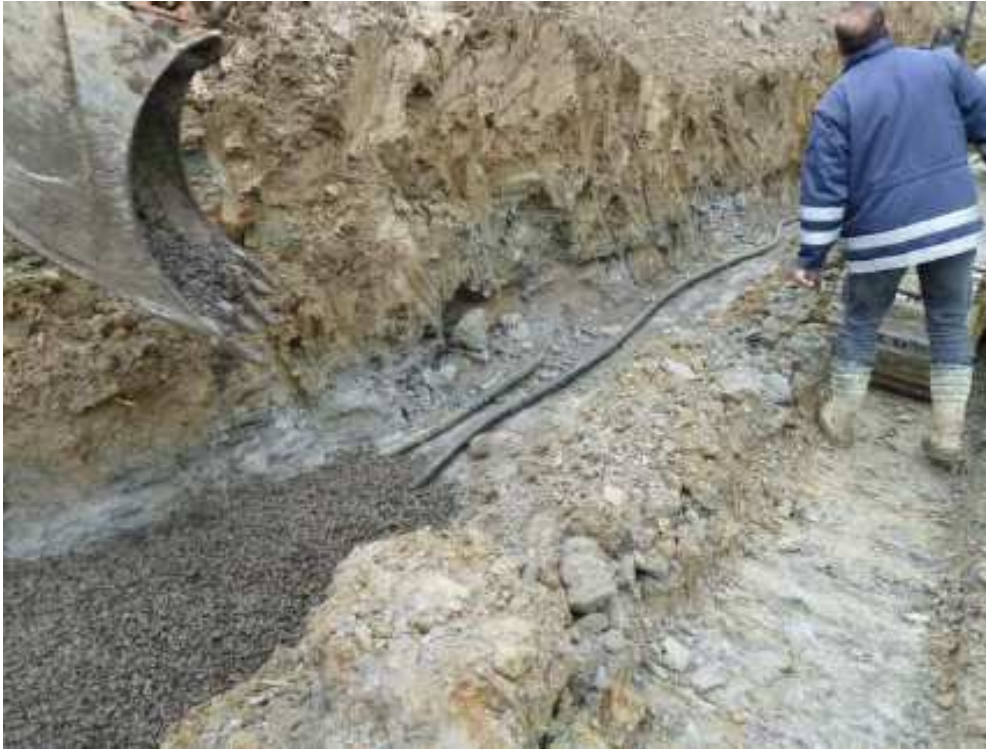
Abbildung 6-11 – Herstellen der Tiefendrainage
