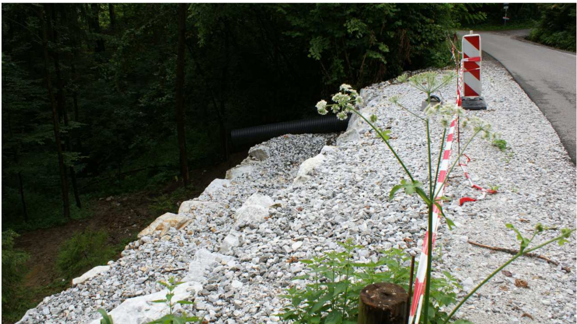
Abbildung 4-11 – Sanierung der Gnaninger Straße mittels Steinschichtung
