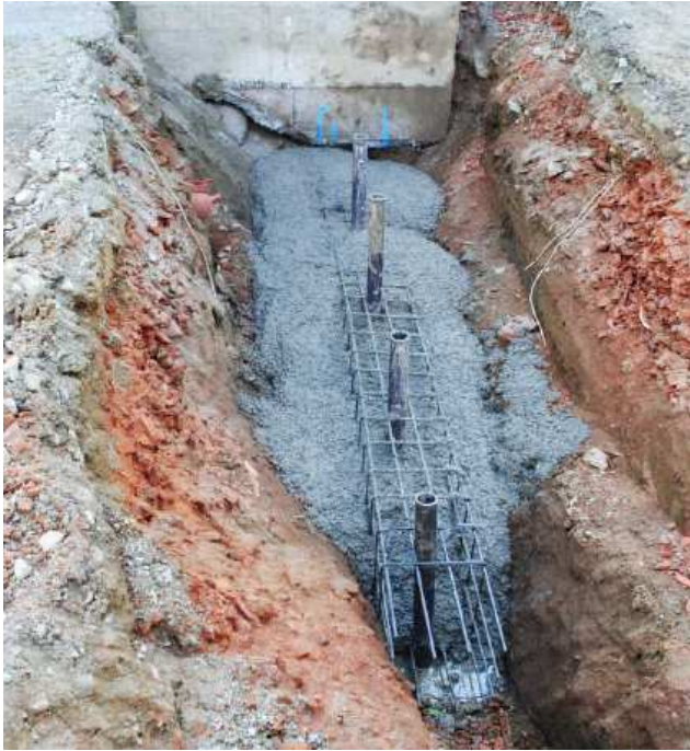
Abbildung 6-21 – Unterfangungsscheibe – Verfüllen der Stahlkorb-Stahlrohrkonstruktion mit Beton 264
