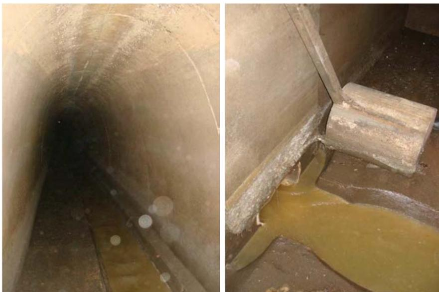
Abbildung 3-3: Innenansicht und Drossel einlauf des Stauraumkanals im Einzugsgebiet Graz-West R05 (Veit, 2009)
