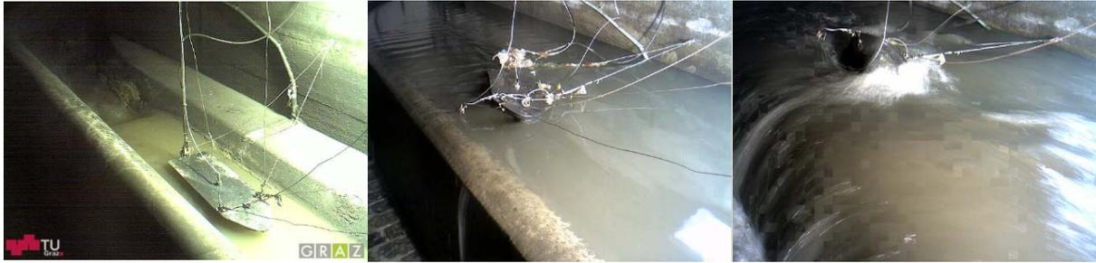
**Abbildung 3-8: Ponton in der Mischwasserüberlaufkammer (Gruber *et al.*, 2004)**
