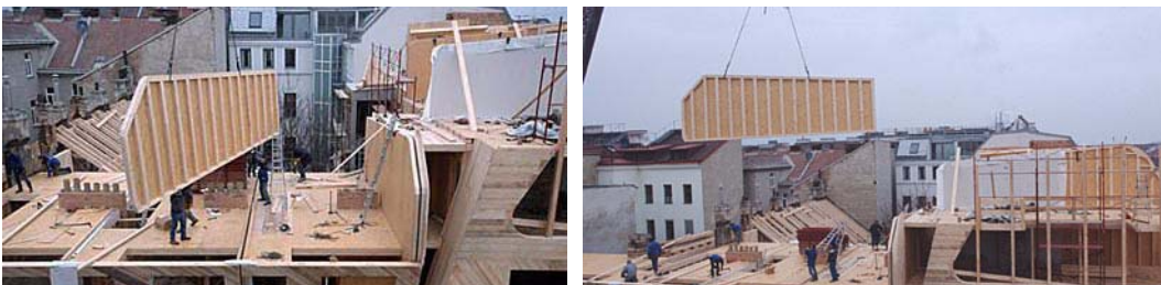
Abb. 5.5 Einheben der Holzelemente [22]
