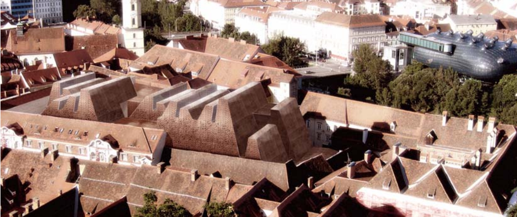
Abb. 2.5 Umstrittener Dachgeschossausbau: Kastner & Öhler (Graz) [Nieto Sobejano arquitectos]
