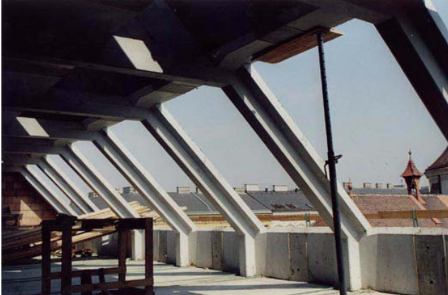
Abb. 2.18 Sargdeckelkonstruktion [wohnbeton.at]
