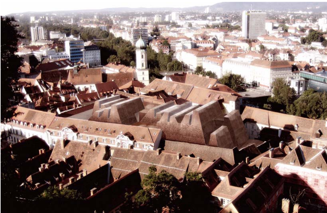
Abb. 5.9 Blick vom Schlossberg auf die zukünftige Innenstadt [[Nieto Sobejano arquitectos]
