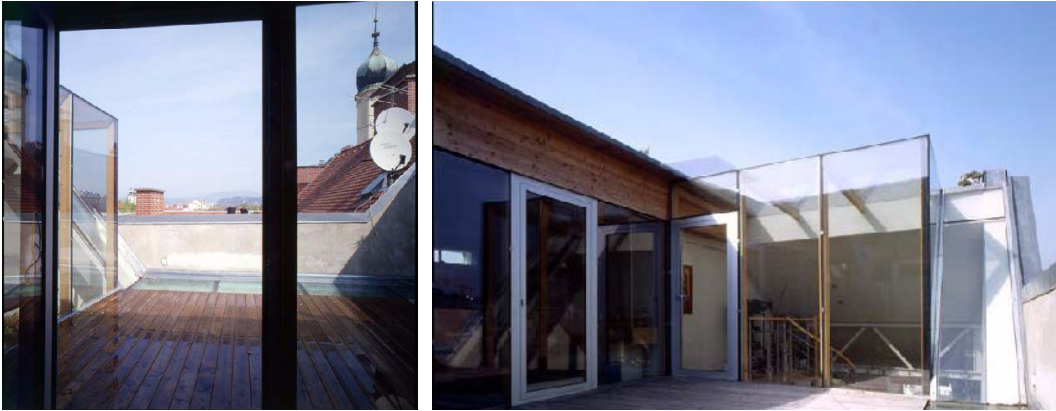
Abb. 5.11 Glasatrium mit Dachterrasse [18]
