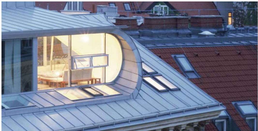
Abb. 2.1 Dachgeschossausbau [Arch. Leitner]
