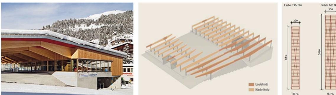
Abbildung 2.2: Parkgarage des Schischulzentrums in Arosa (rechts: Fotografie, Mitte: Tragstruktur der Brettschichtholzträger, links: Vergleich Eschen-Brettschichtholz zu Fichten-Brettschichtholz) (aus [64])
