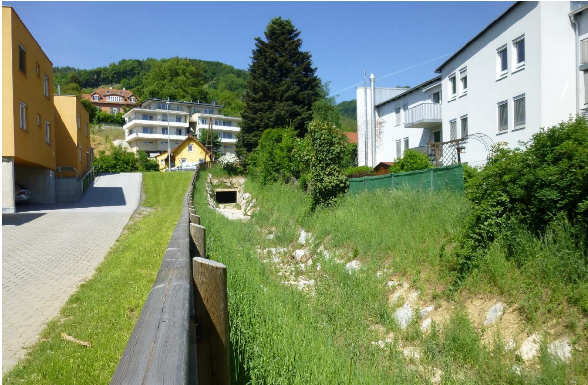
Abbildung 37: Durchlass Krottendorferstraße, Blickrichtung bachauf
