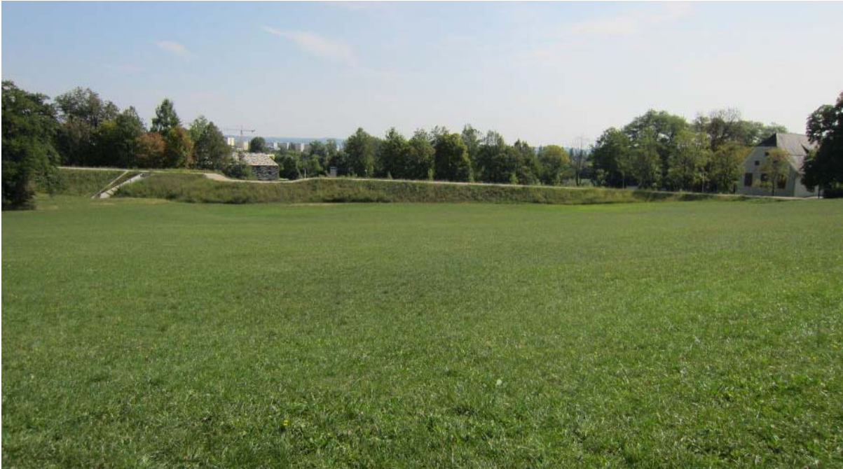
Abbildung 4: Hochwasserrückhaltebecken Gabriachbach Graz (Stadt Graz, 2014)
