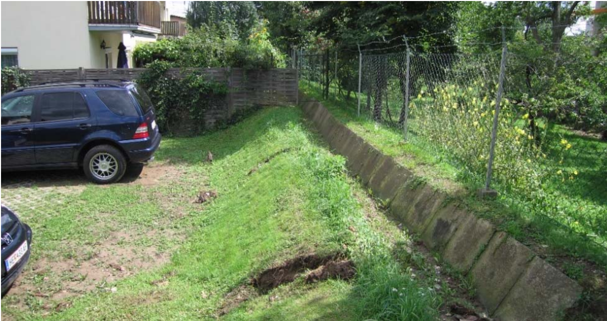
Abbildung 20: Ursprünglicher Bachverlauf ab der Krottendorferstraße – Blickrichtung bachab (Sackl, 2006)
