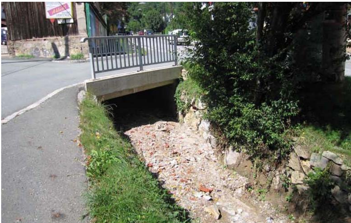
Abbildung 22: Brücke Josef-Schwarz-Weg, Blick bachauf, Anlandungen (Hydroconsult, 2005)
