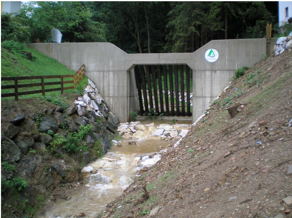
Abbildung 39: Geschiebesperre, Blickrichtung bachauf (Egger-Schinnerl, 2010)
