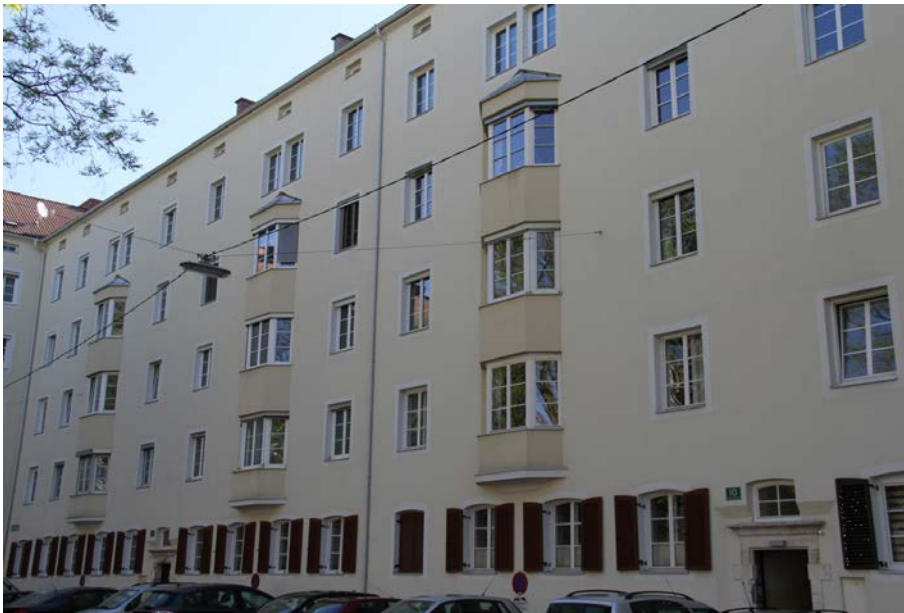
Abbildung 66: Beispiel eines bereits sanierten Objektes aus der Zwischenkriegszeit (Autor)
