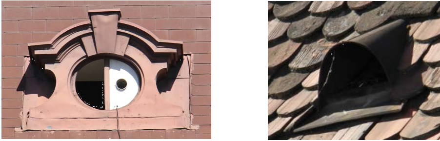
Abbildung 44: Mansardengaube links und Ochsenauge bzw. Froschmaul aus Blech rechts (Autor)
