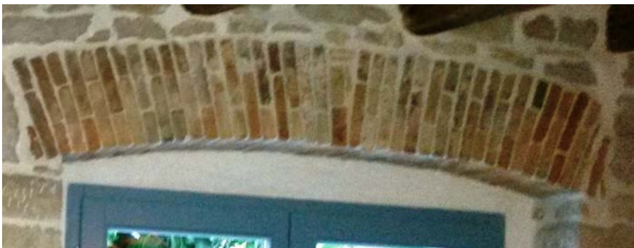
Abbildung 21: gemauerter scheinrechter Bogen b \sim 140 cm (Autor)
