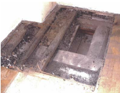
Abbildung 56: Öffnung einer Tramdecke von oben (Autor anonym)
