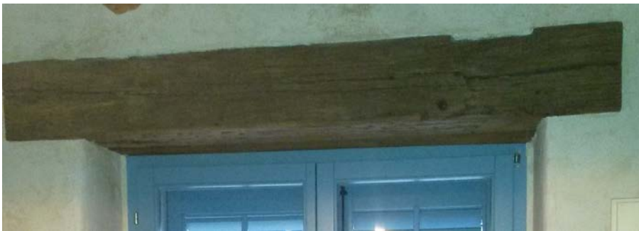
Abbildung 20: Innenansicht einer Holzüberlage aus Eichenholz (Autor)
