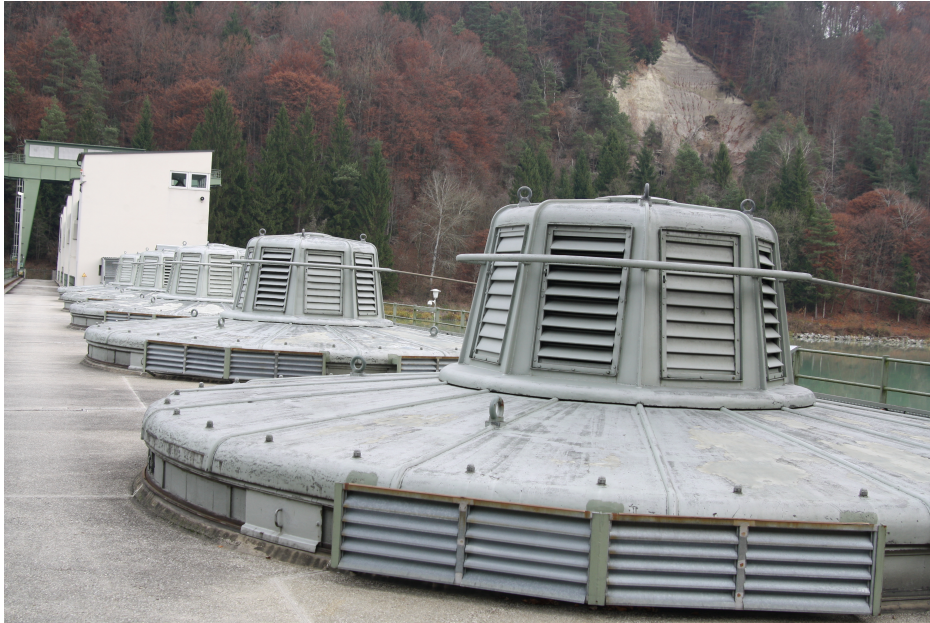
Abbildung 1.5.: Im Hintergrund: Abbröckelnder Hang-Bereich an der rechten Uferseite.
