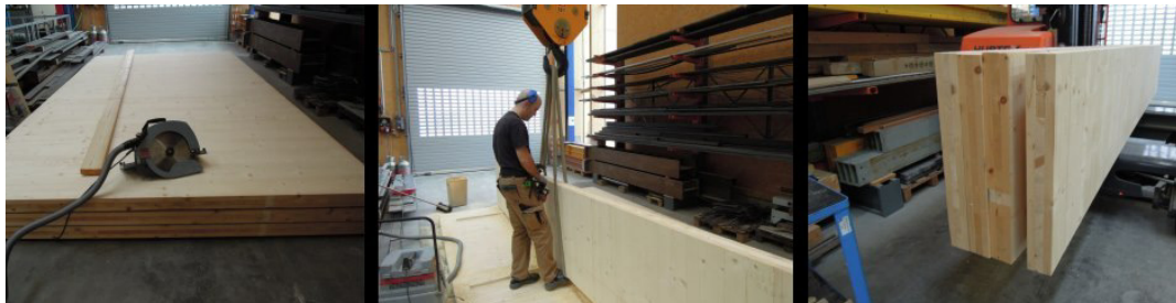
Abb. 2.7 Fotostrecke Teilung Wände
