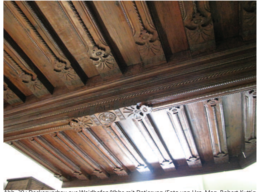
Abb. 39.: Deckenverbau aus Waidhofen/Ybbs mit Datierung (Foto von Hrn. Mag. Robert Kuttig (Bauforscher))
