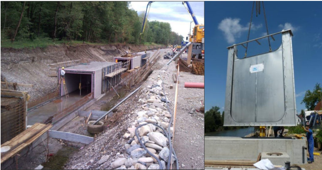
Abbildung 2-35: Bau des ZSK und Montage eines Kaskadenwehres (Kainz et al., 2011)
