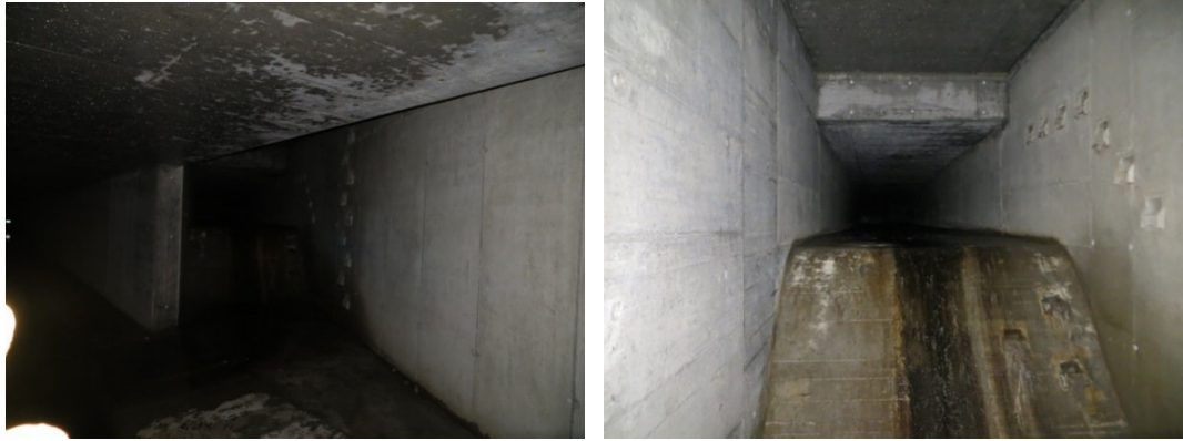
Abbildung 2-38: Einmündung des Entlastungskanals „B25“ in den bestehenden Teil des ZSK
