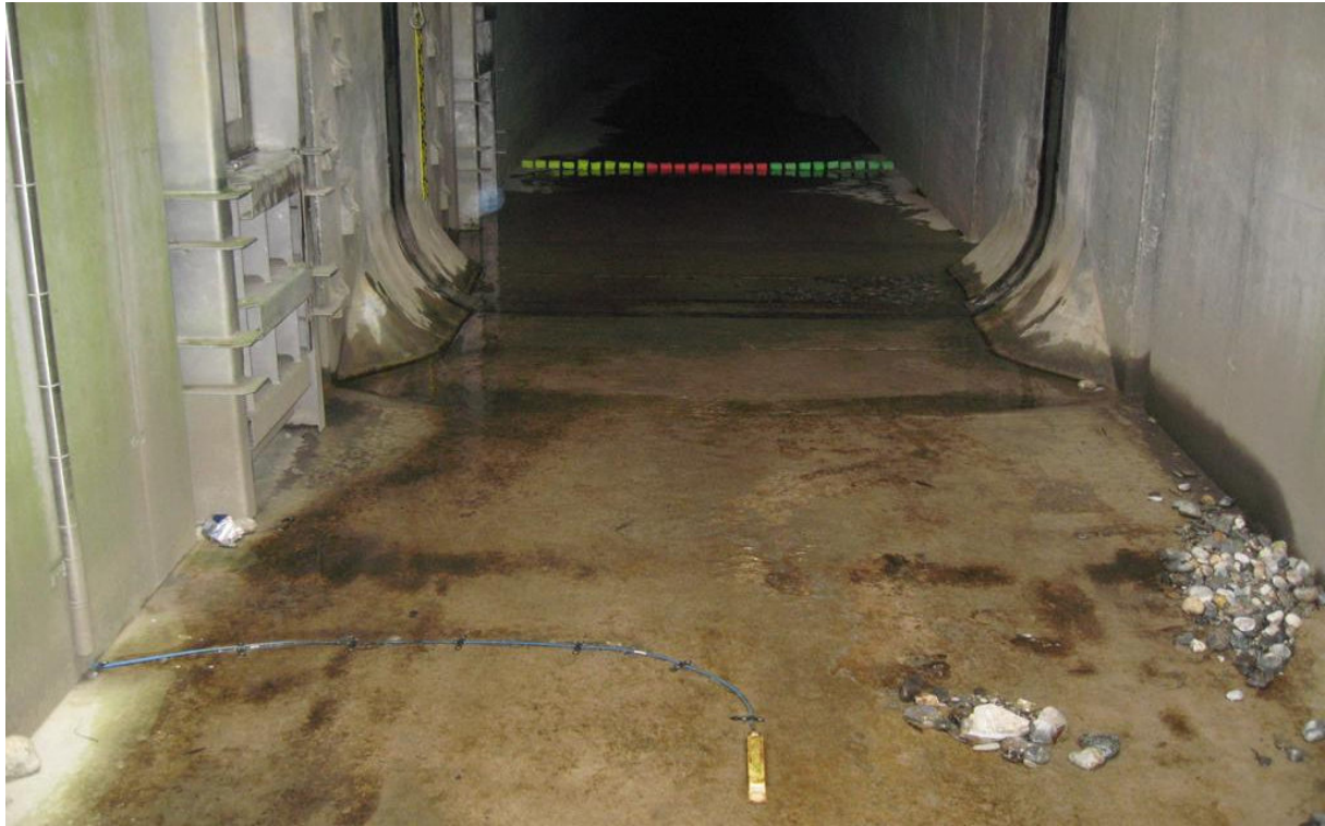
Abbildung 4-3: Wehrbauwerk KS2 mit eingebrachten Sedimentsteinen – dreifärbig markiert
