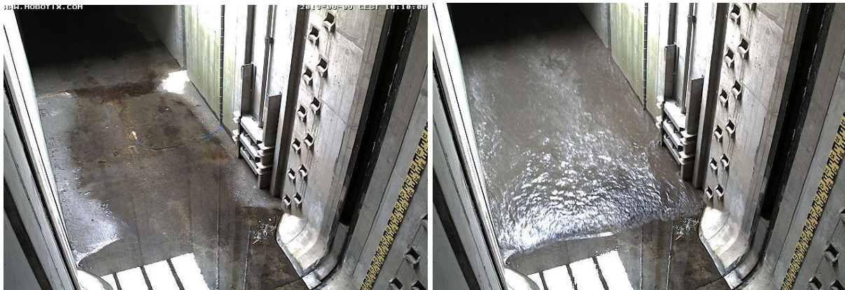
Abbildung 4-2: Kameraaufzeichnung am Wehrbauwerk KS2 vor (links) bzw. beim Eintreffen (rechts) einer Spülwelle (Holding Graz, 2011)
