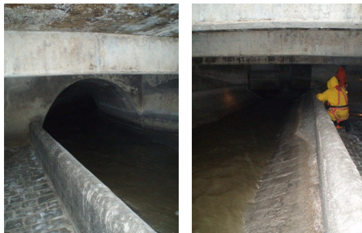
Abbildung 2-37: Zulaufkanal zum „B25“ (Bild links) und Überlaufschwelle (Kainz und Gruber, 2006)
