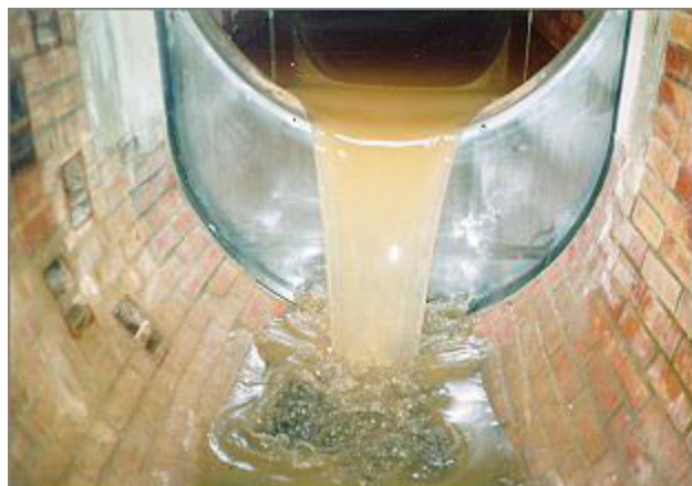
Abbildung 2-34: Kanalspülung durch Kaskadenwehr ( wp.asatechnik.de/kaskadenwehre , Stand 2014-03-22)
