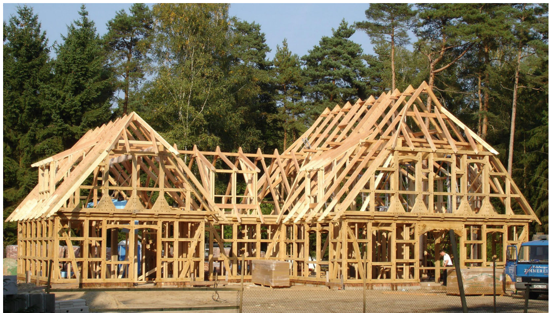
Abb. 1.2 Skelett eines nachgebauten Fachwerkhäuses [11]
