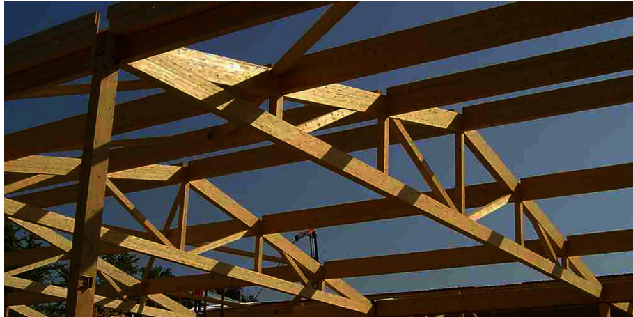
Abb. 1.9 Trapezträger (Sonderform Dreieck) als Hallendach [14]
