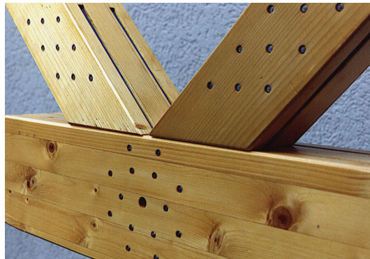
Abb. 2.8 Beispiel für indirekte Verbindung [30]; Stabdübelanschluss in Fachwerken [15]
