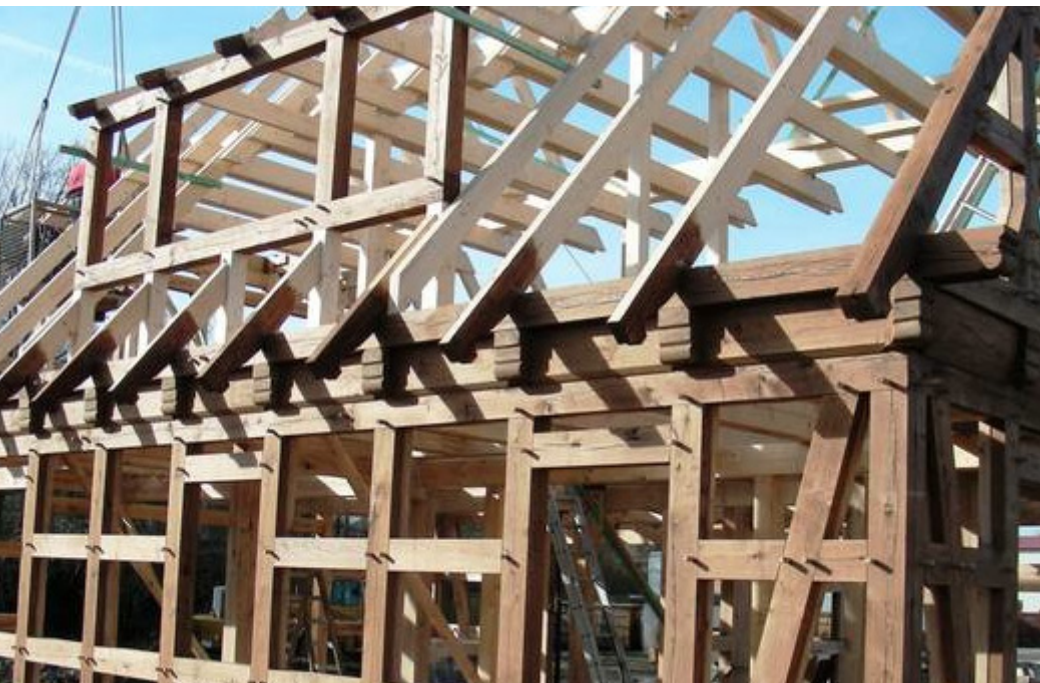
Abb. 1.3 Ansicht eines Fachwerkhouses (oben) [8]; Skelett eines Fachwerkhouses während der Sanierung (unten) [9]
