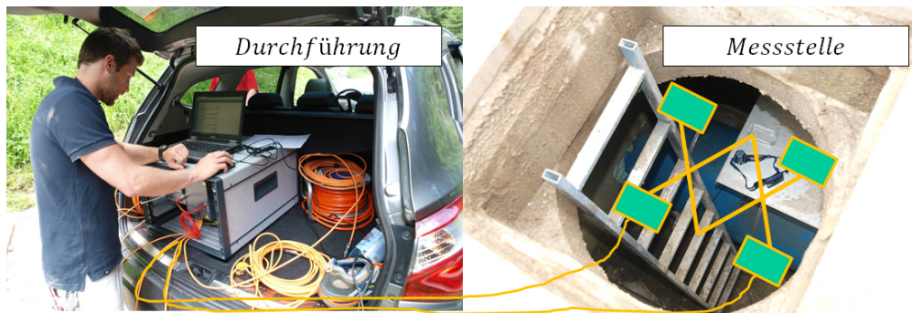
Abbildung 7.2.: Messaufbau und Durchführung der Durchflussmessung.
