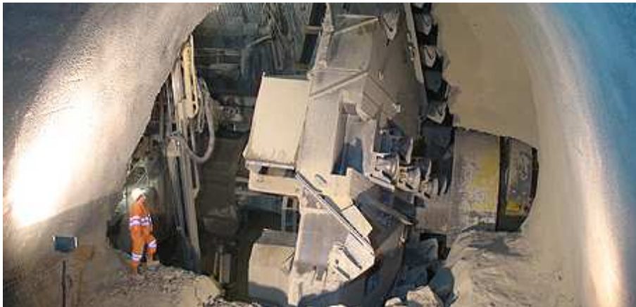
Bild 2.3 Aufweitungs-TBM im Einsatz beim Uetliberg von WIRTH 17
