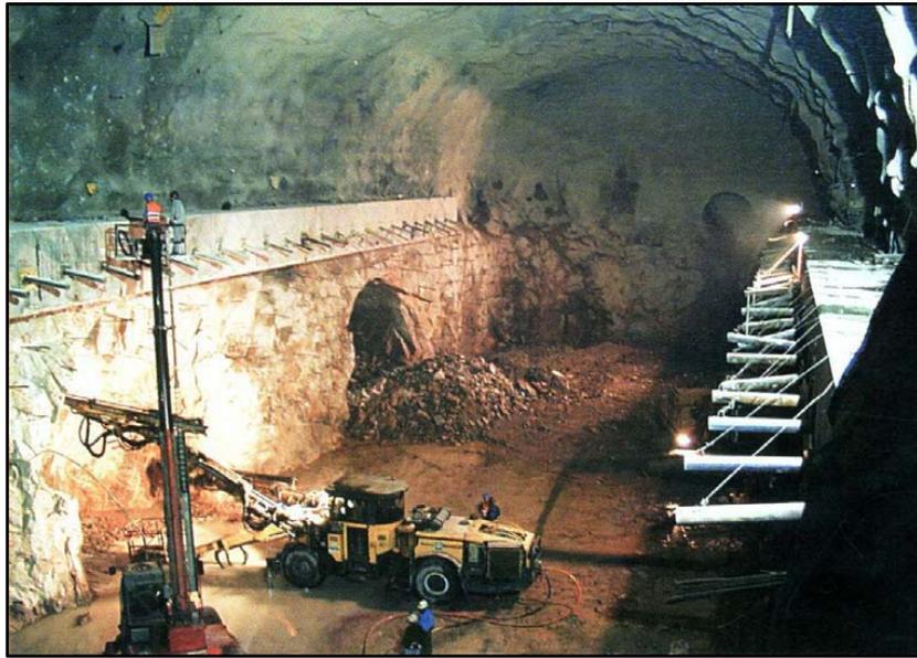
Abbildung 4.14: Herstellung der Krafthauskaverne<sup>42</sup>
