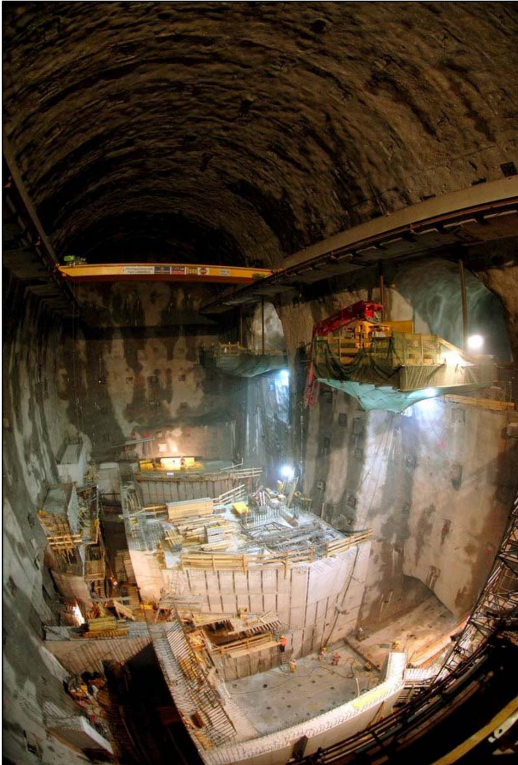
Abbildung 4.38: Bauzustand Kraftkaverne Limberg II<sup>72</sup>
